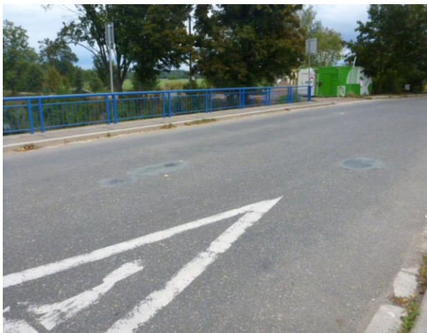
Plošné opravy krytu vozovky
