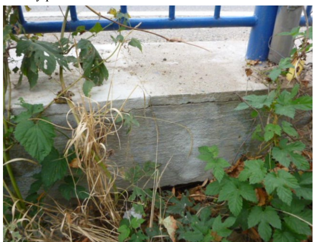
Sanace římsy na začátku vlevo
