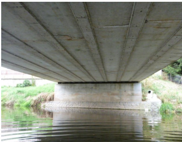
Opěra na začátku mostu
