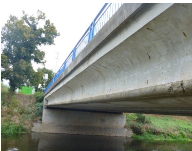
Opěra na konci mostu
