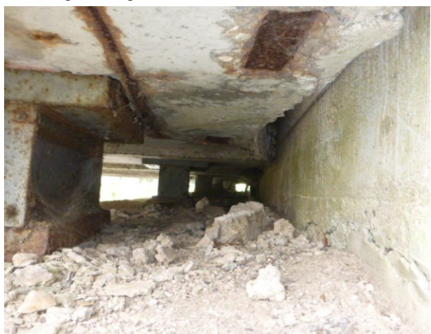
Úložný práh na začátku mostu
