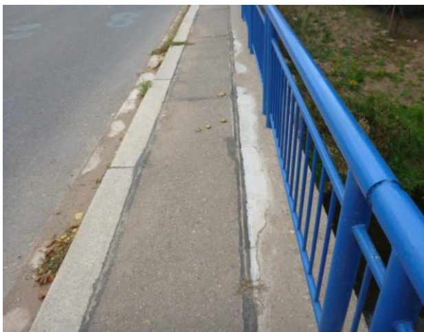
sanace horní plochy římsy vlevo
