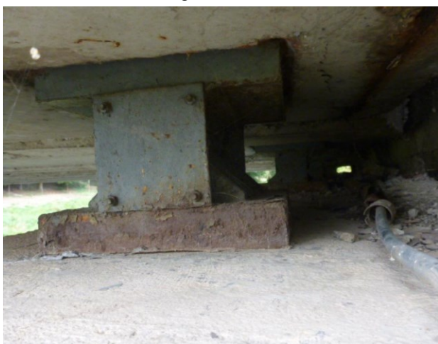
Ložisko na konci mostu vpravo
