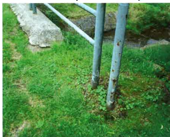
koroze zábradlí
