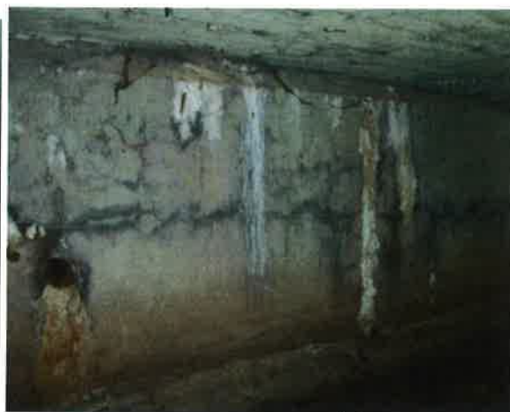
popraskaný povrch opěry a zvodnělé inkrustace v horní části opěry na konci mostu
