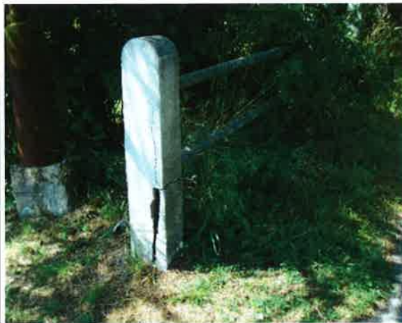
železobetonový sloupek zábradlí na začátku mostu vlevo je značně poškozený
