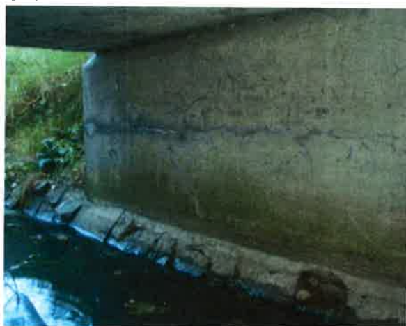
vodorovná zvodnělá prasklina v opěře na začátku mostu ( po pravé straně )
