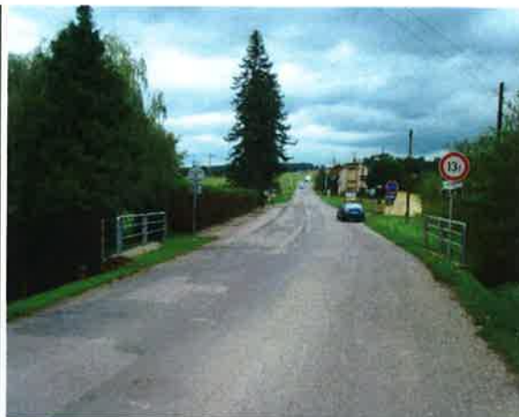
pohled ve směru staničení
