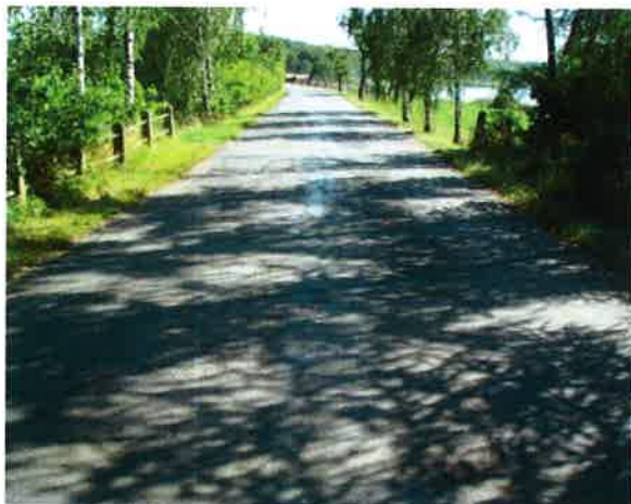
pohled proti směru staničení
