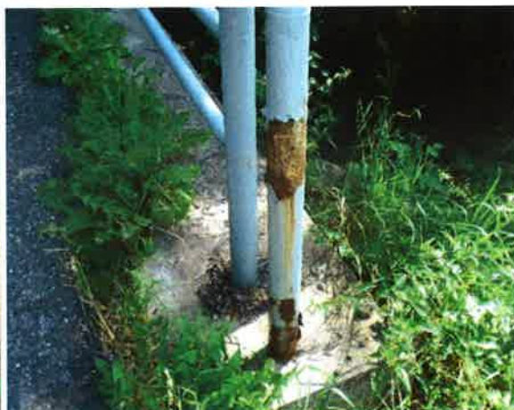
korodující zábradlí
