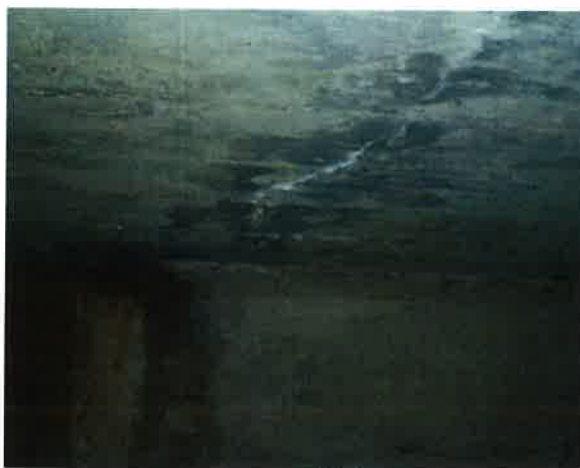
podélná proteklá trhlina na podhledu mostovky NK u opěry na konci mostu
