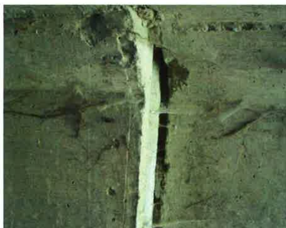
chybějící spárování mezi BR
