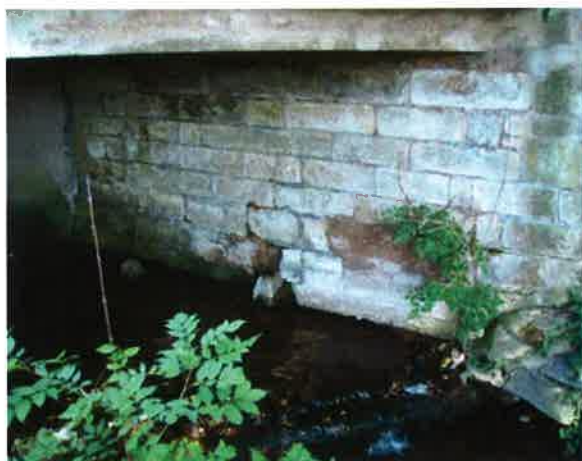
kamenná opěra na konci mostu
