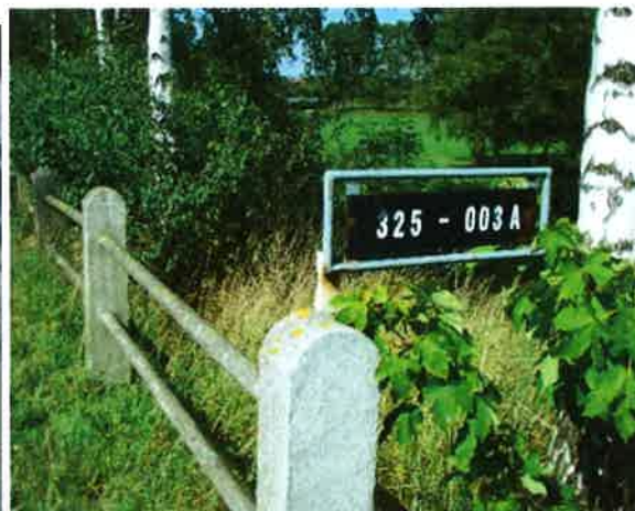
mírně zrezivělé evidenční číslo na začátku mostu vpravo
