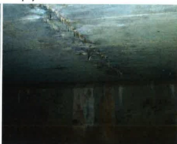
detail praskliny podhledu NK s vápenitými inkrustacemi a krápníky ( délky až 13 cm )
