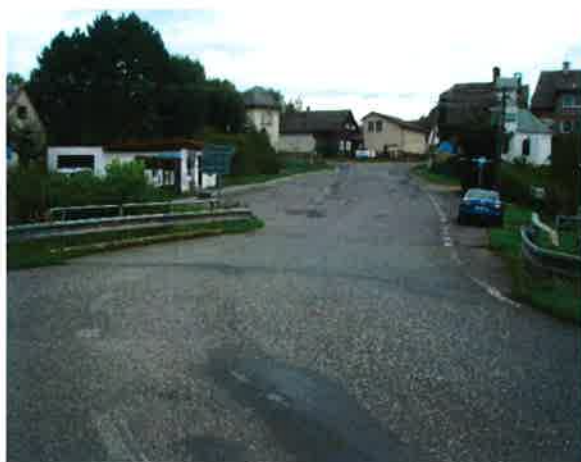
pohled ve směru staničení
