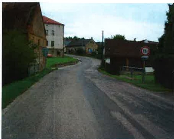
pohled proti směru staničení
