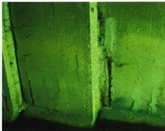
odfouklý beton a obnažená korodující výztuž na stěnách BR
