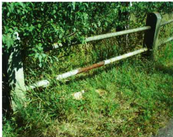
vyhnuté zábradlí po pravé straně mostu ( pohled proti směru staničení )
