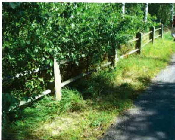
pravá strana mostu ( pohled proti směru staničení )
