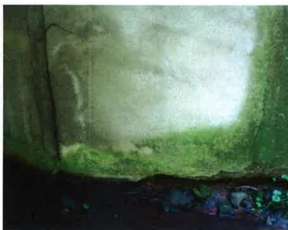
podemleté křídlo na začátku mostu vlevo
