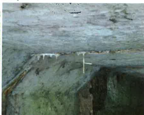
protékající spára mezi BR s váp.usazeninami a krápníky
