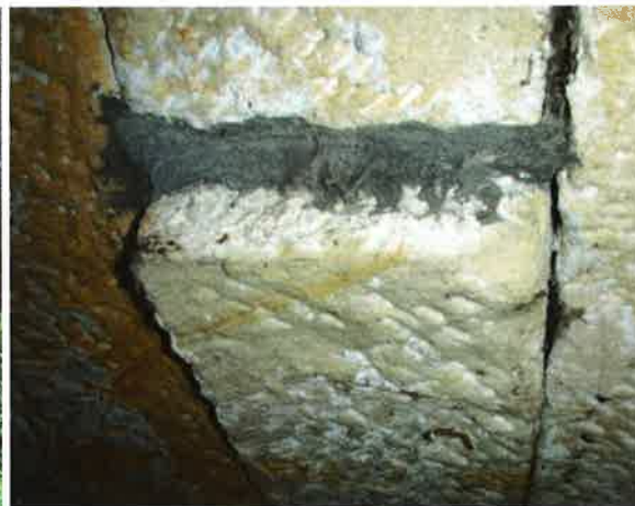
vysunutý kamenný kvádr v pohledu klenby
