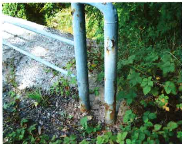
korodující zábradlí
