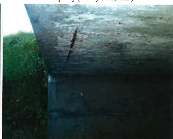
obnažená zkorodovaná podélná výztuž na podhledu desky NK po pravé straně mostu
