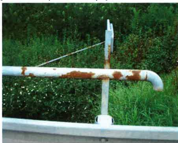
koroze zábradlí
