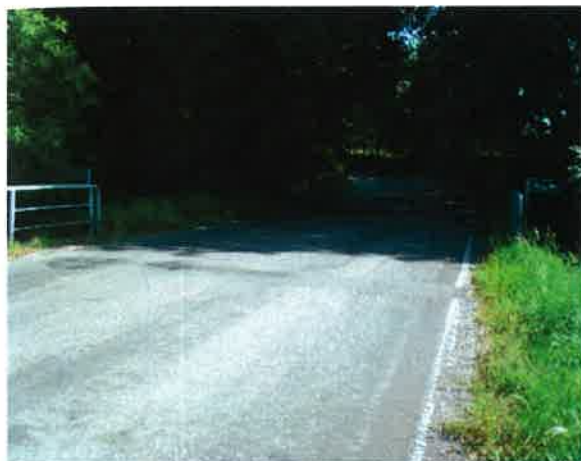
pohled ve směru staničení
