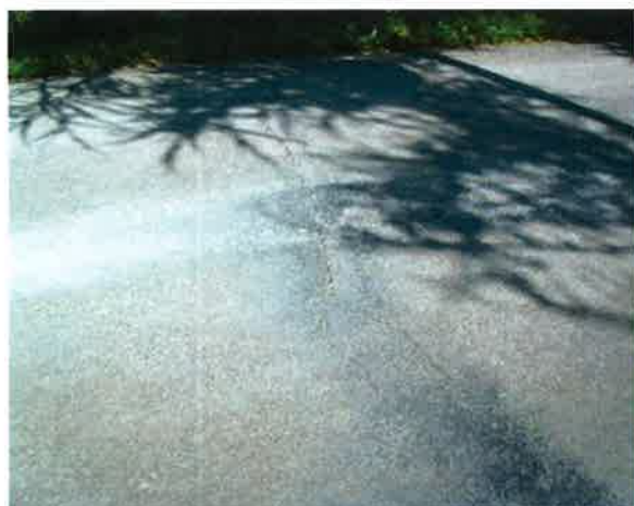
příčná (opravená ) trhlina ve vozovce na začátku mostu
