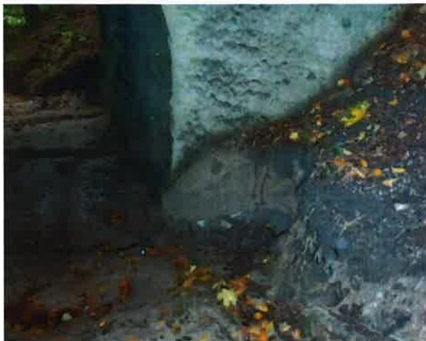
podemleté křídlo na konci mostu vpravo
