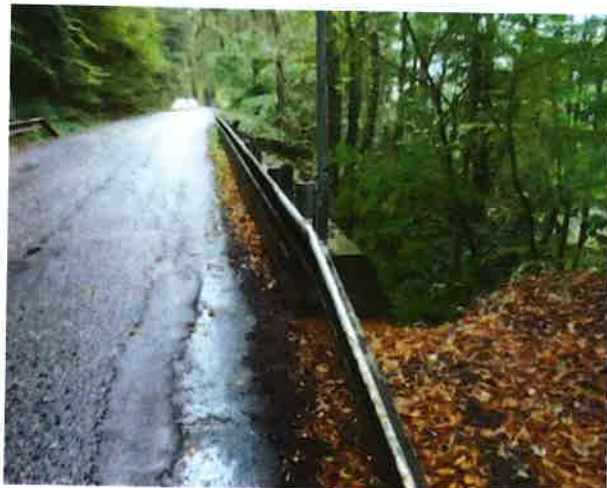
pravá strana mostu
