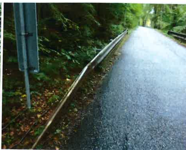
levá strana mostu
