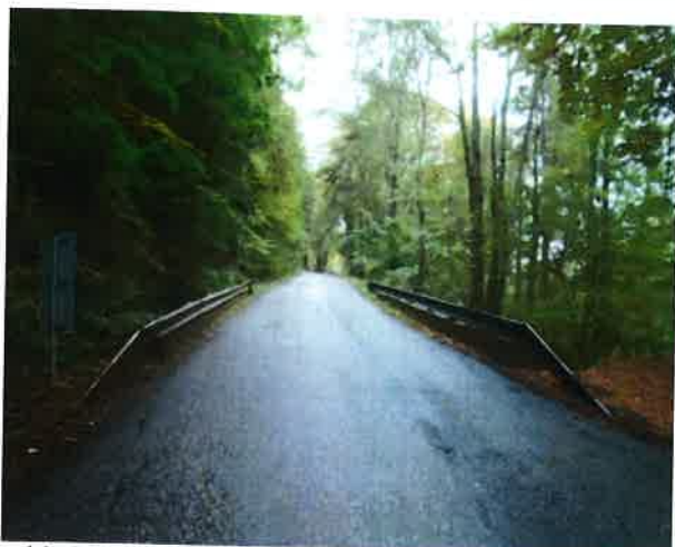
pohled ve směru staničení
