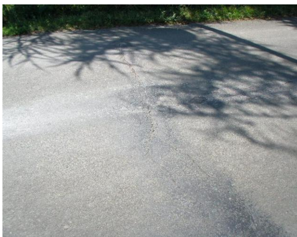
příčná (opravená ) trhlina ve vozovce na začátku mostu
