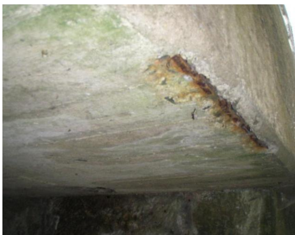
obnažená zkorodovaná výztuž na hraně NK vpravo
