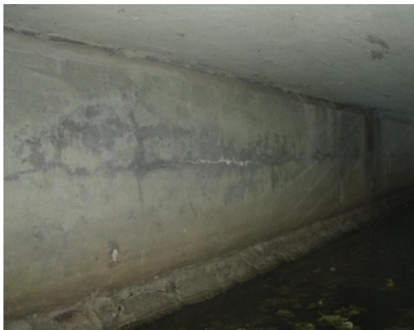
vodorovná zvodnělá trhlina v opěře na konci mostu
