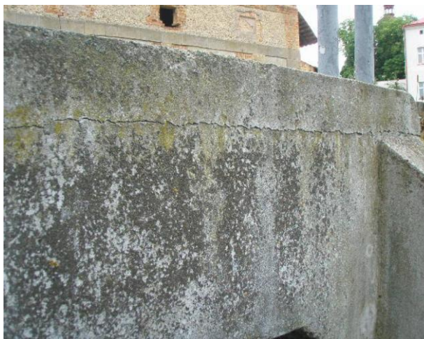
vodorovná trhlina v místě nadbetonování římsy
