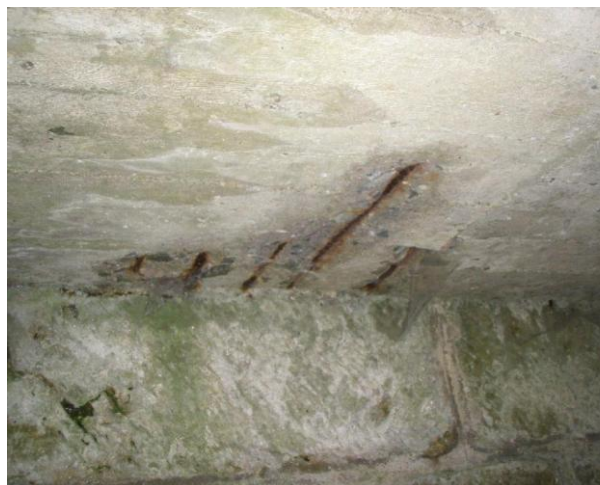
obnažená zkorodovaná výztuž na podhledu NK
