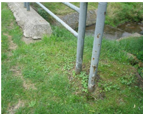
koroze zábradlí
