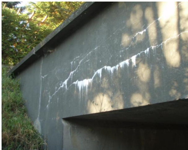
vodorovné protékající trhliny v parapetní zídce NK po levé straně mostu
