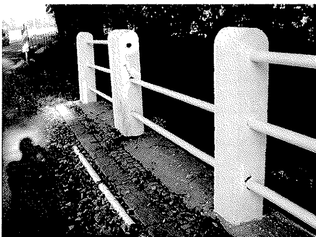
chybějící vodorovné madlo v 6-tém poli po pravé straně
