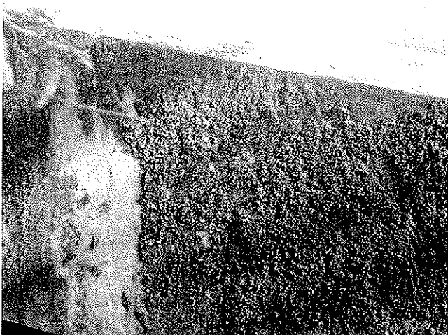
uchycená vegetace na boku římsy
