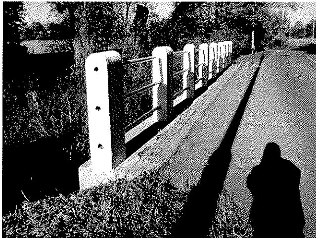
levá strana mostu
