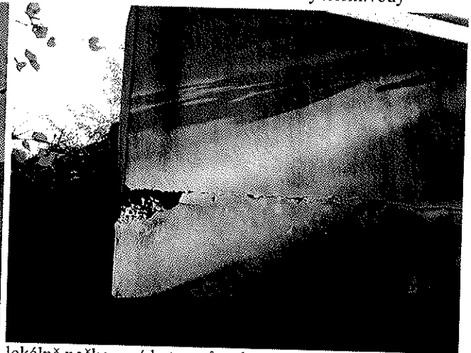
lokálně poškozený beton původní římsy nad křídlem na konci mostu vlevo
