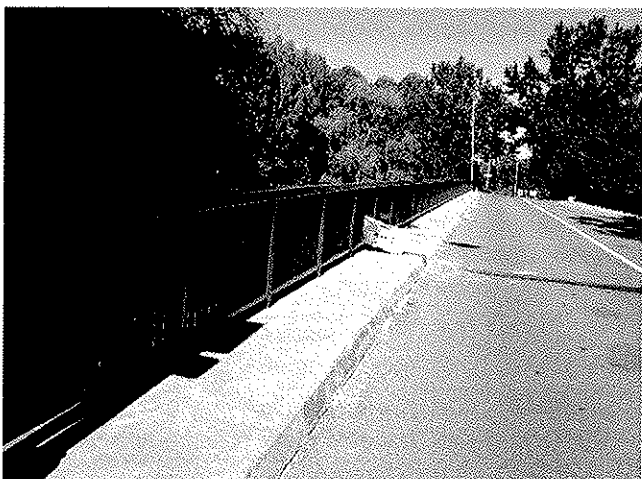
levá strana mostu
