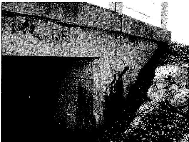
všesměrné (převážně vodorovné) praskliny v omítkce pravého rohu opěry a křídla na konci mostu vpravo
