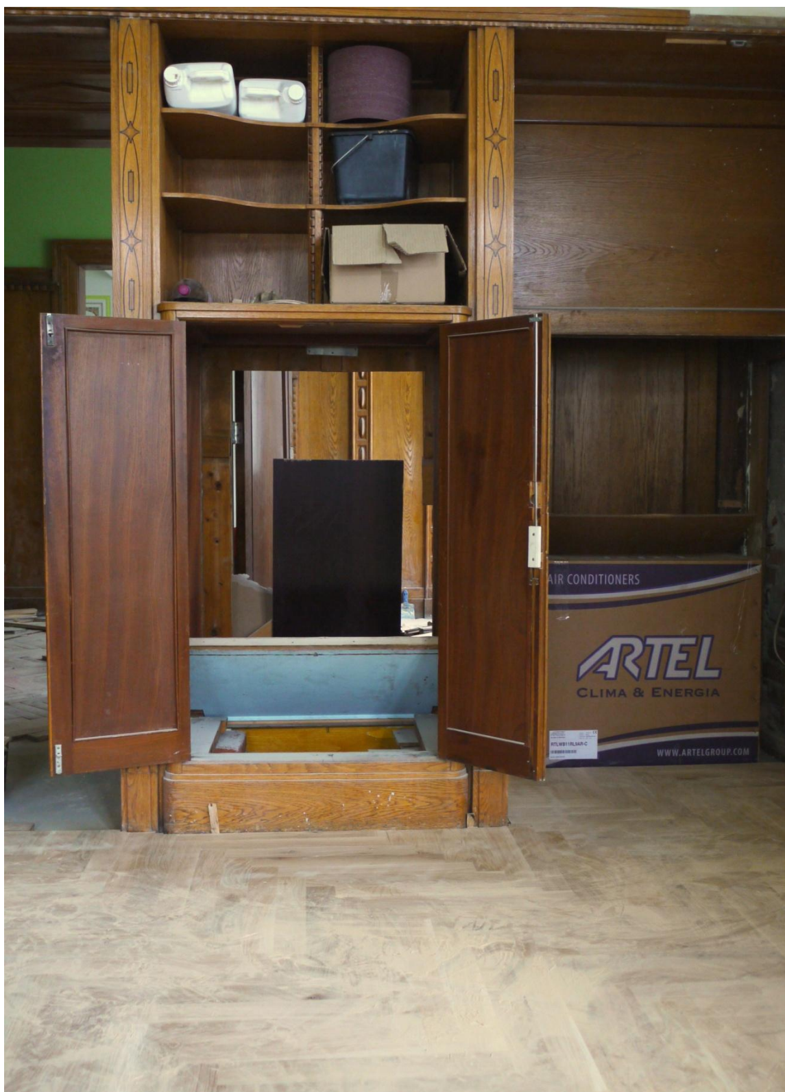
Obr. č. 2. Stav při průzkumu – vestavěná skříň s policemi – celkový pohled Jednotlivé skříňe mají společnou konstrukci, která je rozdělená příčkami /stěnami/ na více samostatných částí. Části vnitřního členění byly v souvislosti se stavebními úpravami odstraněny. Není zřejmé, do jakého stavu budou skříňe navraceny. Ve skříni chybí police. Dno je nahrazeno deskou z dřevotřísky.
