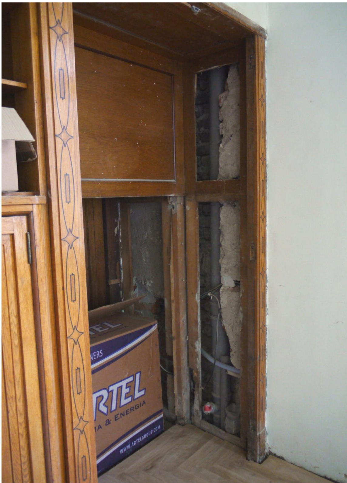
Obr. č. 9. Stav při průzkumu – vestavěná skříň /pravá/ – celkový pohled Vestavěná skříň je na pravém kraji stěny. Jednotlivé skříně mají společnou konstrukci, která je rozdělená příčkami /stěnami/ na více samostatných částí. Části vnitřního členění u pravé skříně byly v souvislosti se stavebními úpravami odstraněny. Není zřejmé, do jakého stavu bude skříň navracena. Ve skříní chybí police, dveře jsou demontované a odnesené.
