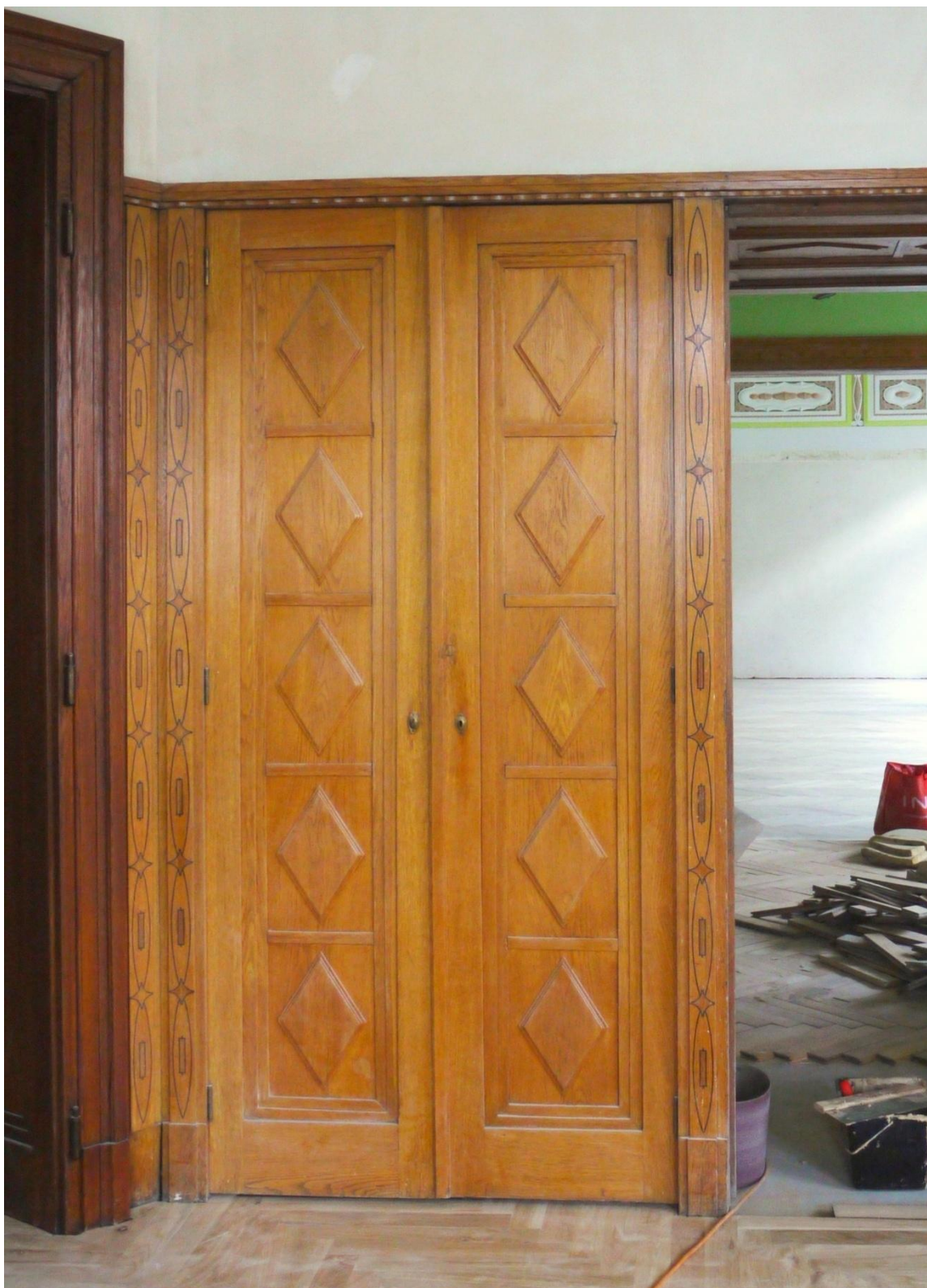
Obr. č. 2. Stav při průzkumu – vestavěná skříň /levá/ – celkový pohled Vestavěná skříň z levého kraje stěny. Tato skříň ani její části nebyly v souvislosti se stavebními úpravami demontovány. Povrch je silně znečištěný, zejména na hranách je dýhování odřené, v ploše je řada drobných poškození. U skříně chybí zámek, v zavřené poloze drží dveře dodatečně namontované magnety. Soklová část obkladu u levého boku skříně je poškozená.
