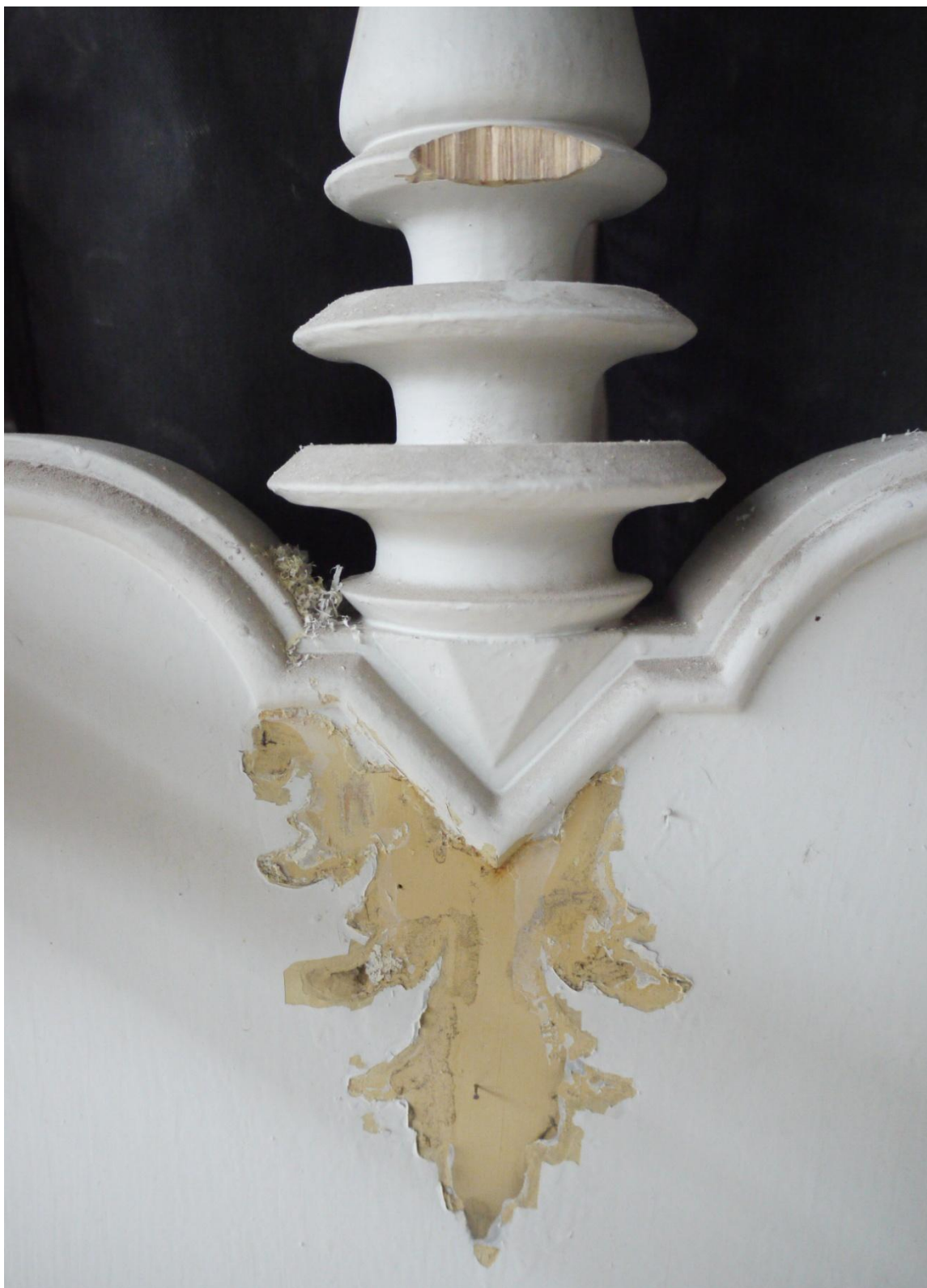
Obr. č. 5. Stav při průzkumu – zábradlí balkonu – detail Starší barevné vrstvy jsou v odstínu lomené /krémové/ bílé. Zdobné prvky byly natřeny zvlášť a na zábradlí byly uchyceny subtilními hřebíčky po povrchové úpravě zábradlí.
