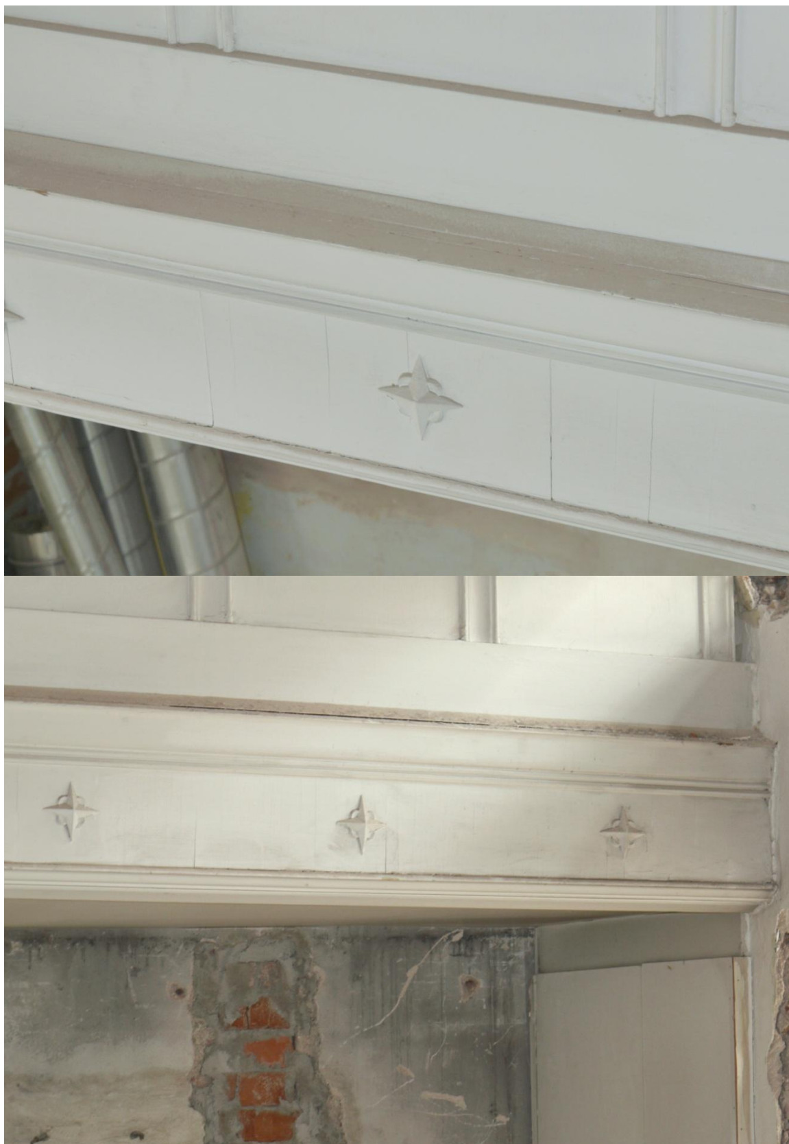
Obr. č. 3+4. Stav při průzkumu – zábradlí balkonu – detail Obklad nosné konstrukce je ve spojích nerovný. Výzdoba se skládá z profilových lišt a řezb čtyřcípých hvězd.
