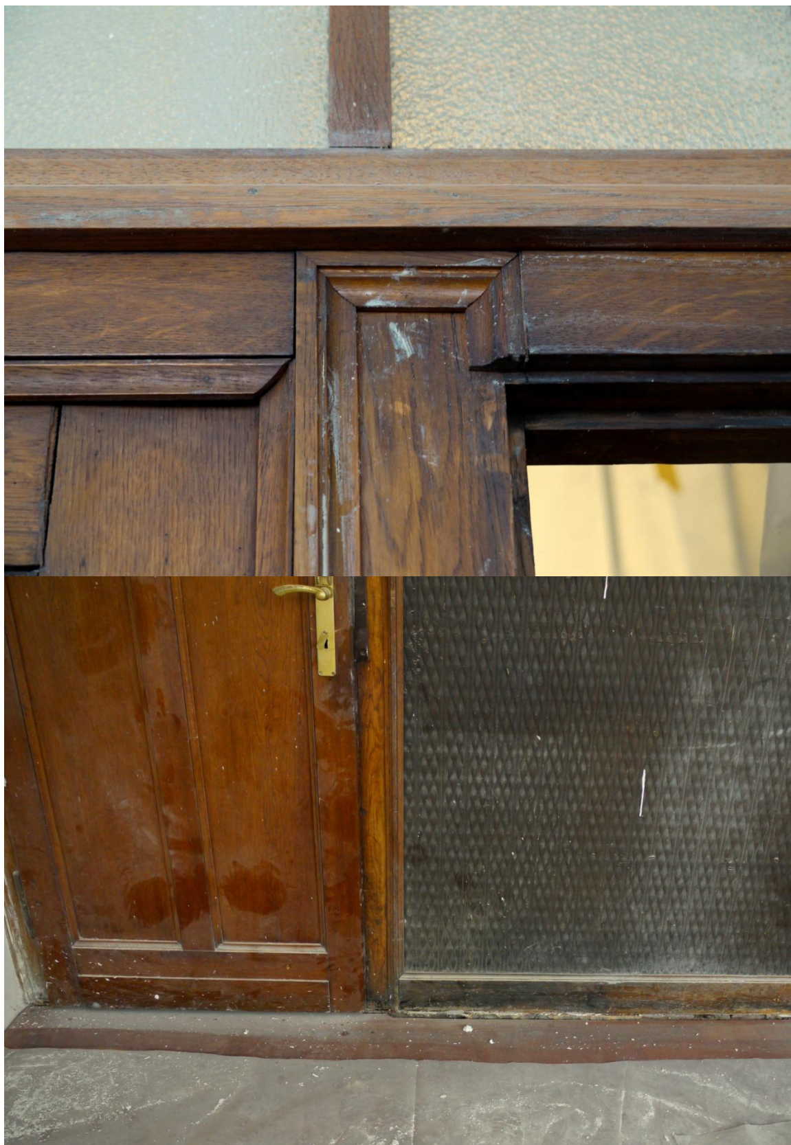
Obr. č. 5+6. Stav při průzkumu – příčka – detail. Příčky mají stejné typy poškození. Povrch je silně znečištěný, lištování je uvolněné, některé lišty jsou nalomené. U podlahy je příčka silně odřená a zčernalá.
