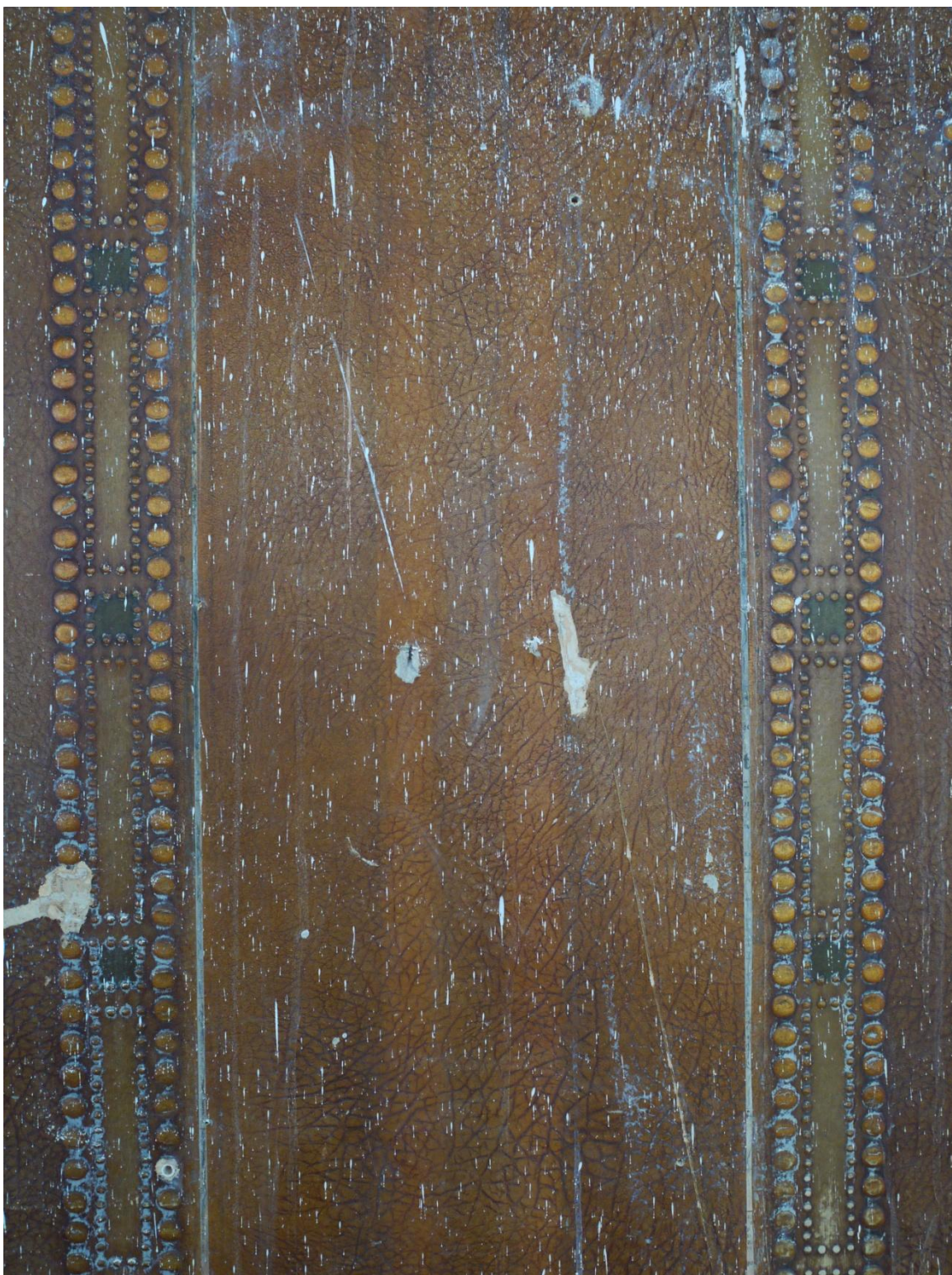
Obr. č. 5. Stav při průzkumu – stěna s tapetou – detail. Jednotlivá pole s tapetami byly opticky odděleny dvojicí subtilních lišt. Lišty byly uchyceny hřebíčky zatlučenými přímo do stěny.
