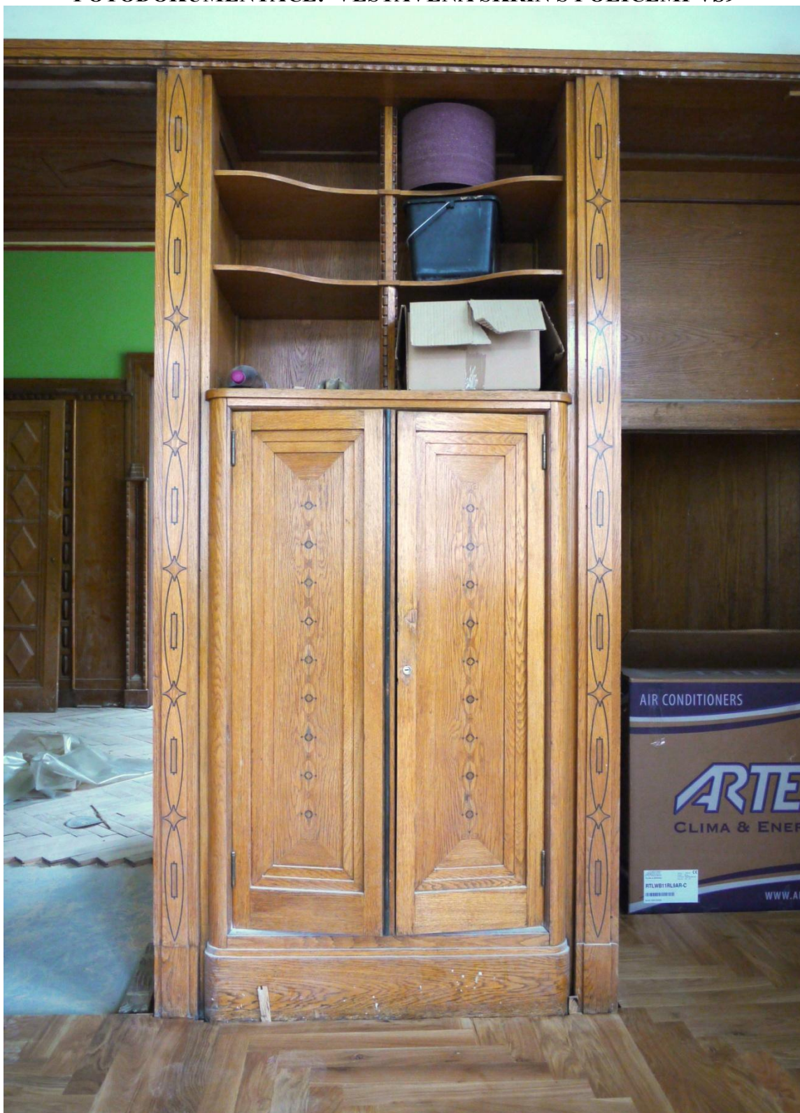
Obr. č. 1. Stav při průzkumu – vestavěná skříň s policemi – celkový pohled U skřínky jsou odřené hrany a v ploše je řada drobných poškození. Některá poškození byla, v minulosti s různým úspěchem opravována. Povedené opravy lze ponechat, nevhodné bude nutné odstranit a nově nahradit. Zámek byl vyměněn a byl odstraněn původní štítek.
