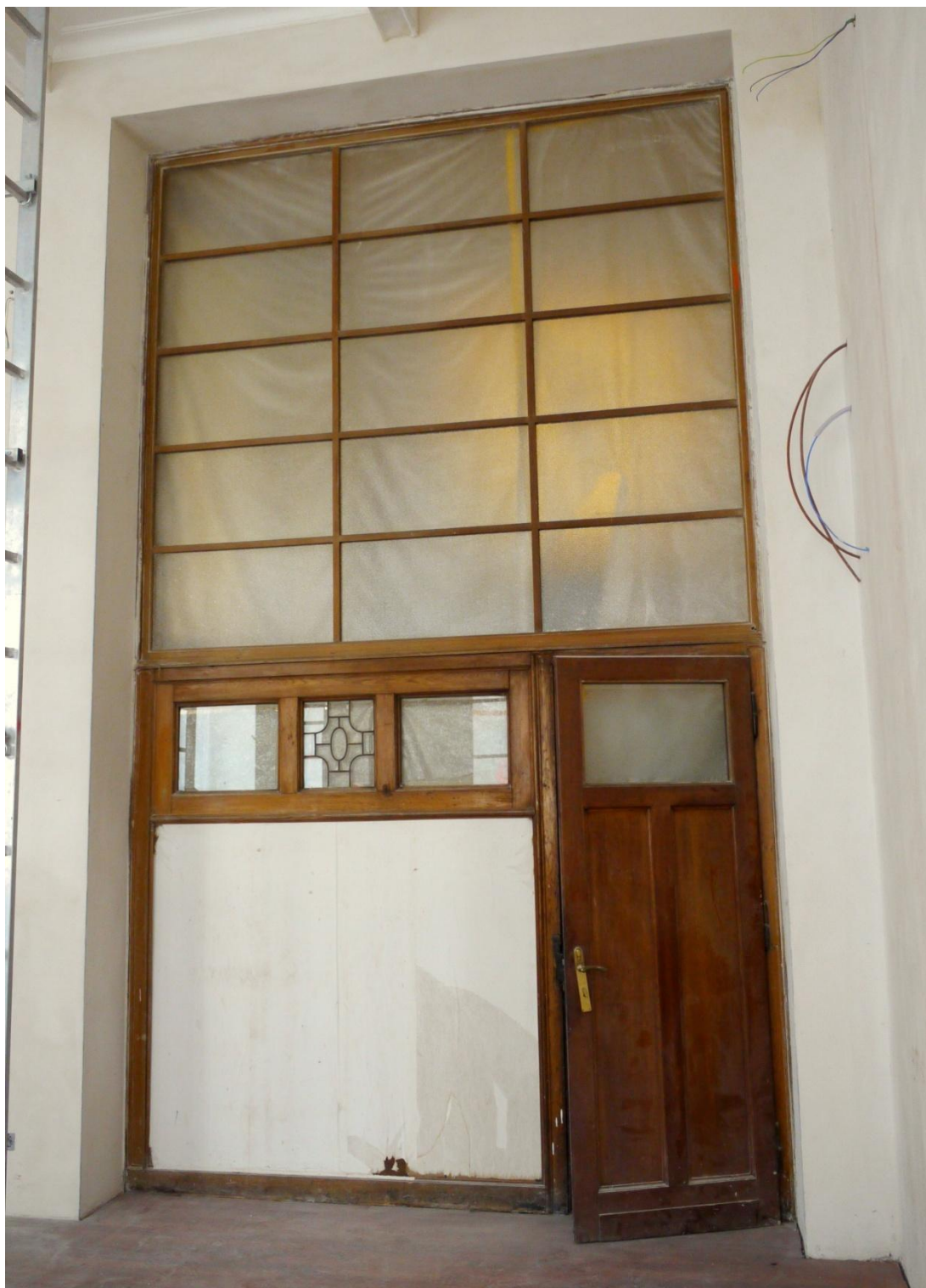
Obr. č. 2. Stav při průzkumu – příčka – celkový pohled. Obě příčky jsou shodné konstrukce. Příčky mají stejná poškození a jejich stav je velmi podobný. Lištování je uvolněné, některé lišty jsou nalomené.
