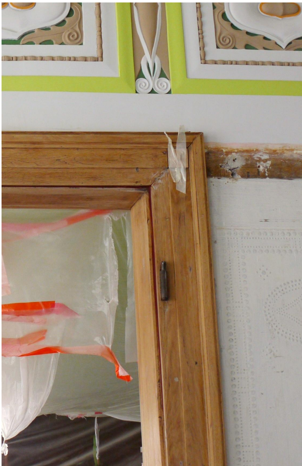
Obr. č. 2. Stav při průzkumu – stěna s tapetou – detail. Na snímku je pohled na jednu ze stěn se dveřmi. Vrchní římsa, rámuující pole s tapetami, byla zřejmě do stejné výšky jako obložka dvevní zárubně.
