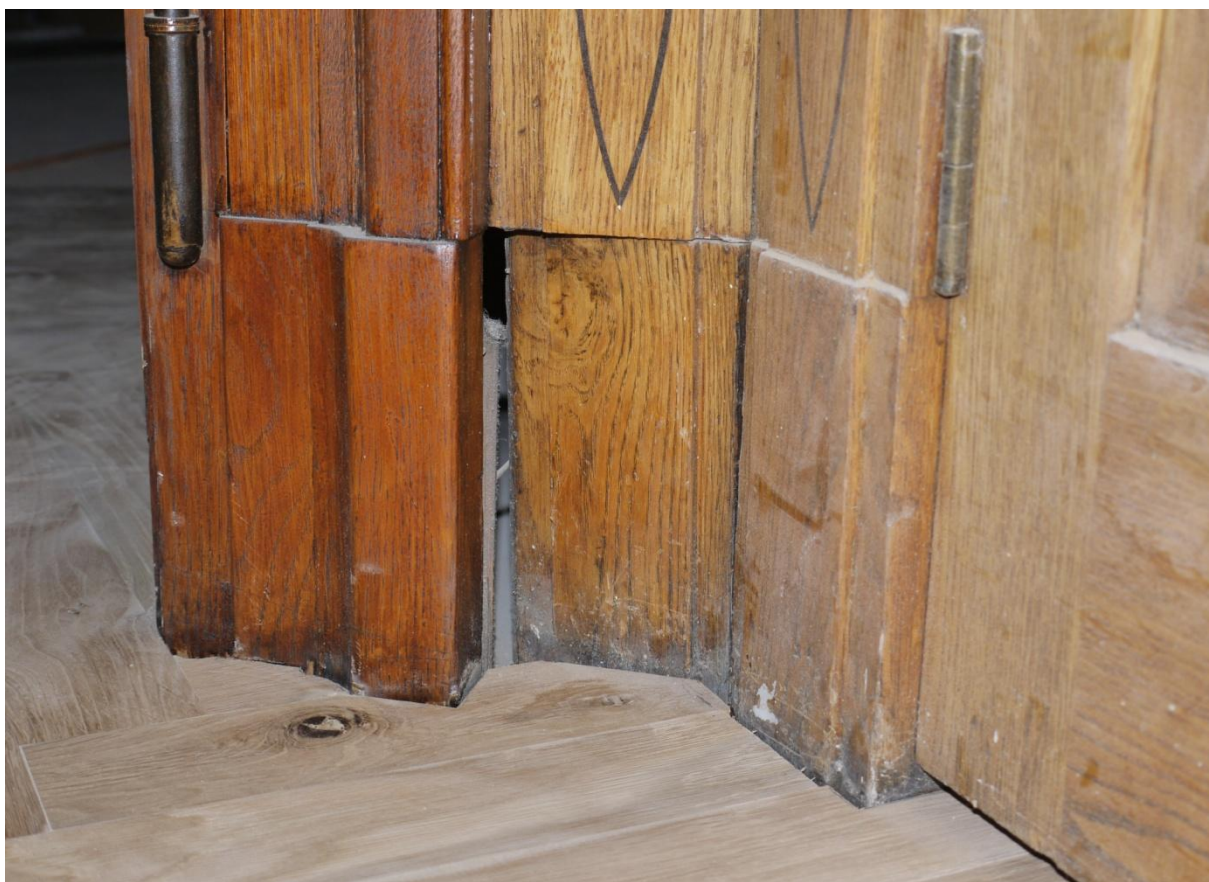
Obr. č. 8. Stav při průzkumu – vestavěná skříň /levá/ – detail Soklová část obkladu u levého boku skříně je poškozená.
