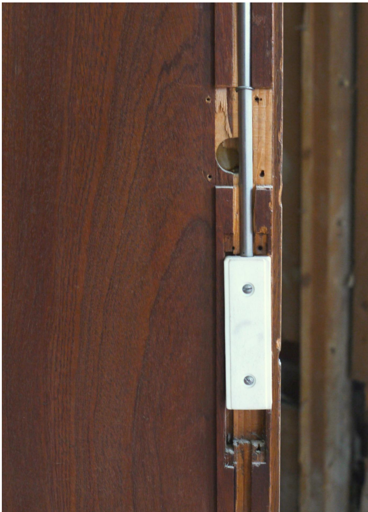
Obr. č. 3. Stav při průzkumu – vestavěná skříň s policemi – detail Zámek byl vyměněn. V souvislosti s výměnou došlo k poškození dvířek a odstranění původního štítku. Původní zámek byl rozvorový, polozapuštěný.
