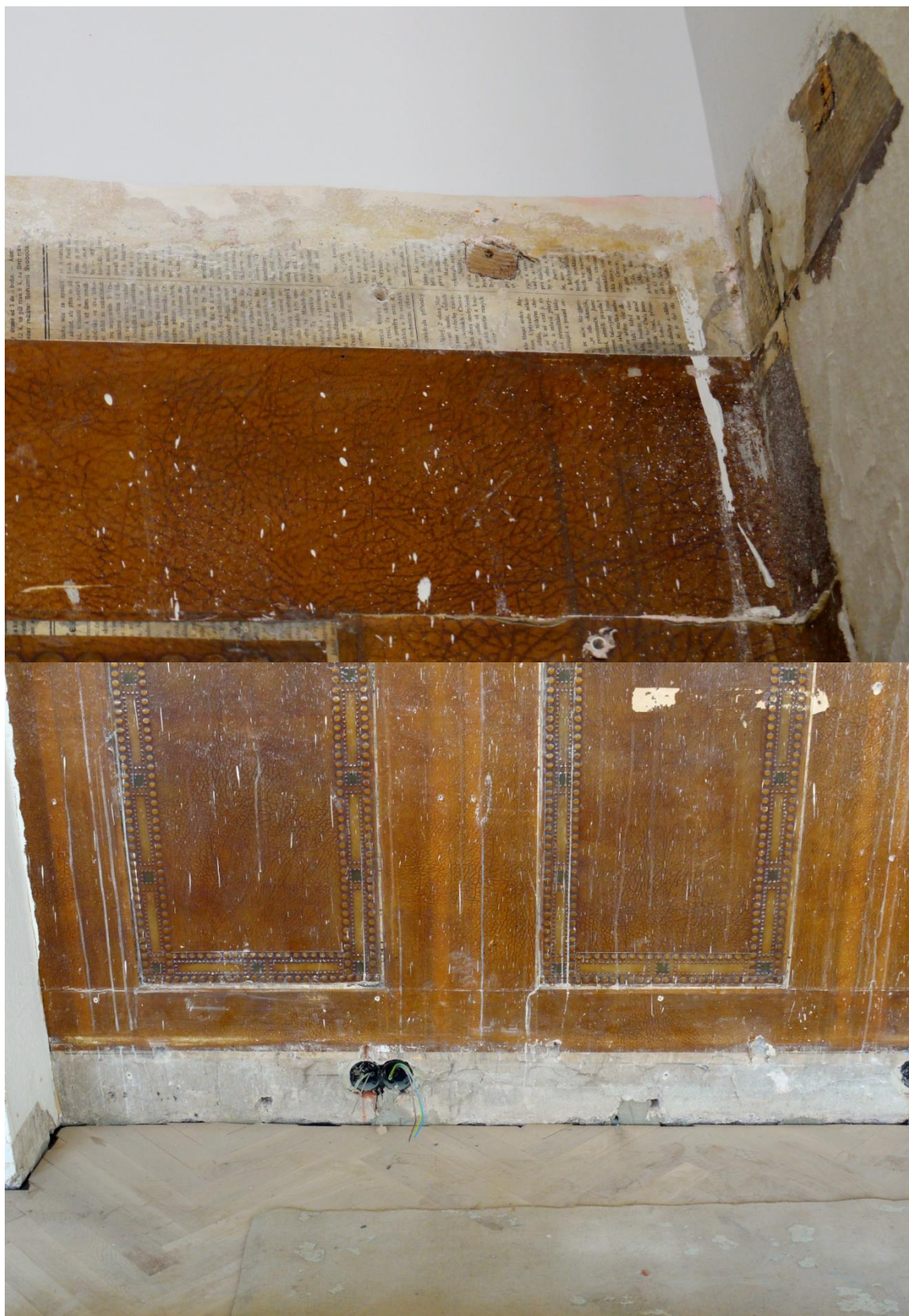
Obr. č. 3+4. Stav při průzkumu – stěna s tapetou – detail. Vrchní římsa, rámuje pole s tapetami, byla uchycena vruty do dřevěných špalíků ve stěně. Část z kotvicích špalíků se dochovala. Soklová část byla zřejmě uchycena obdobně. Zde se ale nacházejí pouze prázdné otvory.
