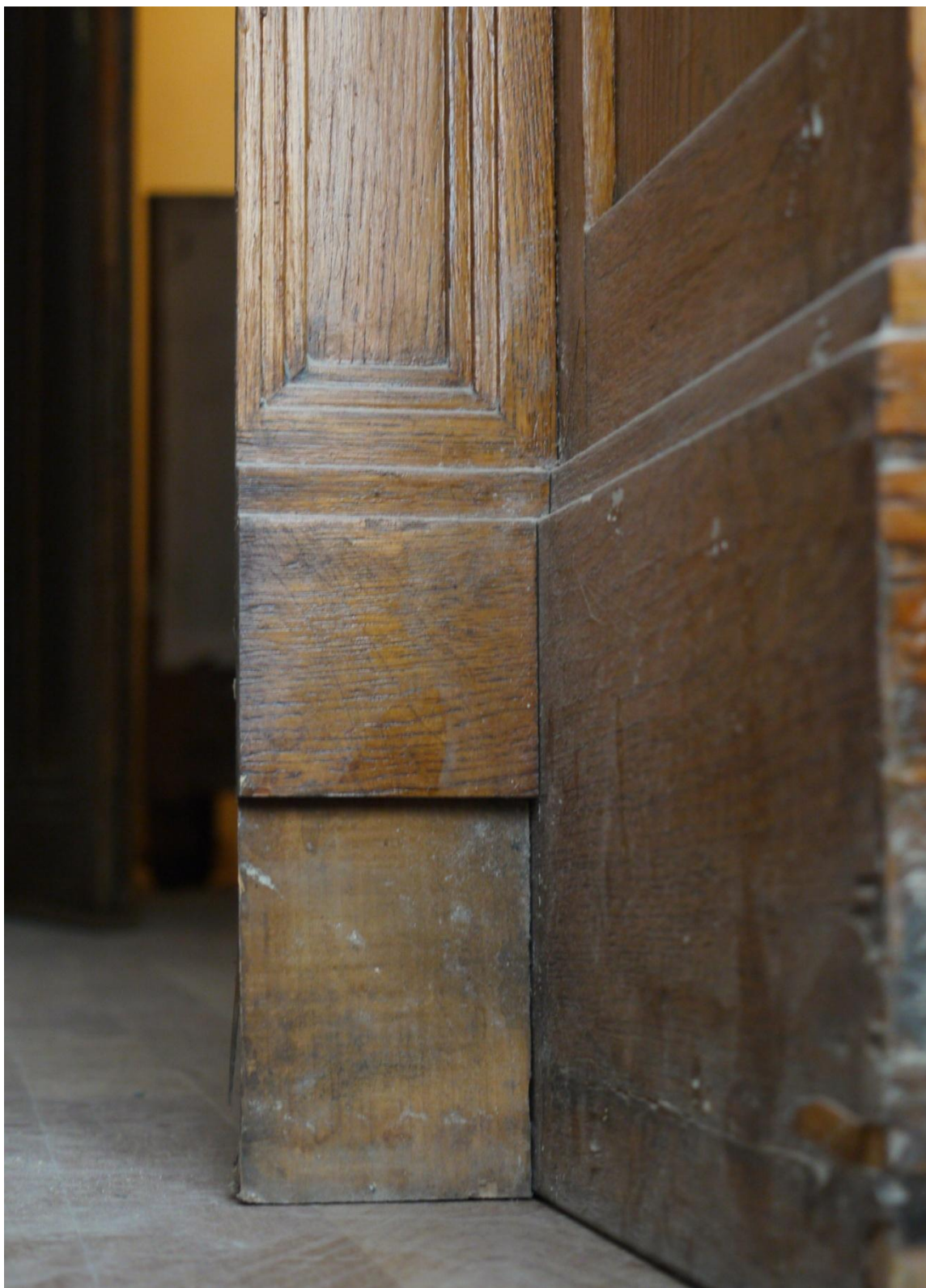
Obr. č. 6. Stav při průzkumu – skříň s policemi – detail Soklové části obou skříní jsou značně poškozené. Kromě dýhování chybí soklové části na zadní desce.
