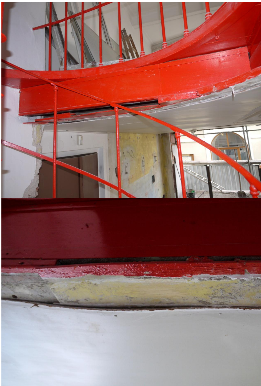
Obr. č. 8. Stav při průzkumu – podbití stropu – detail Strop je podbitý překližkou na dřevěné konstrukci. Přesný stav stropu bude znám až po sejmutí druhotného pobití sololitem. Barevnost byla s největší pravděpodobností shodná se zábradlím.
