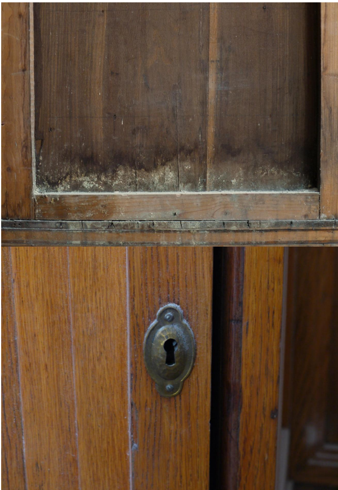
Obr. č. 14+15. Stav při průzkumu – skříň s policemi – detail U jedné ze skříněk je na zádech narušená dřevní hmota vlhkostí. U obou skříní jsou dochované mosazné štítky.
