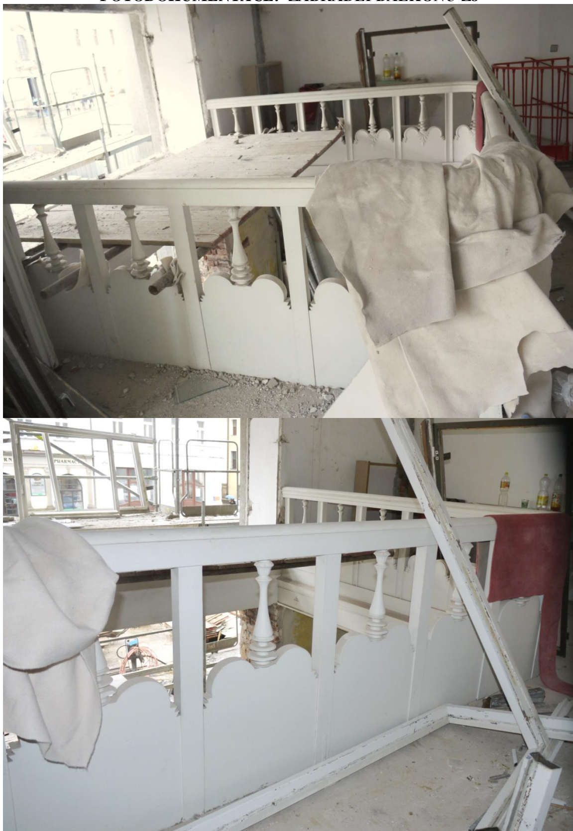
Obr. č. 1. Stav při průzkumu – zábradlí balkonu – celkový pohled Zábradlí obíhá tři stěny komerčního prostoru. Zábradlí je z měkkého dřeva, strop je ze dřeva a překližky. Zábradlí je povrchově upravené krycí barvou.
