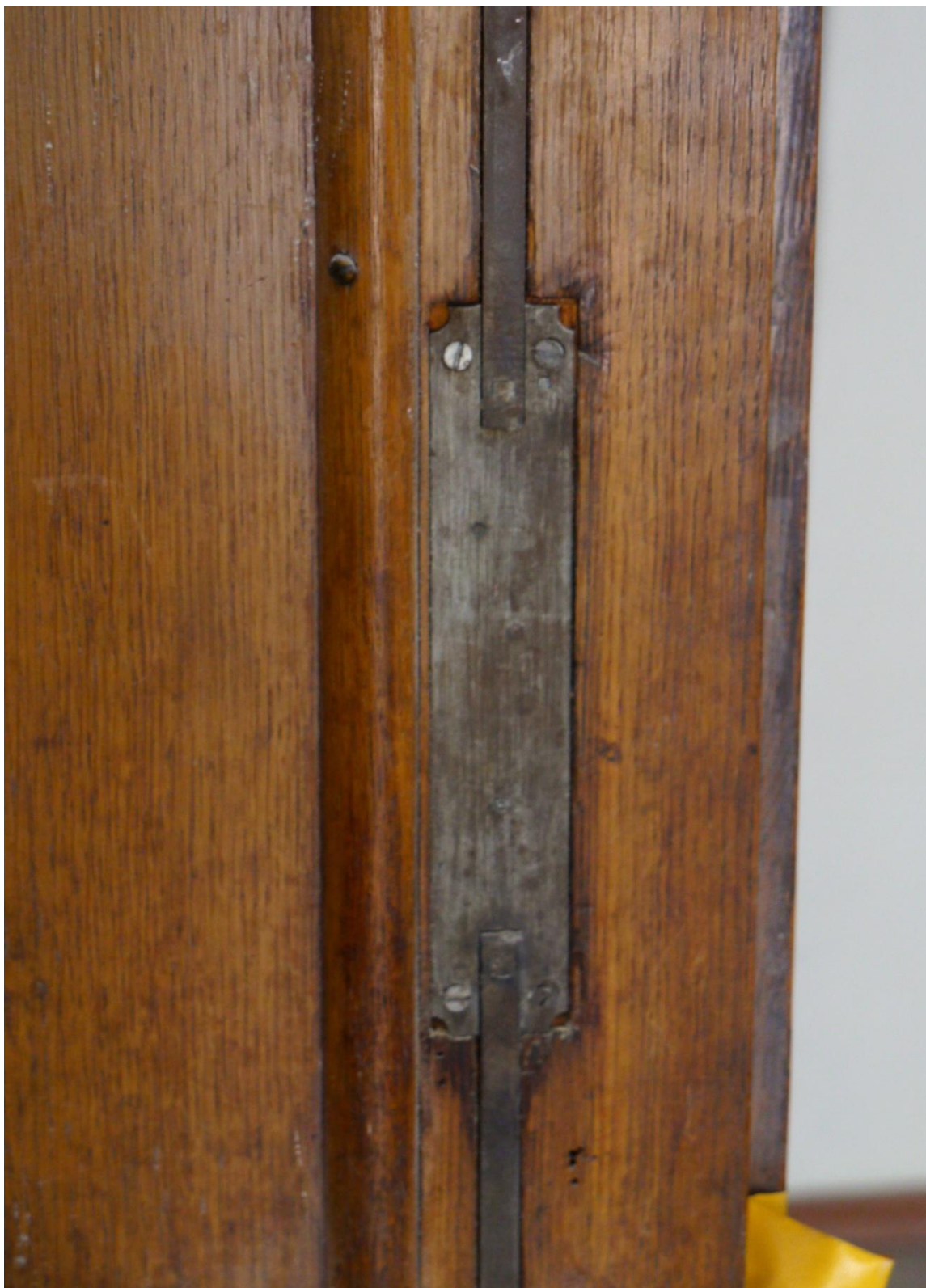
Obr. č. 15. Stav při průzkumu – vestavěná skříň /pravá/ – detail Na dveřích je dochovaný původní zámek. Chybí krycí lišta. Zámek je nefunkční, dveře drží magnet.
