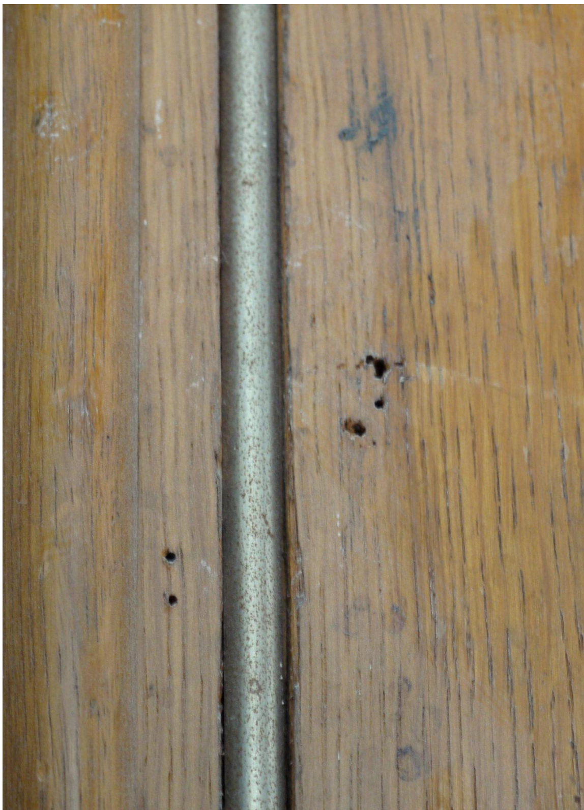
Obr. č. 16. Stav při průzkumu – vestavěná skříň /pravá/ – detail Na dveřích je dochovaný původní zámek. Chybí krycí lišta, která byla uchycená malými vruty. Šířku lišty lze odvodit podle otisku.
