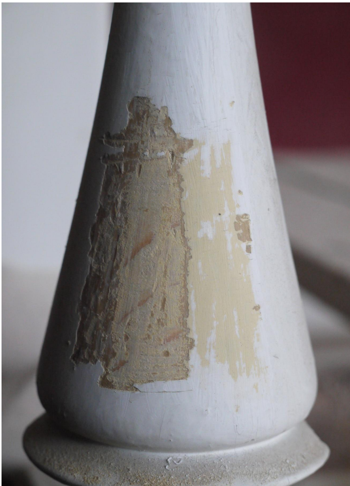
Obr. č. 7. Stav při průzkumu – zábradlí balkonu – detail Na kuželce a dalších místech na zábradlí byly nalezeny shodné vrstvy jako na madle. Celé zábradlí bylo vždy v jednotné barevnosti.
