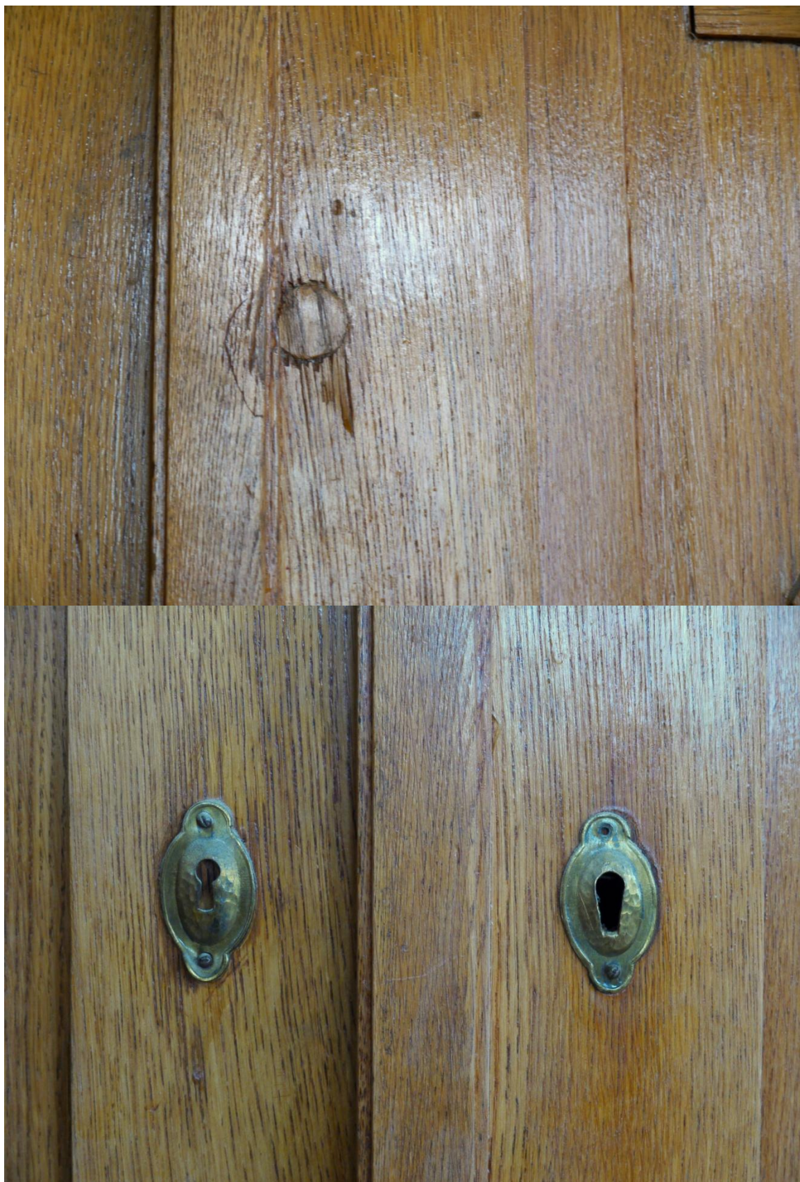
Obr. č. 6+7. Stav při průzkumu – vestavěná skříň /levá/ – detail Chybějící zámek byl dočasně nahrazen. Poškození způsobené montáží nového zámku je částečně opravené. Štítky jsou původní, jeden je slepý.
