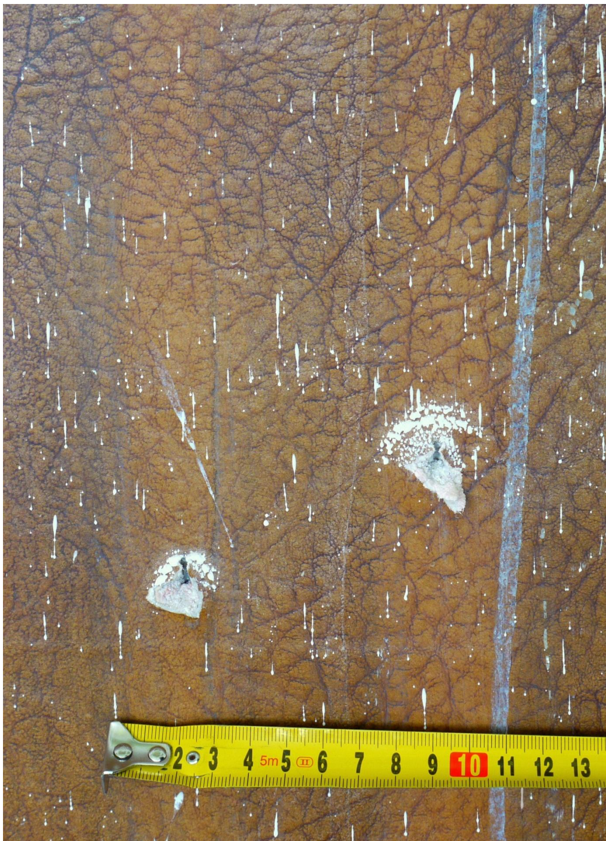
Obr. č. 7. Stav při průzkumu – stěna s tapetou – detail. Jednotlivá pole s tapetami byly opticky odděleny dvojicí subtilních lišt. Zdvojené lišty byly podle otisku široké 2,5 – 3 cm maximálně.
