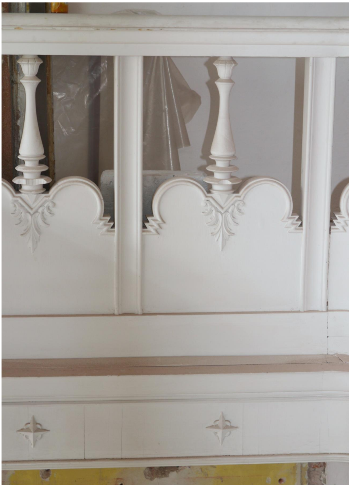
Obr. č. 2. Stav při průzkumu – zábradlí balkonu – celkový pohled Zábradlí obíhá tři stěny komerčního prostoru. Zábradlí je z měkkého dřeva. Jednotlivé výplně jsou zdobené pouze na vnější straně. Výzdoba se skládá z řezeb hvězd a akantů doplněných obloučkovou lištou kopírující horní hranu spodní části výplně. Kuželky mají olámané hrany. Starší poškození jsou přetřena bílou barvou.
