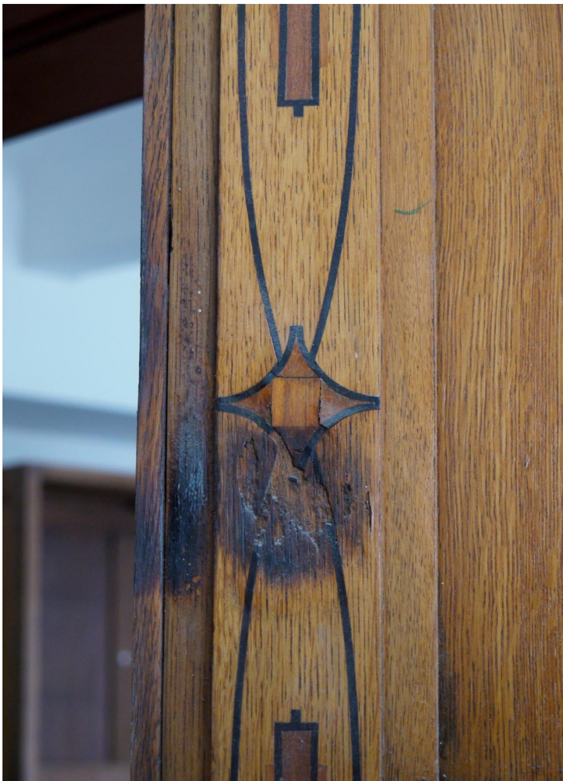
Obr. č. 7. Stav při průzkumu – skříň s policemi – detail V ploše obou skříní je řada drobných poškození. Některá již byla v minulosti opravována. Na jedné ze skříní je větší poškození způsobené spálením dřevní hmoty.
