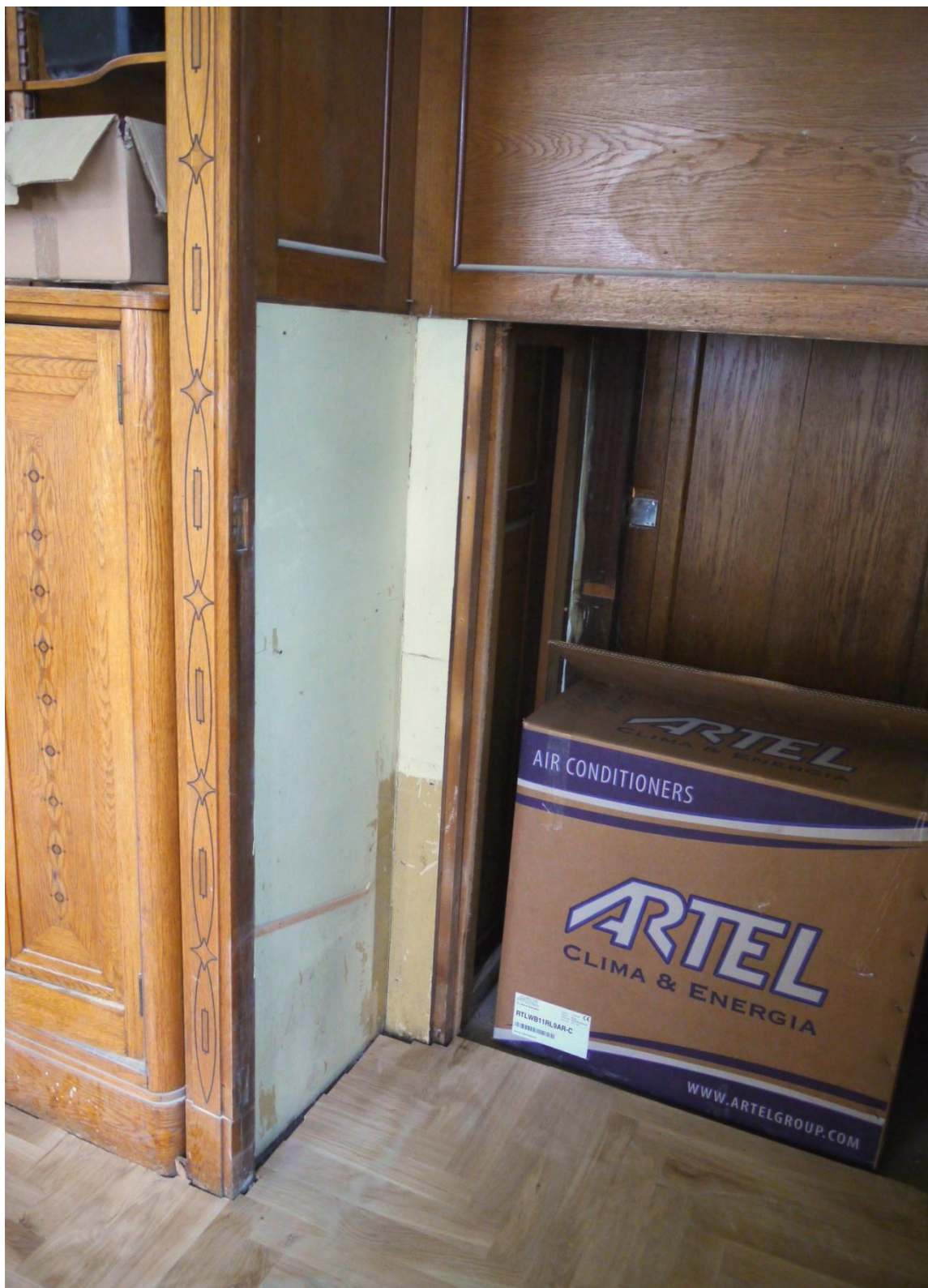
Obr. č. 10. Stav při průzkumu – vestavěná skříň /pravá/ – detail Vestavěná skříň je na pravém kraji stěny. Jednotlivé skříně mají společnou konstrukci, která je rozdělená příčkami /stěnami/ na více samostatných částí. Části vnitřního členění u pravé skříně byly v souvislosti se stavebními úpravami odstraněny. Není zřejmé, do jakého stavu bude skříň navracena. Ve skříní chybí police, dveře jsou demontované a odnesené.
