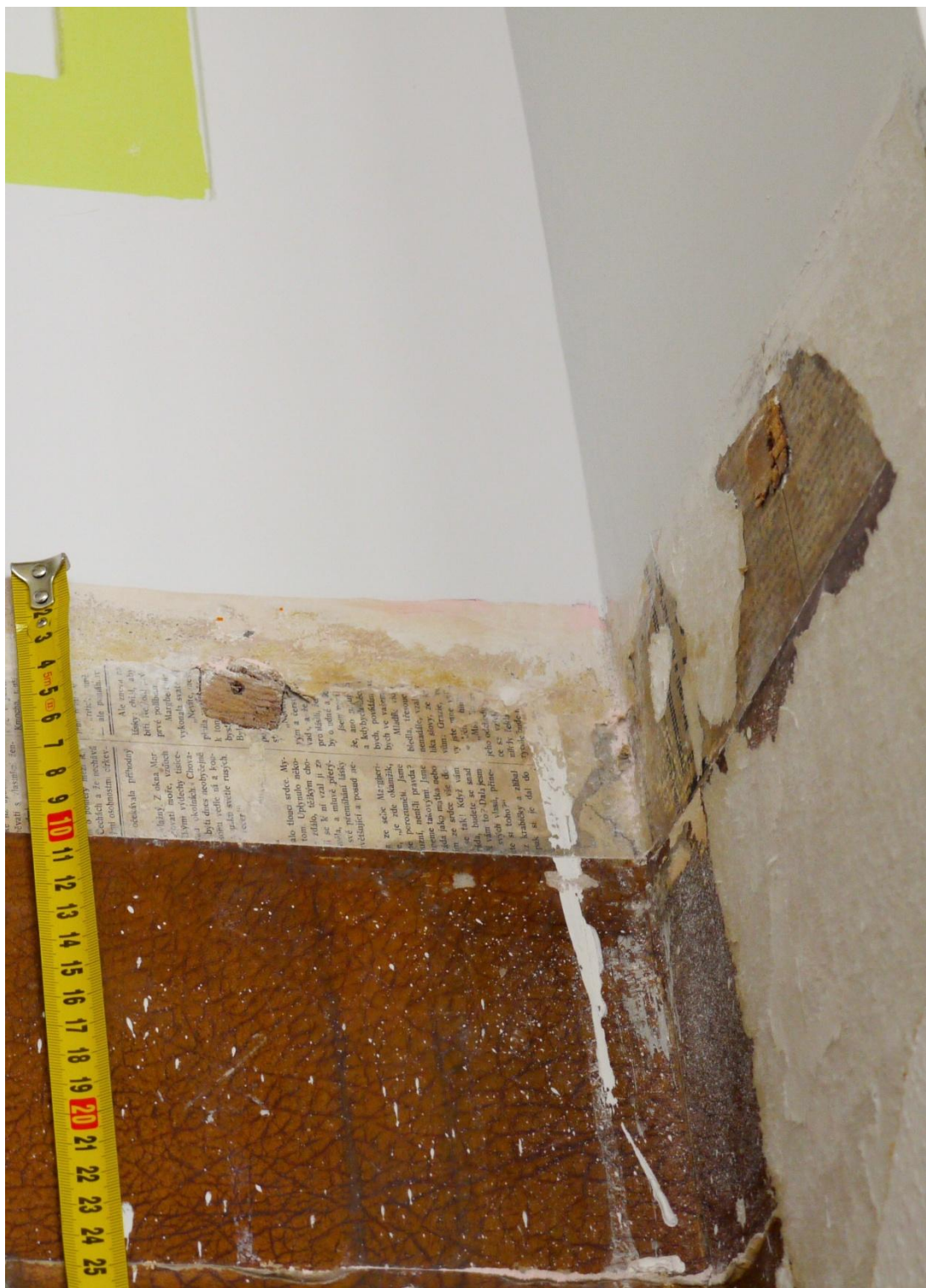
Obr. č. 8. Stav při průzkumu – stěna s tapetou – detail. Vrchní římsa byla vysoká kolem 11 cm.
