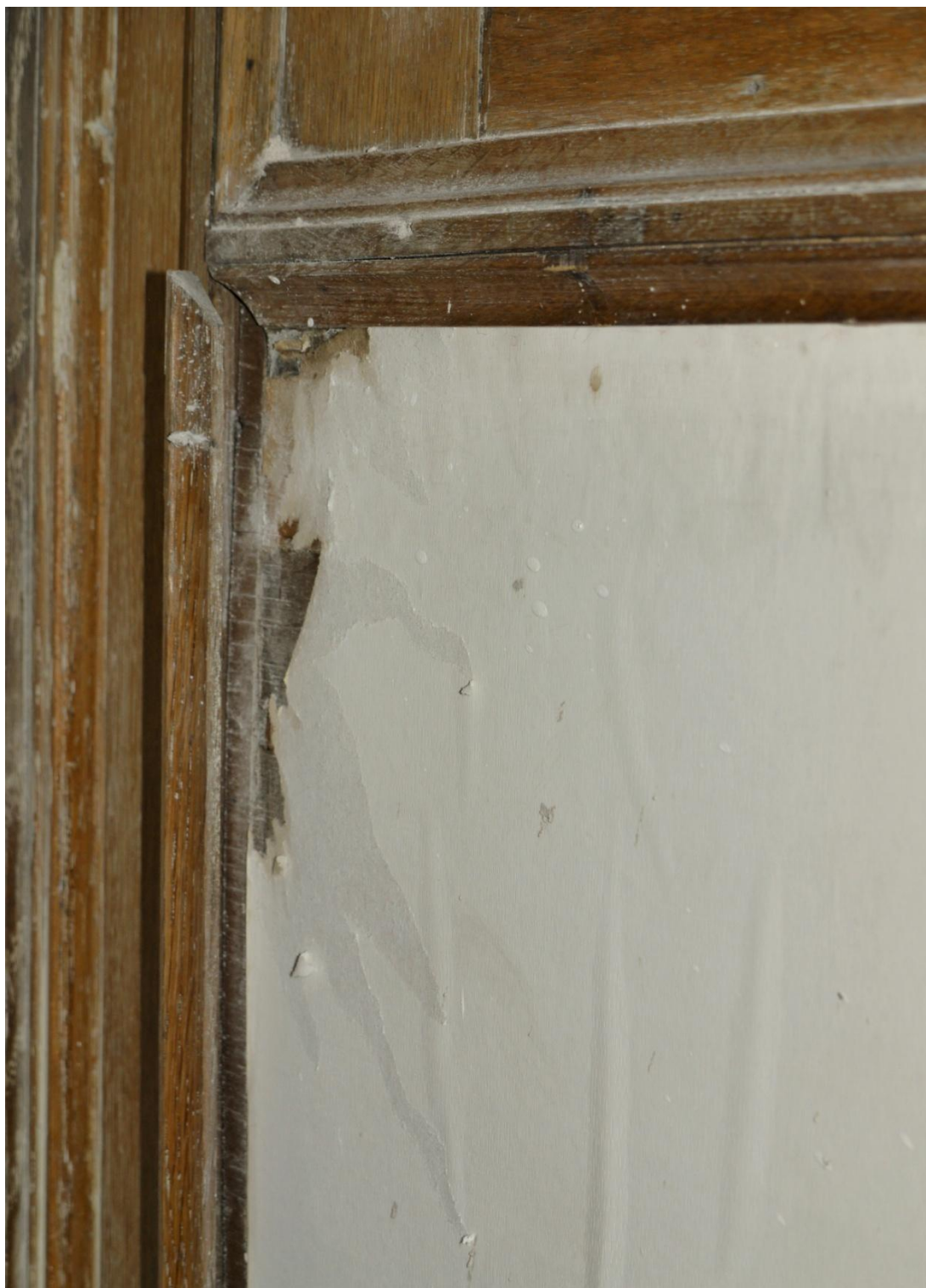
Obr. č. 4. Stav při průzkumu – příčka – detail. Příčky mají stejné typy poškození a jejich stav je velmi podobný. Povrch je silně znečištěný, lištování je uvolněné, některé lišty jsou nalomené.
