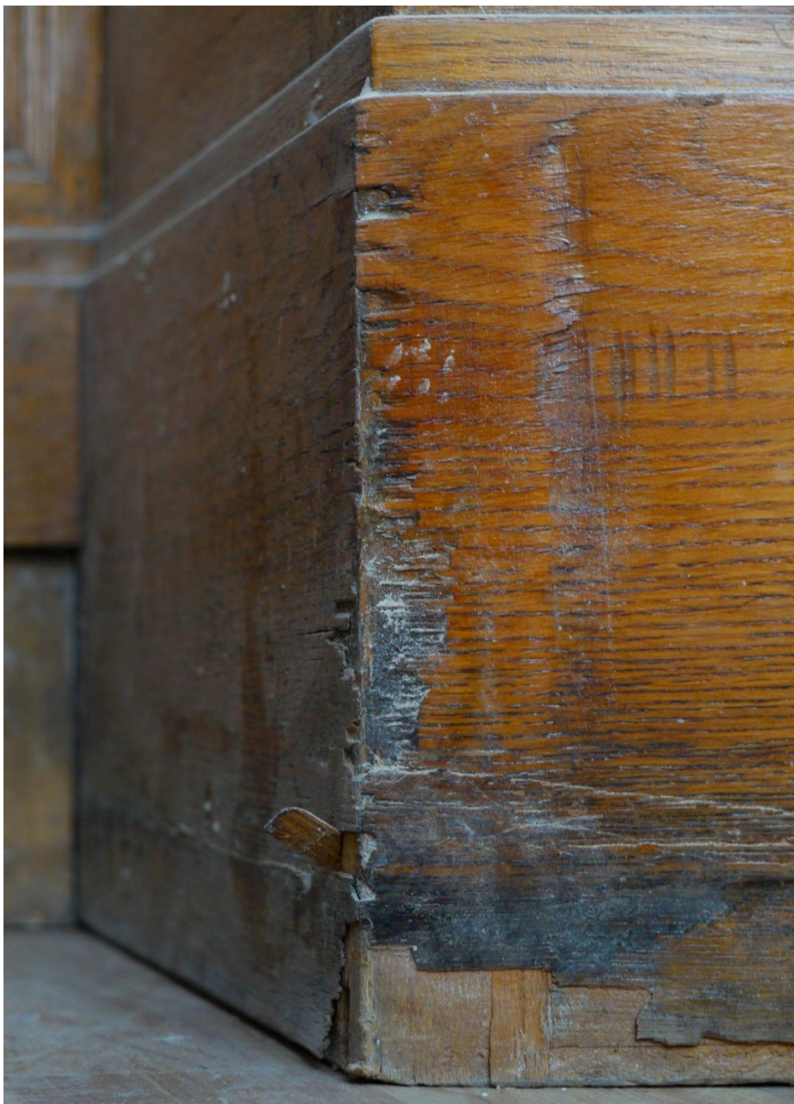
Obr. č. 4. Stav při průzkumu – skříň s policemi – detail Soklové části obou skříní jsou značně poškozené. Dýhování je oštípané, dýhy se uvolňují, část u podlahy je zčernalá.
