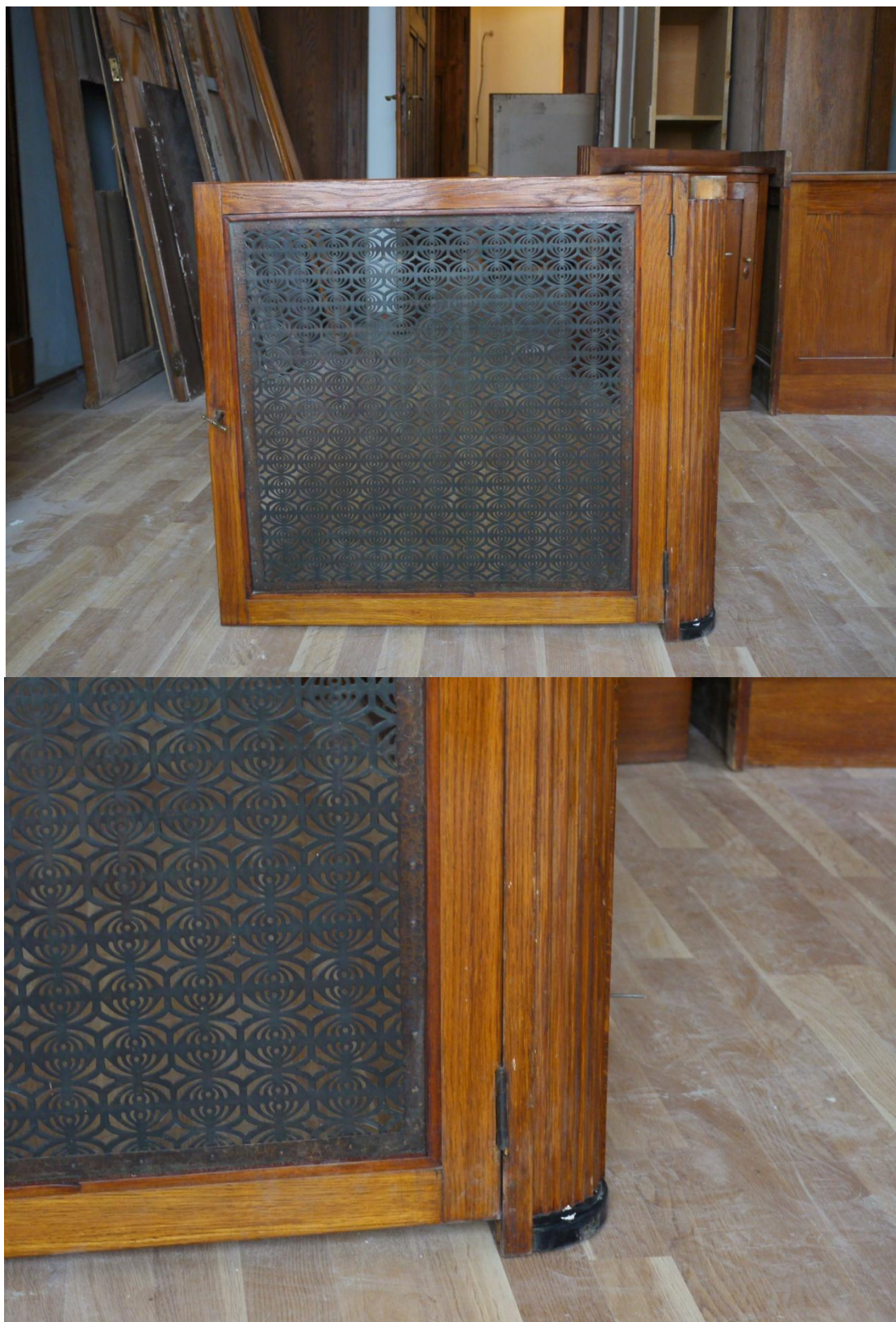
Obr. č. 2+3. Stav při průzkumu – kryt radiátoru – celkový pohled+detail. Kryty jsou rámové konstrukce, s oblými rohy. Oblý roh na bocích krytu je kanelovaný s černou patkou jako nožičkou, Čelní plocha je s dvoukřídlými dvířky uzamykatelnými jazýčkovým zámkem. Dvířka jsou tvořena hladkým rámem s výplní /mřížkou/z mosazného plechu. Vrchní deska je také tvořena rámem s předními oblými rohy.
