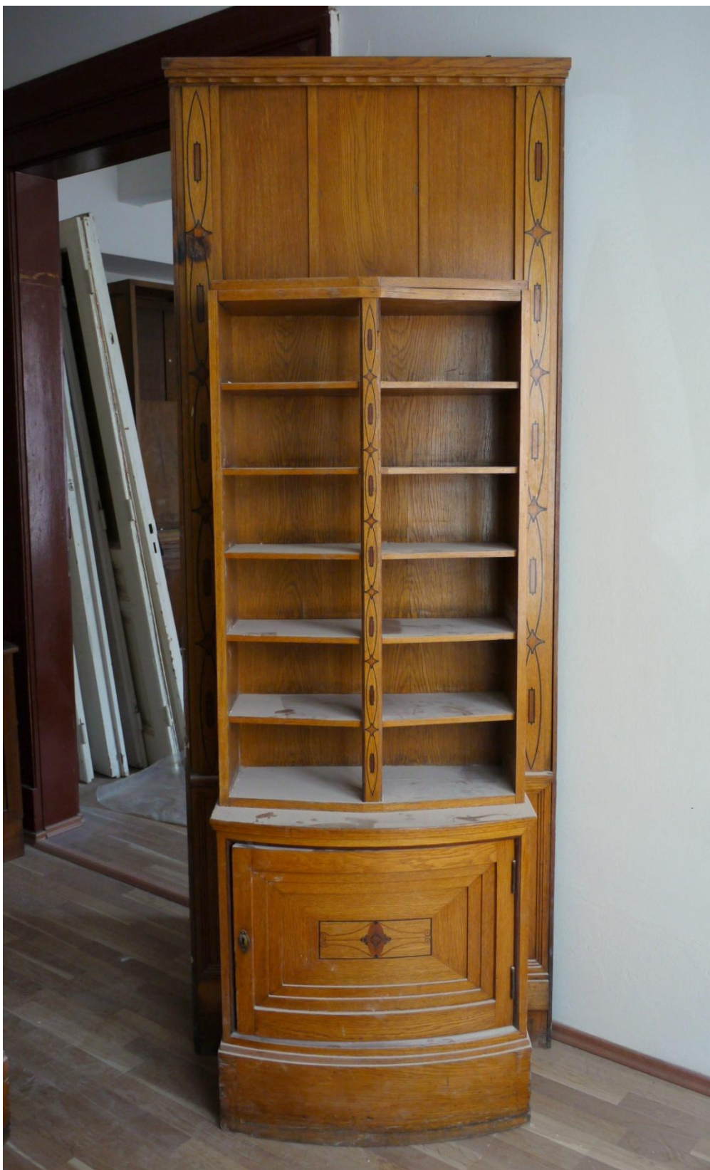
Obr. č. 2. Stav při průzkumu – skříň s policemi – celkový pohled Dvě shodné skříně s obkladem mají stejnou konstrukci i rozměry. Povrch je silně znečištěný, s řadou drobných poškození. U země je dýhování zčernalé. Chybí lemovací lišty. Chybí drobné části profilových lišt i soklů. Jedno místo je spálené.
