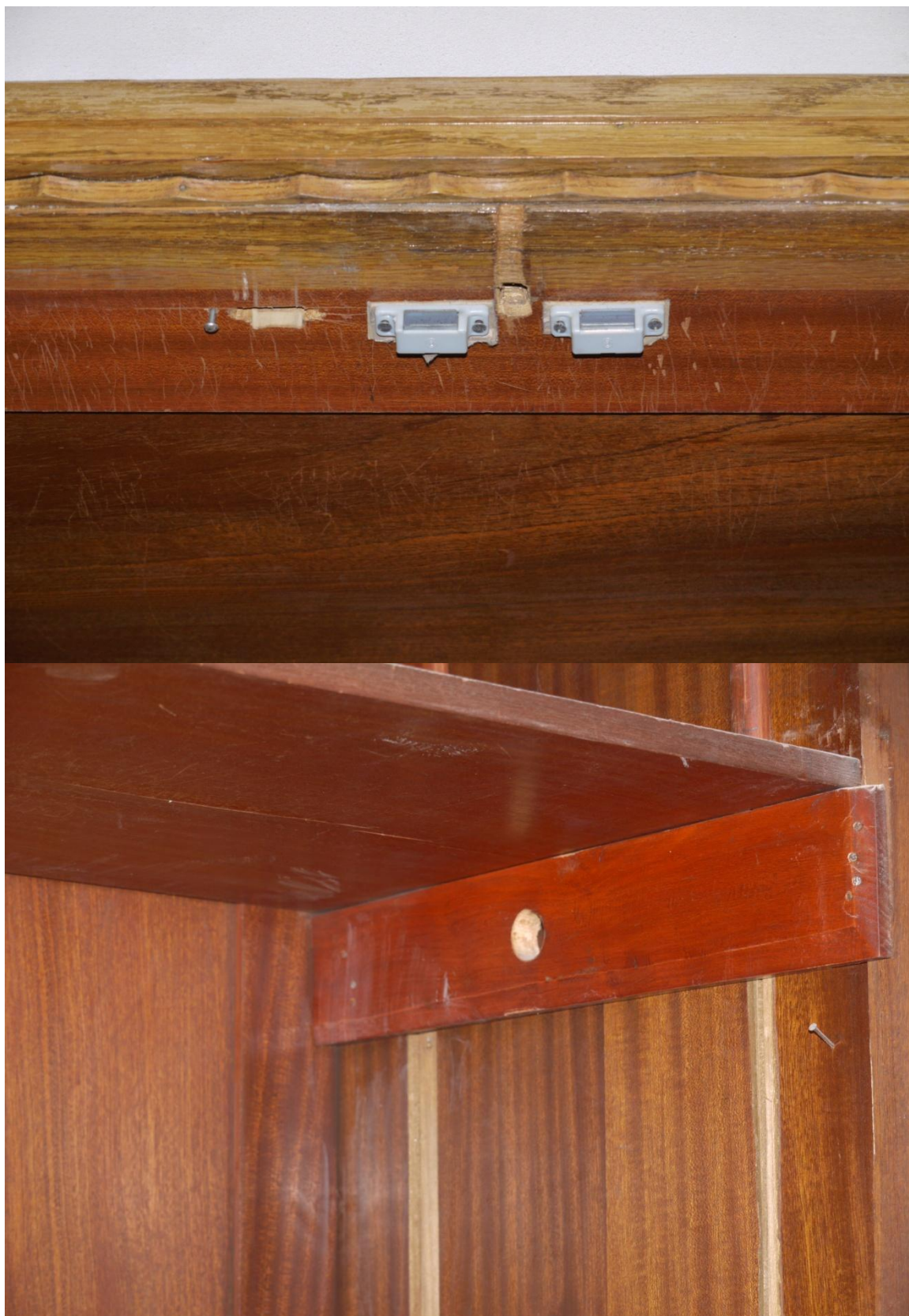
Obr. č. 4+5. Stav při průzkumu – vestavěná skříň /levá/ – detail U skříňe chybí zámek, v zavřené poloze drží dveře dodatečně namontované magnety. Vnitřek skříňe je dýhovaný mahagonem. Skříň je dodatečně upravena jako šatník.
