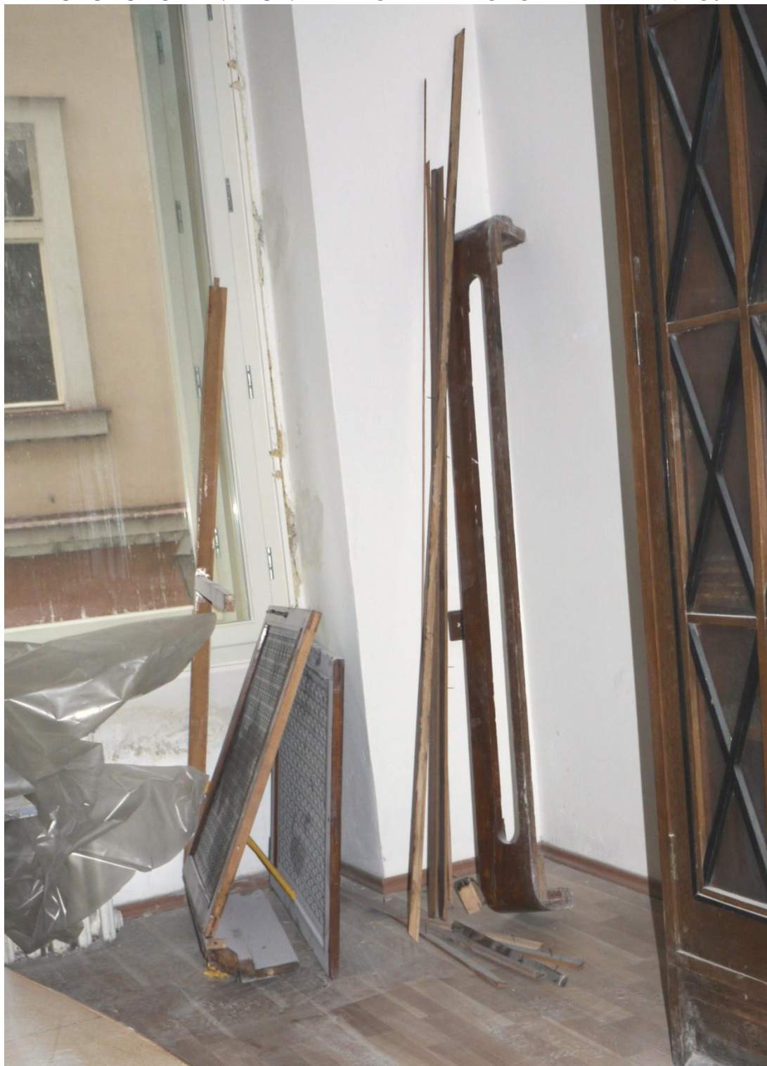
Obr. č. 1. Stav při průzkumu – kryt radiátoru – celkový pohled. Oba kryty z ředitelny byly v době průzkumu odstraněny a uloženy na jiném místě. Kryty jsou rámové konstrukce, s oblými rohy. Oblý roh je kanelovaný s černou patkou jako nožičkou, Čelní plocha je s dvoukřídlými dvířky uzamykatelnými jazýčkovým zámek. Dvířka jsou tvořená hladkým rámem s výplní /mřížkou/z mosazného plechu. Vrchní deska je také tvořená rámem s předními oblými rohy.
