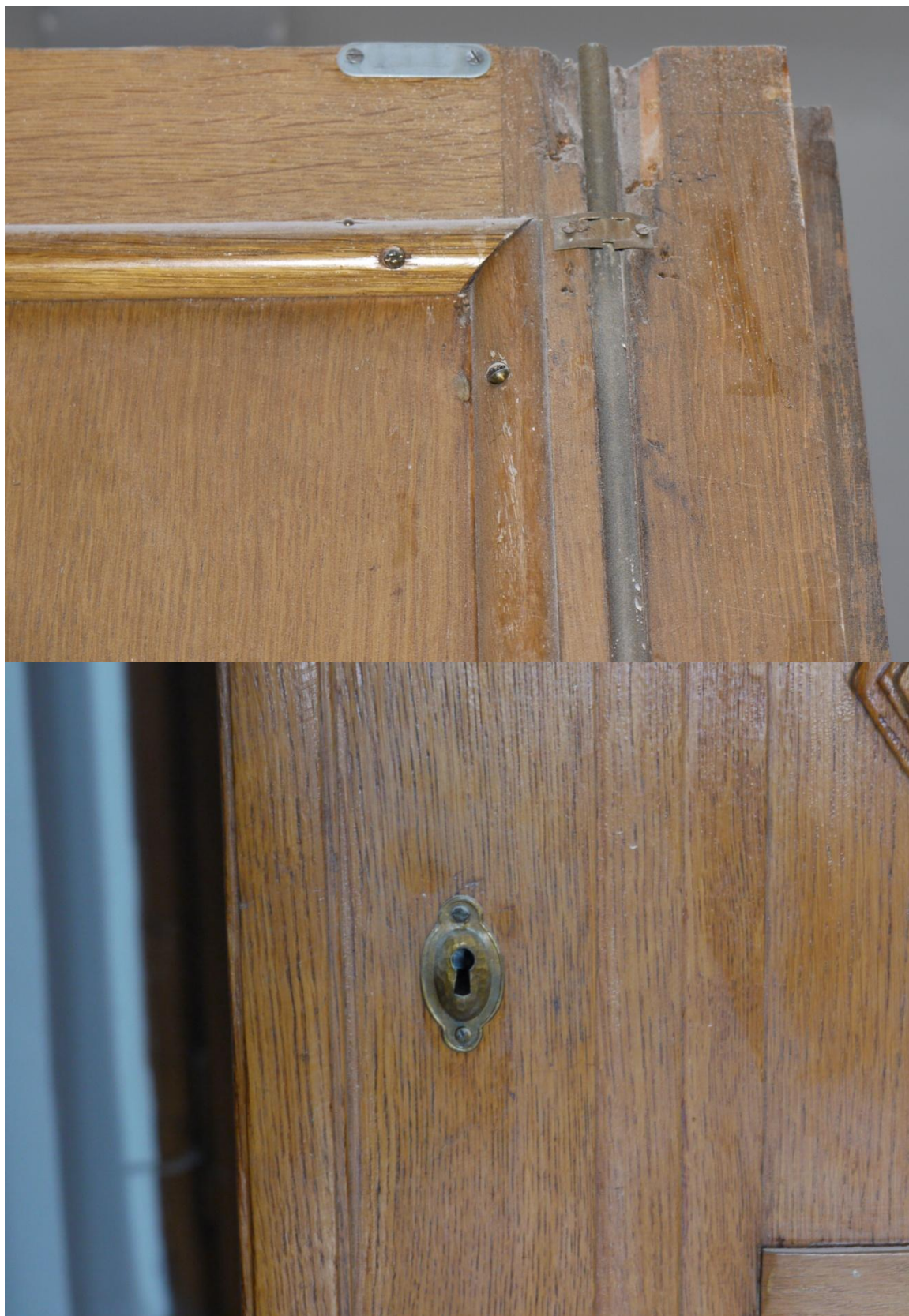
Obr. č. 17+18. Stav při průzkumu – vestavěná skříň /pravá/ – detail Na dveřích je dochovaný původní zámek. Chybí krycí lišta, která byla uchycená malými vruty. Šířku lišty lze odvodit podle otisku. Zdobné štítky se na dveřích dochovaly.
