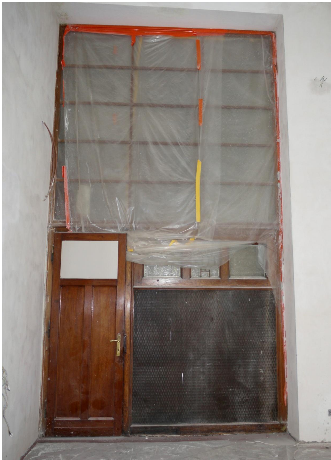
Obr. č. 1. Stav při průzkumu – příčka s tapetou – celkový pohled. Obě příčky jsou shodné konstrukce. Příčky jsou silně znečištěné, povrch je odřený, spodní část u podlahy je zčernalá. Mnohá poškození na ploše jsou způsobena montáží různých prvků, které jsou v současnosti demontované.
