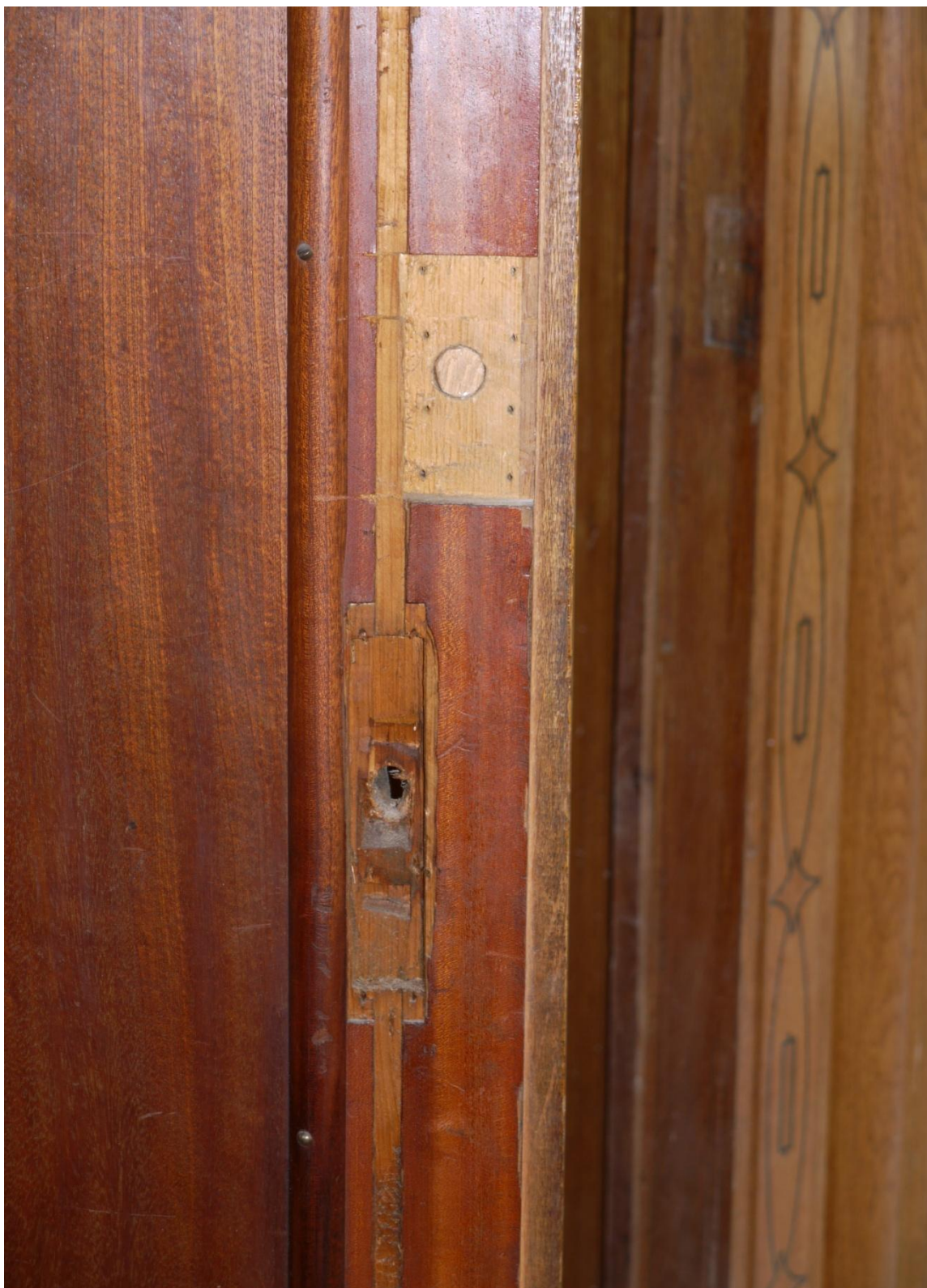
Obr. č. 3. Stav při průzkumu – vestavěná skříň /levá/ – detail U skříně chybí zámek, v zavřené poloze drží dveře dodatečně namontované magnety. Původní zámek byl nahrazen. Náhradní zámek je také odstraněný, poškození způsobené montáží zámku je částečně opraveno.
