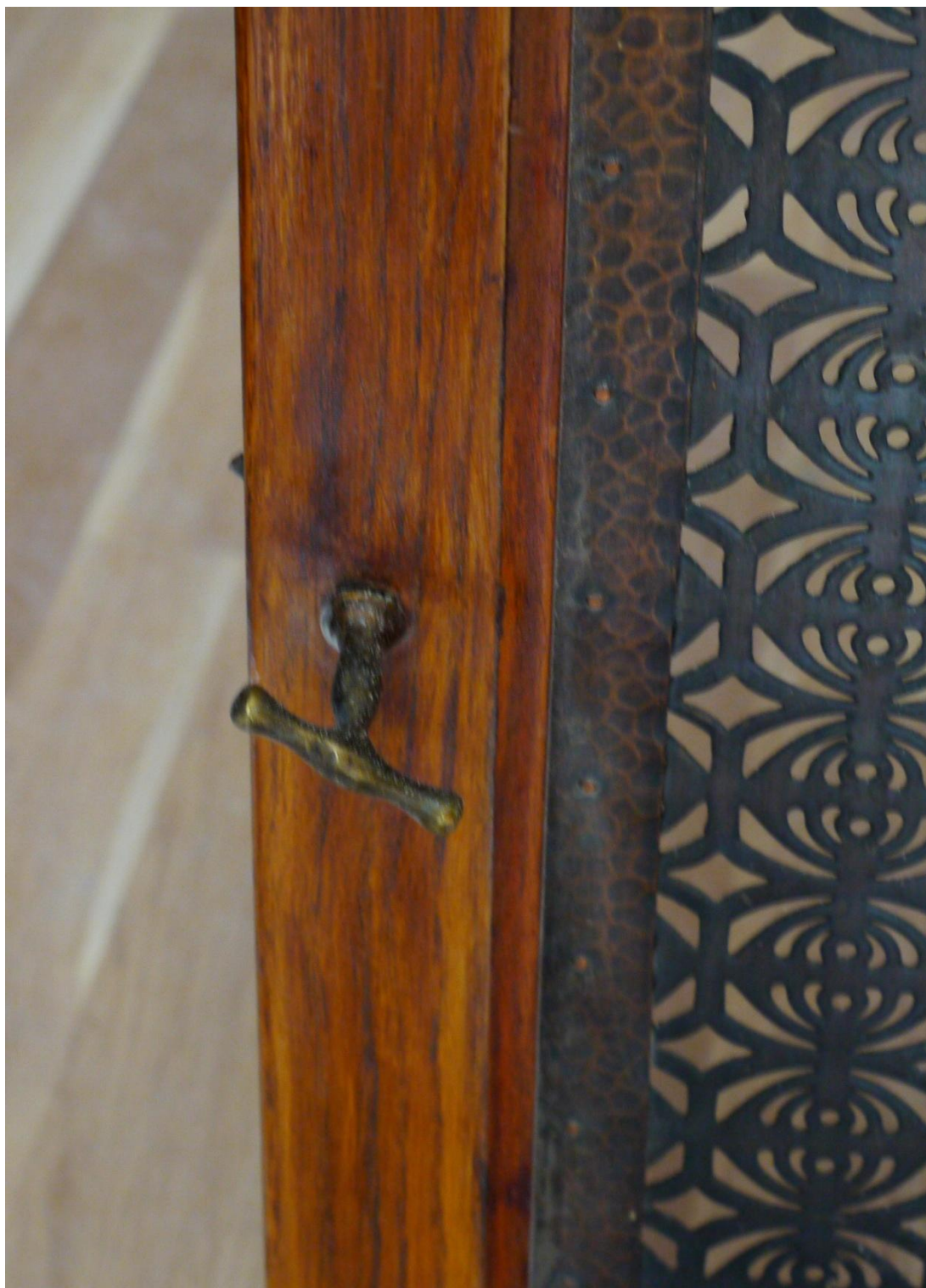
Obr. č. 4. Stav při průzkumu – kryt radiátoru – detail. Dvířka jsou tvořená hladkým rámem s výplní /mřížkou/ z mosazného plechu. Mřížka je lemovaná tepanou měděnou páskou. Jazýčkový zámek se otvírá mosaznou kličkou ve tvaru písmene velkého T.
