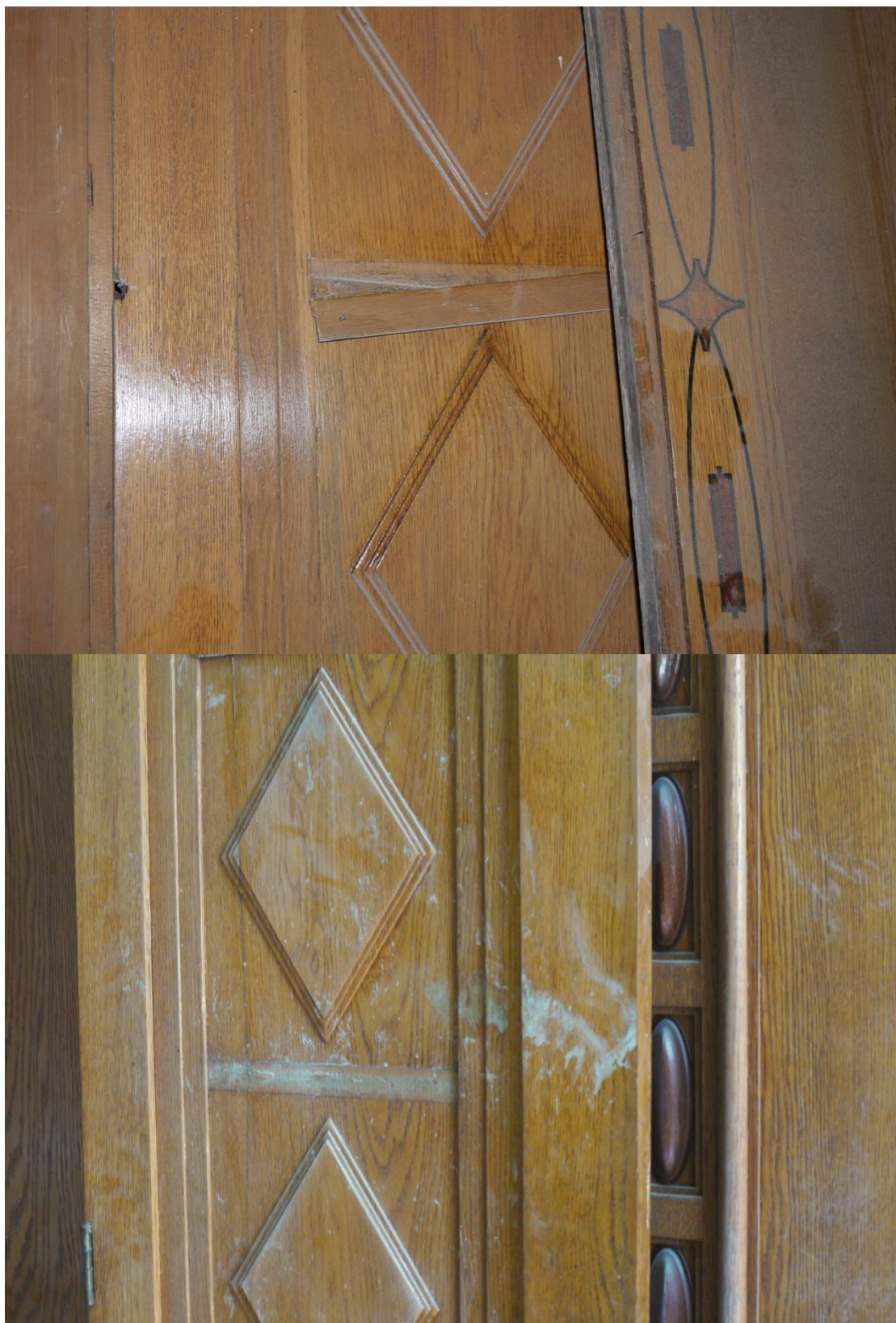
Obr. č. 19+20. Stav při průzkumu – vestavěná skříň /pravá/ – detail Na dveřích je poškozené dělení kazety. Dělicí lišty jsou uvolněné, část jich chybí.
