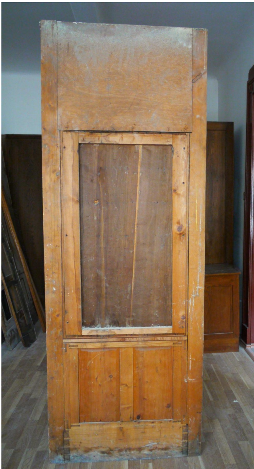
Obr. č. 3. Stav při průzkumu – skříň s policemi – celkový pohled Dvě shodné skříně s obkladem mají stejnou konstrukci i rozměry. Konstrukce je rámová s výplněmi.
