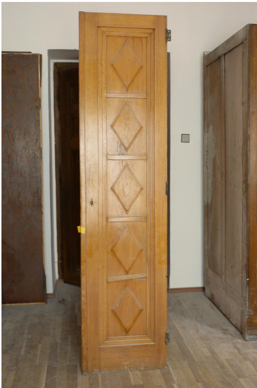
Obr. č. 13. Stav při průzkumu – vestavěná skříň /pravá/ – celkový pohled Části skříně byly v souvislosti se stavebními úpravami demontovány. Demontované dveře byly odneseny a nacházely se v různých prostorách. Dveře mají poškozené dělicí lišty, část jich chybí. Povrch je silně znečištěný, na ploše jsou drobná poškození. Hrany jsou odřené.
