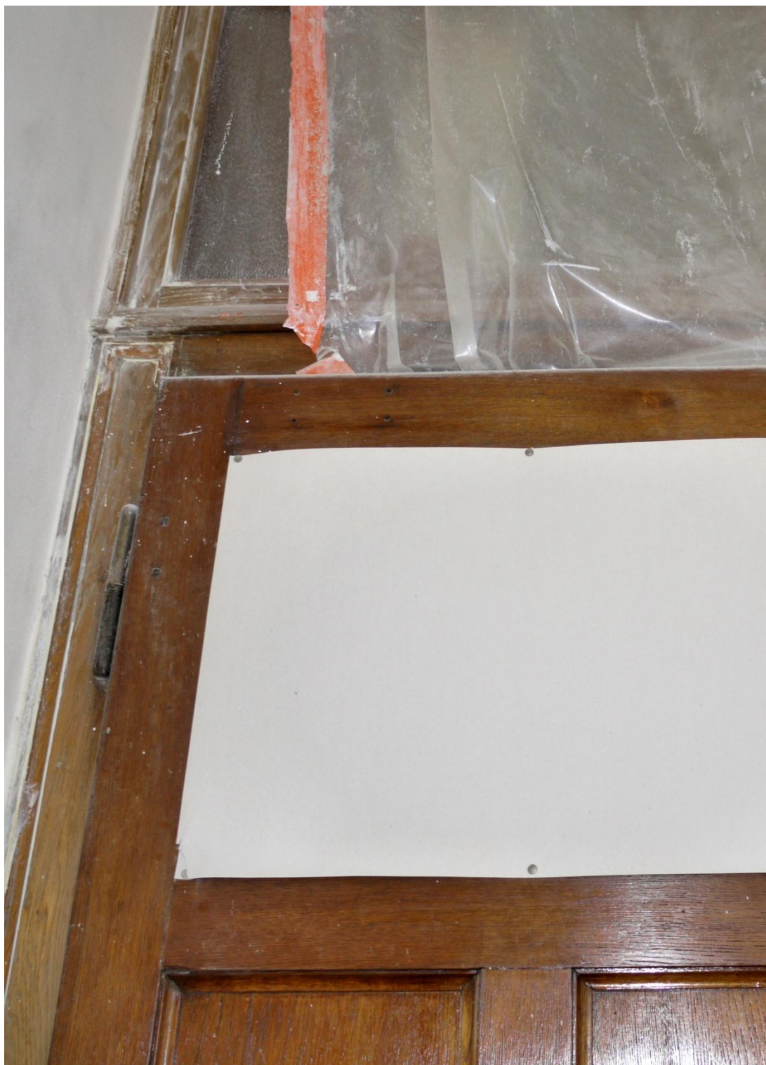
Obr. č. 3. Stav při průzkumu – příčka – detail. Příčky mají stejné typy poškození a jejich stav je velmi podobný. Na dveřích i rámu jsou stopy po odstraněném samozavírači. Povrch je silně znečištěný.
