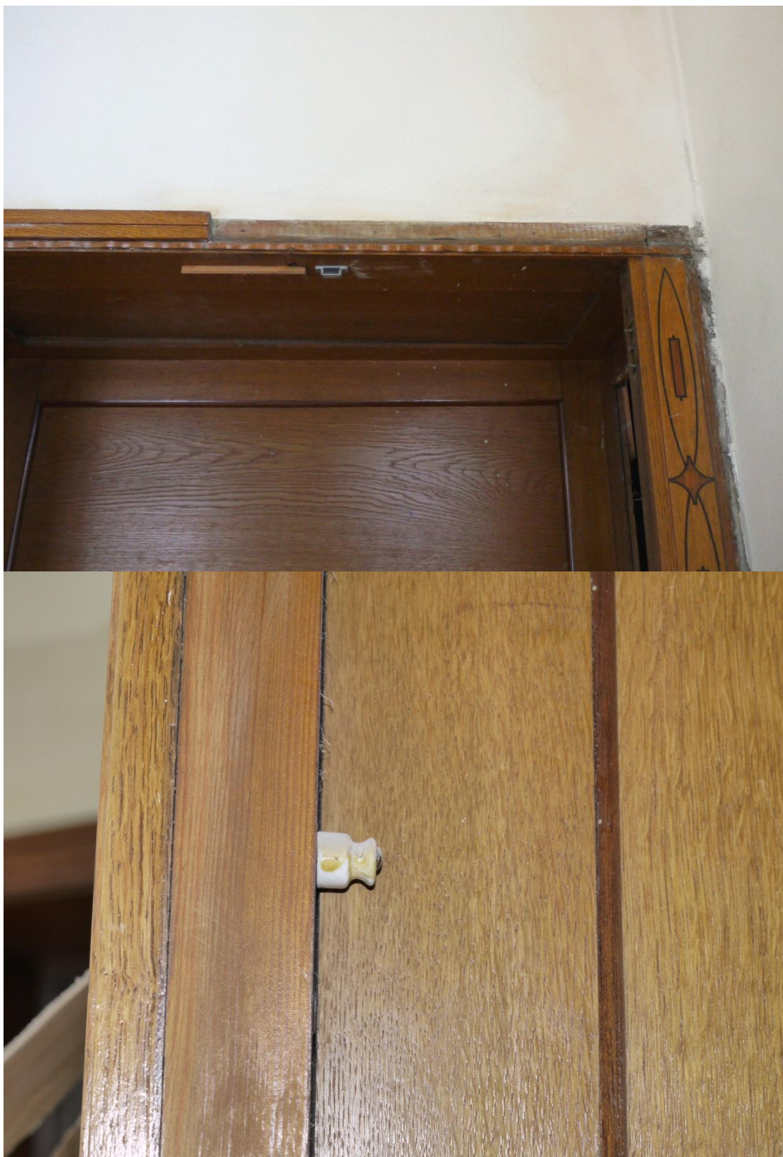
Obr. č. 11+12. Stav při průzkumu – vestavěná skříň /pravá/ – detail Nad skříní chybí část obvodové římsy obkladu. Dveře drží v uzavřené poloze magnet, zámek je nefunkční. Uvnitř skříně jsou dochované pozůstatky po elektroinstalaci.
