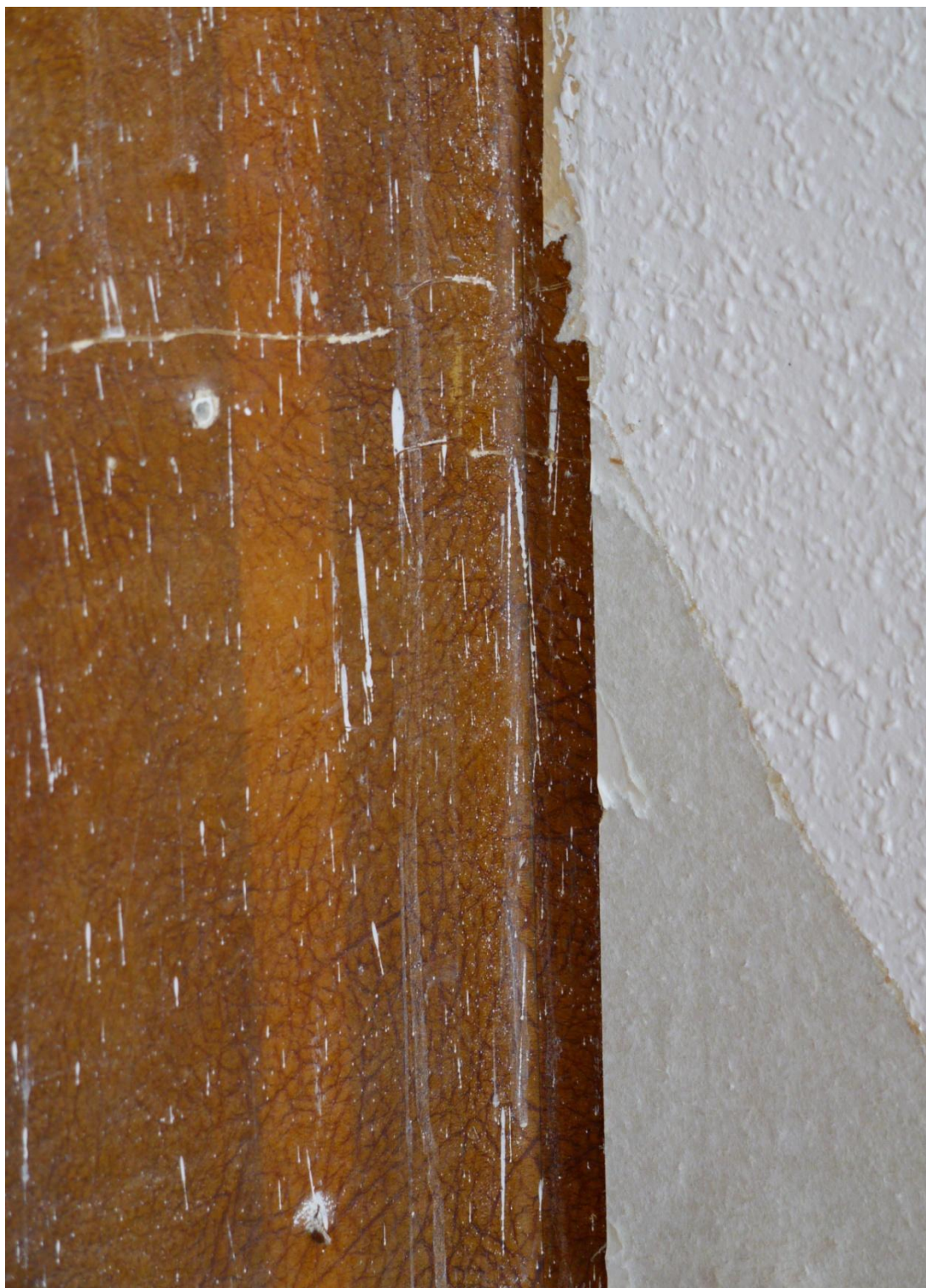
Obr. č. 6. Stav při průzkumu – stěna s tapetou – detail. Jednotlivá pole s tapetami byly opticky odděleny dvojicí subtilních lišt. Zdvojené lišty byly pravděpodobně také v rozích stěn.
