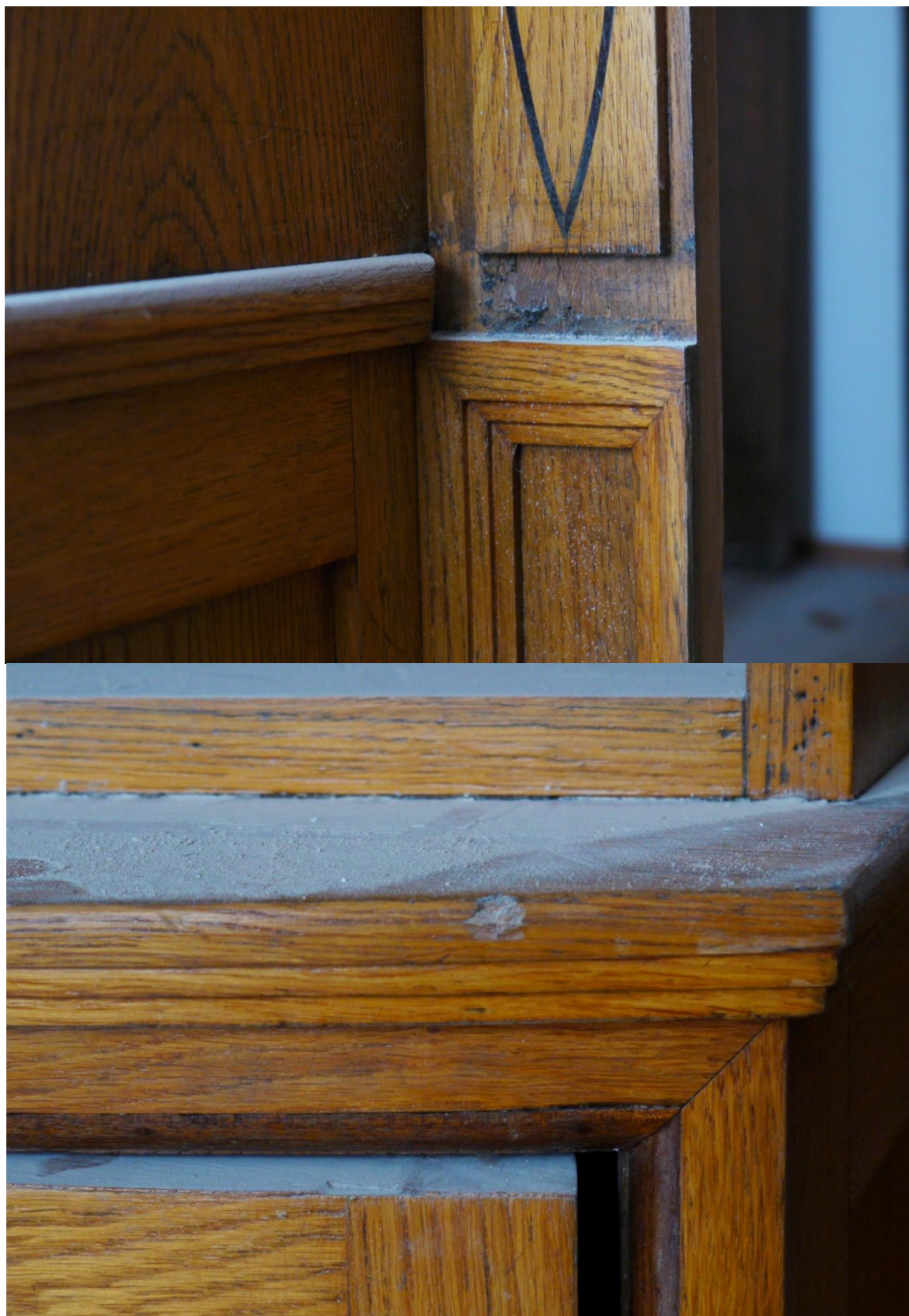
Obr. č. 12+13. Stav při průzkumu – skříň s policemi – detail U obou skříní jsou oštípané hrany a chybí drobné části profilovaných lišt.
