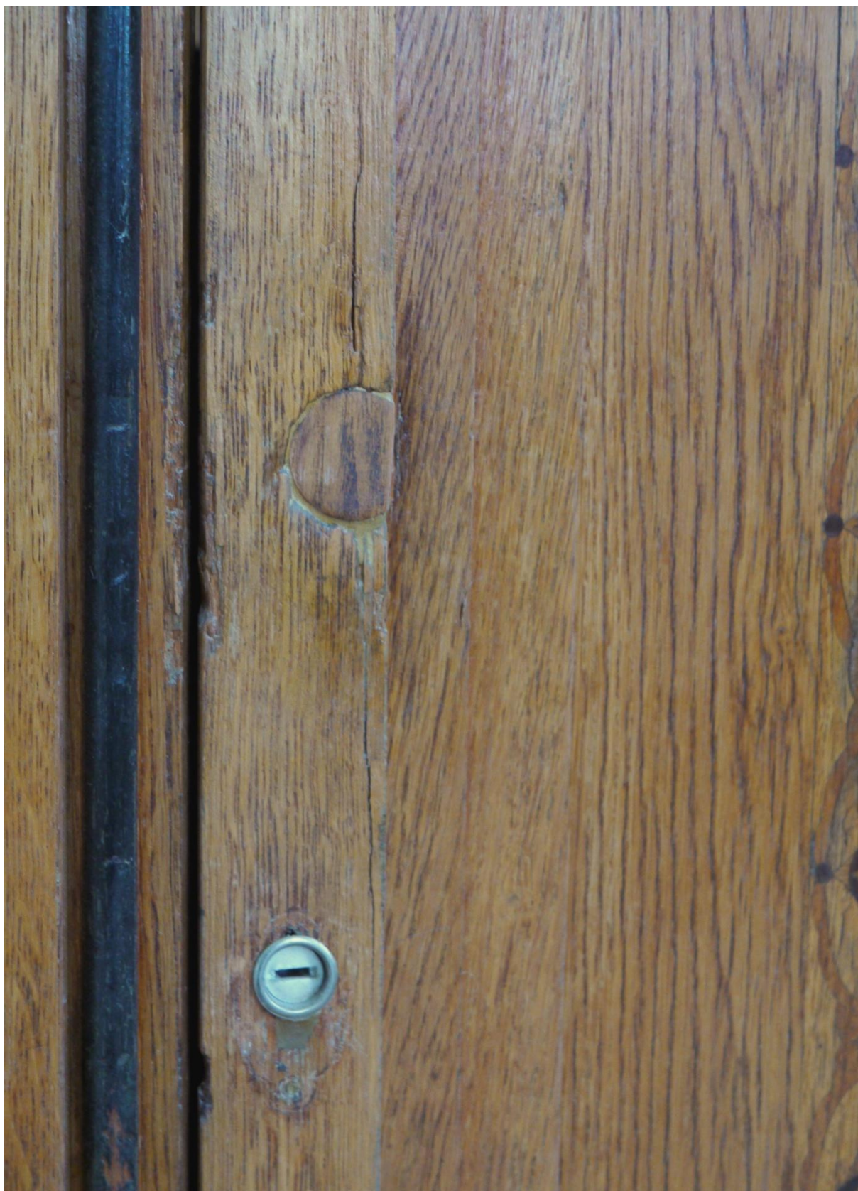
Obr. č. 4. Stav při průzkumu – vestavěná skříň s policemi – detail Zámek byl vyměněn. V souvislosti s výměnou došlo k poškození dvířek a odstranění původního štítku. Příklopná lišta je černě lakovaná. Hrany jsou odřené, některé starší opravy bude nutné revidovat.
