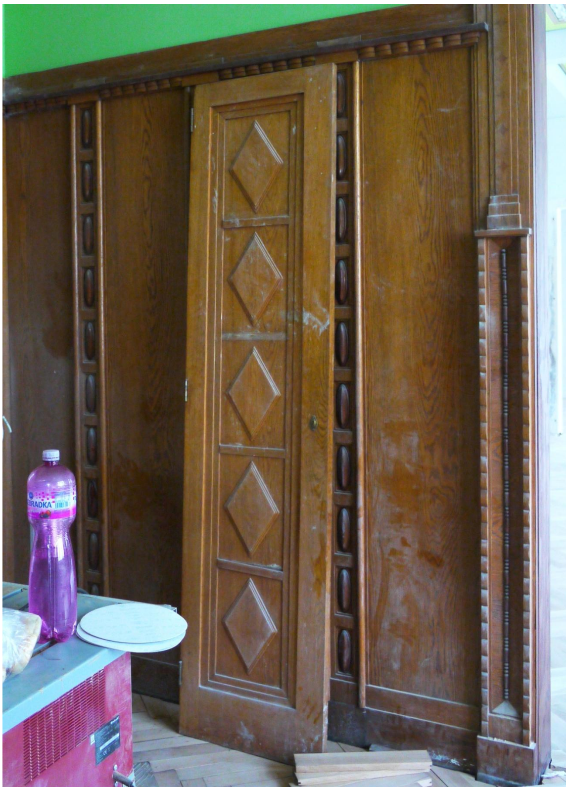
Obr. č. 14. Stav při průzkumu – vestavěná skříň /pravá/ – celkový pohled Části skříně byly v souvislosti se stavebními úpravami demontovány. Demontované dveře byly odneseny a nacházely se v různých prostorách. Dveře mají poškozené dělicí lišty, část jich chybí. Povrch je silně znečištěný, na ploše jsou drobná poškození. Hrany jsou odřené.
