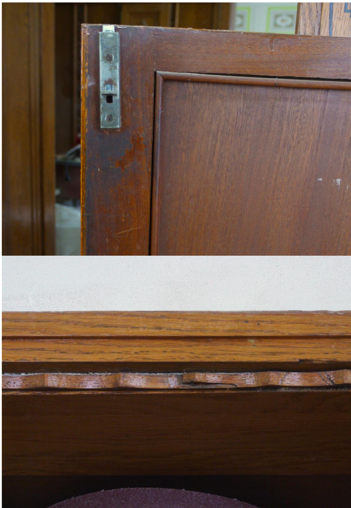
Obr. č. 5+6. Stav při průzkumu – vestavěná skříň s policemi – detail Zámek byl vyměněn. V souvislosti s výměnou došlo k dodatečné montáži zástrčky. na skříni je řada drobných poškození, některá již byla v minulosti opravována.
