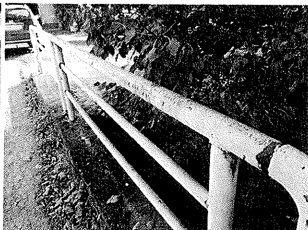
koroze zábradlí
