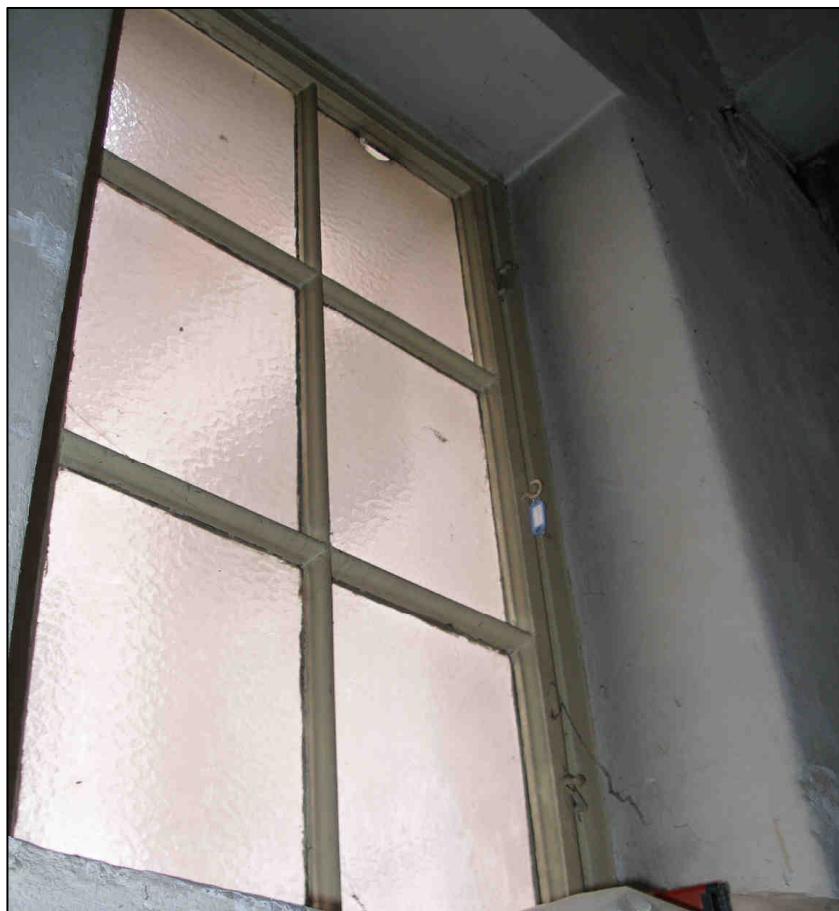
JEDNOKŘÍDLOVÉ OKNO (Č. 124) - SKUPINA 5 - JEDNODUCHÉ OKNO V POMOCNÉM SCHODIŠTI
