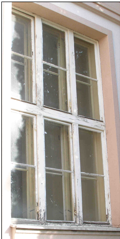
ŠESTIKŘÍDLOVÉ OKNO (Č. 103) - SKUPINA 4 - POŠKOZENÍ VNĚJŠÍCH I VNITŘNÍCH RÁMŮ A ŠPALET
