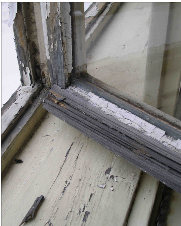
ŠESTIKŘÍDLOVÉ OKNO (Č. 103) - SKUPINA 4 - POŠKOZENÍ VNĚJŠÍCH I VNITŘNÍCH RÁMŮ A ŠPALET
