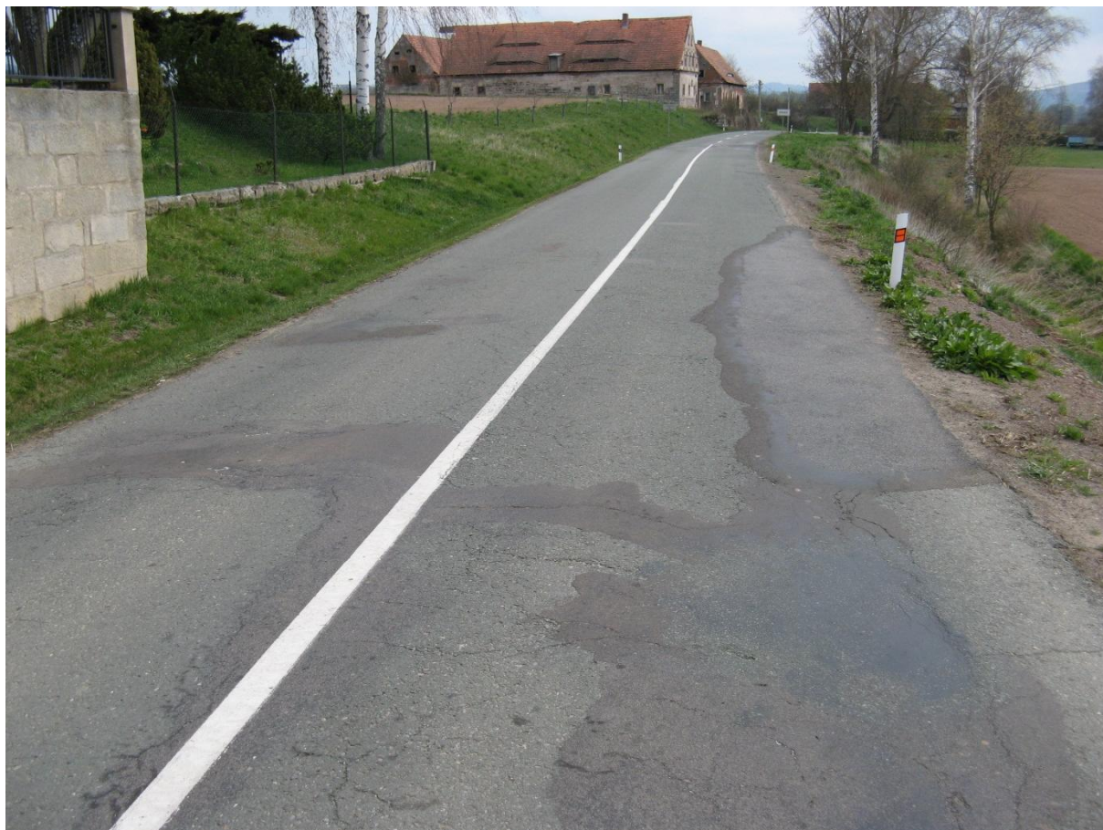
F54, km 14,060+ Vysprávky.
