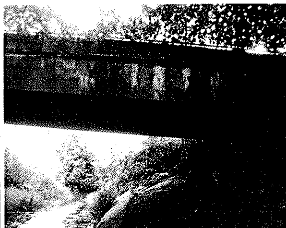
vápenité výluhy na boku NK vpravo
