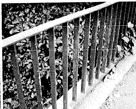
korozí zábradlí
