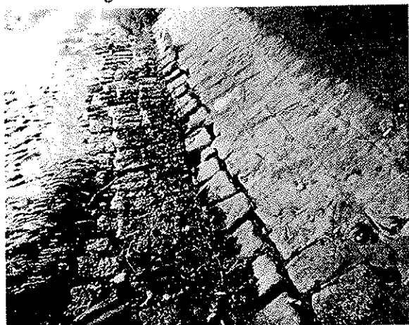
vymleté spárování kamenného zpevnění vodoteče
