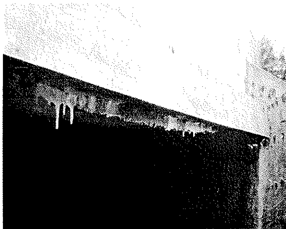
vápenité inkrustace a krápníky na podhledu zleva
