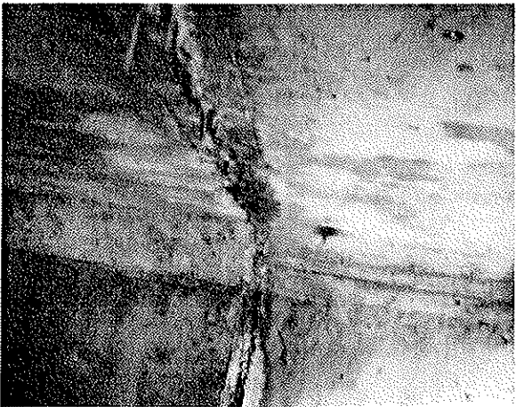
vápenité inkrustace a krápníky na podhledu NK mezi krajními BR
