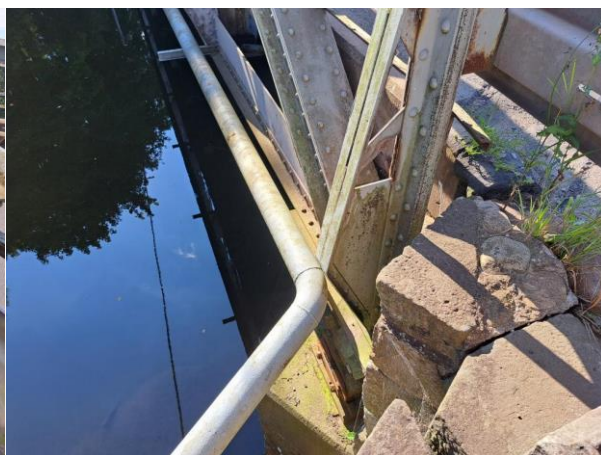
uložení nosníku _OP2_ _návodní strana
