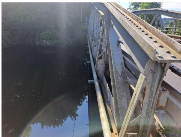
boční pohled _návodní strana_ proti směru staničení
