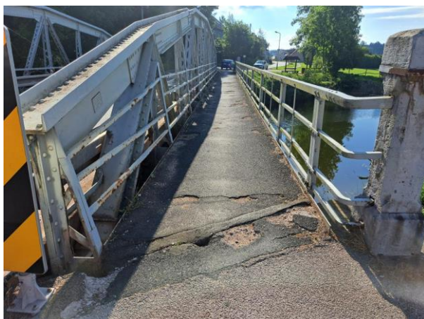
pohled na lávku _proti směru staničení
