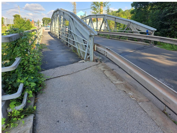
pohled po směru staničení
