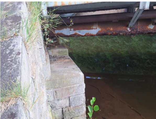
úložný práh_OP2_ložisko_povodní strana
