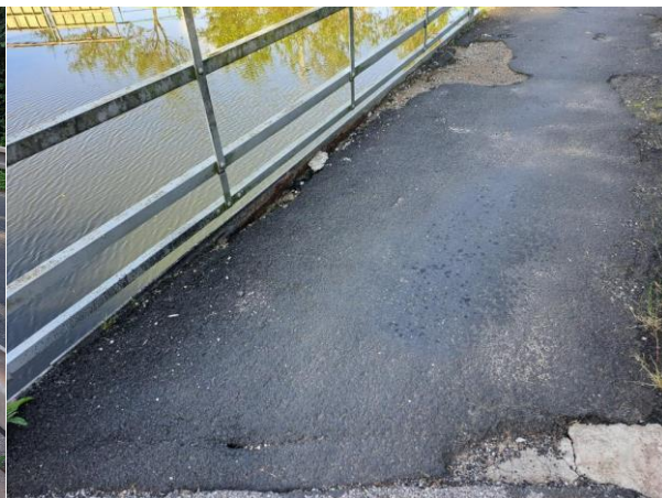
stav povrchu lávky
