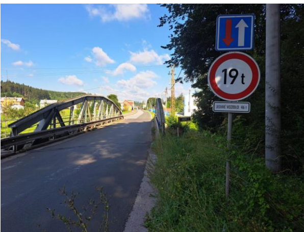
pohled po směru staničení
