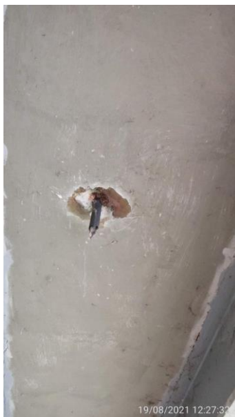
Odvodňovací trubička na podhledu NK
