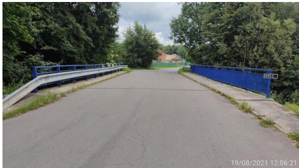
Pohled ve směru staničení
