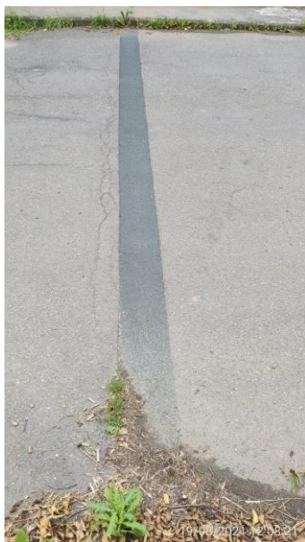
Mostní závěr na konci mostu
