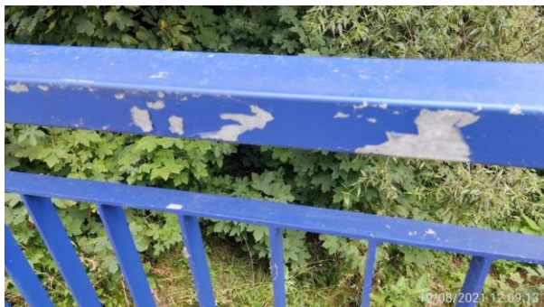
Stav nátěru pravého zábradlí
