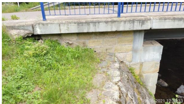
Pravé křídlo na začátku mostu (K3)
