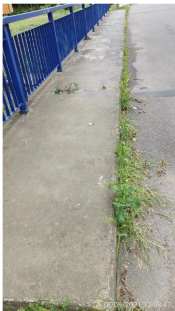
Horní plocha pravého chodníku a vegetace na krajnici
