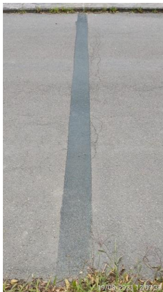
Mostní závěr na začátku mostu
