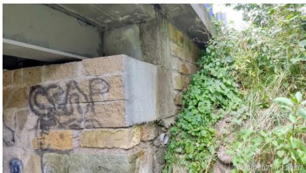
Pravé křídlo na konci mostu (K4)
