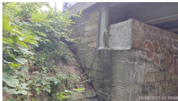
Levé křídlo na konci mostu (K2)
