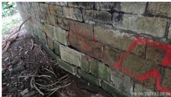
Stav opěry OP2
