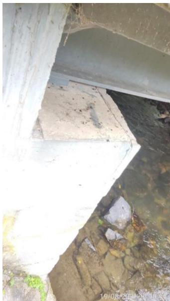
Úložný práh opěry OP1
