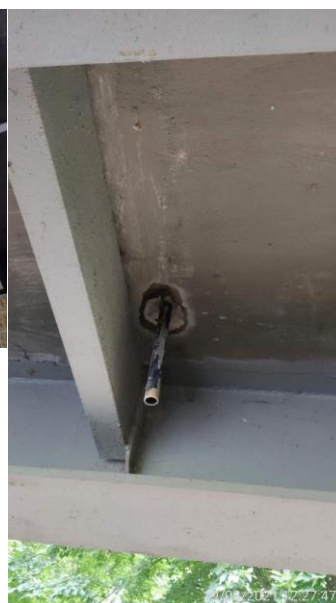
Odvodňovací trubička na podhledu NK vlevo
