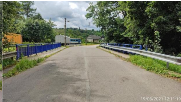
Pohled proti směru staničení
