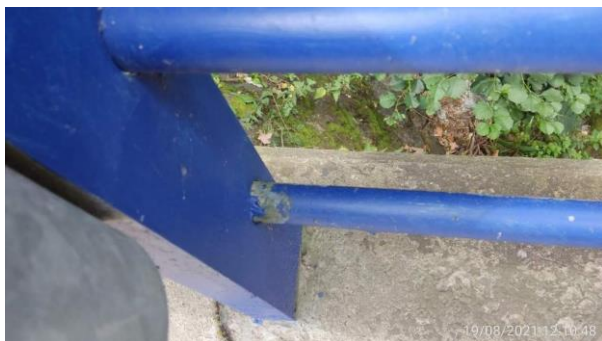
Stav nátěru levého zábradlí
