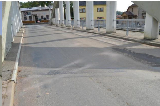
-Pohled na vozovku na mostě
