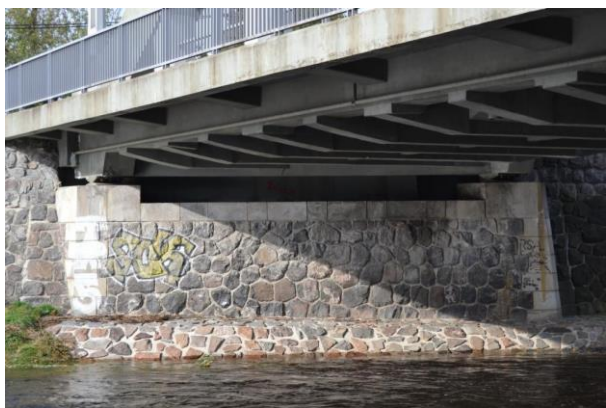
-Pohled na opěru OP1
