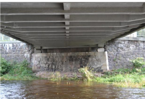
-Pohled na opěru OP2
