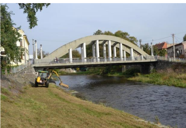
-Pohled na most zprava
