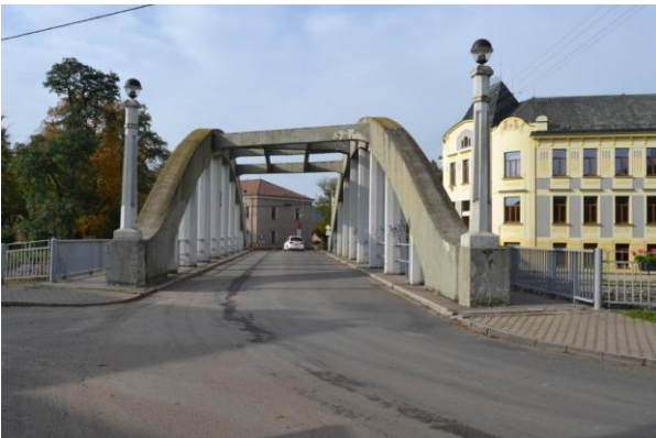
-Pohled na most proti směru staničení
