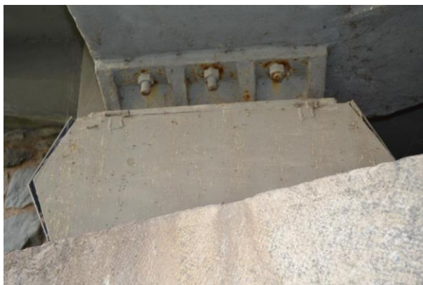
-Posuvné uložení OP2-krytí ložiska
