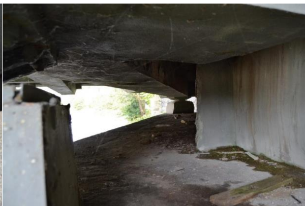
-Nečistoty na ÚP, zatékání
