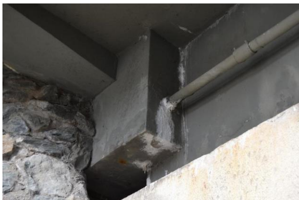
-Výluhy okolo prostupu koncovým příčným
