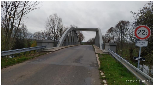
Pohled ve směru staničení
