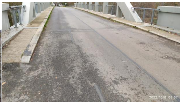
Vozovka na mostě
