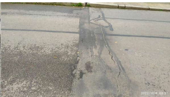
Dilatační spára na začátku mostu
