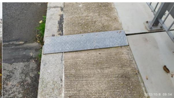
Kryt dilatace chodníku na začátku vpravo
