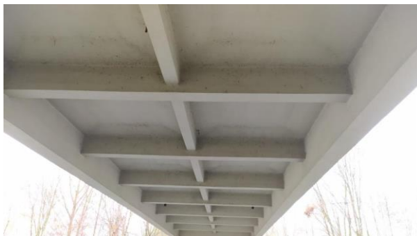
Podhled nosné konstrukce
