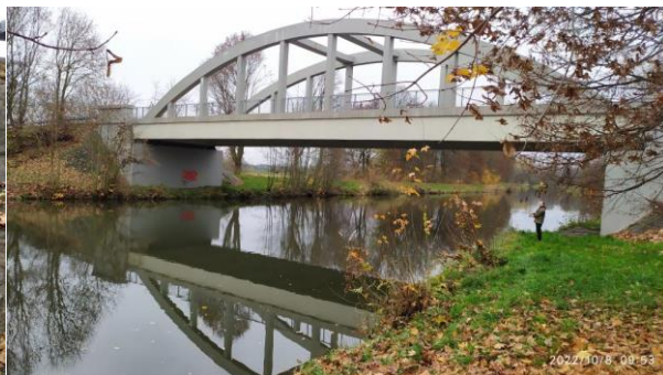
Pohled levá strana mostu
