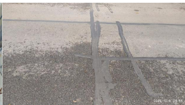
Dilatační spára na konci mostu
