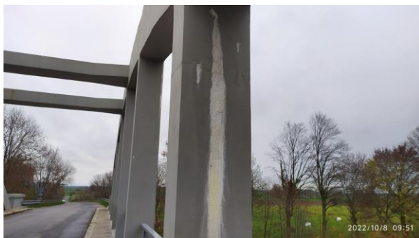
Výluhy na sloupu oblouku vpravo
