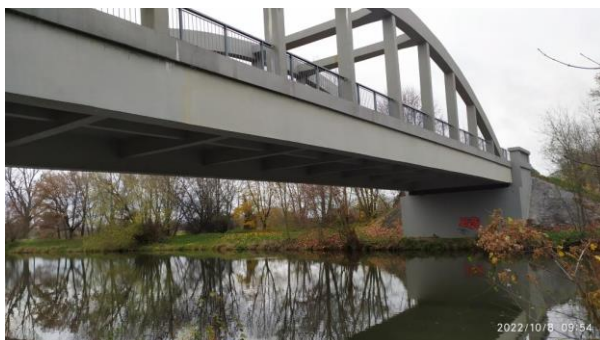
Pohled pravá strana mostu
