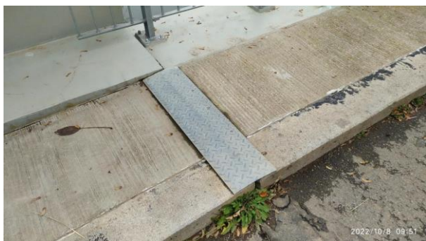
Kryt dilatace na začátku chodníku vlevo
