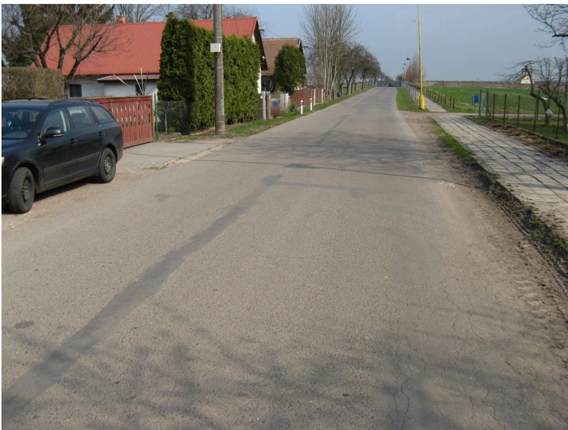
F02, km 8,370+ Síťové trhliny vpravo, celoplošně ztráta asfaltového tmelu.
