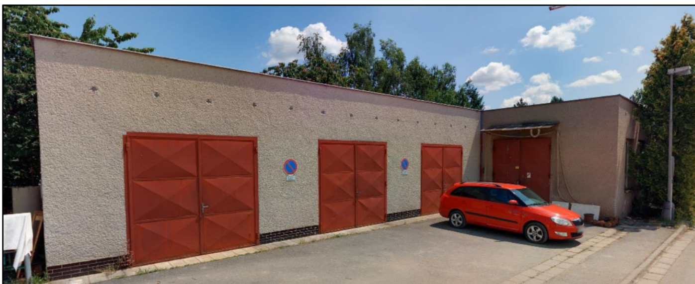
Stavební objekt bez č. p. / č. e. na pozemku p.č. p.č. 3046/5
