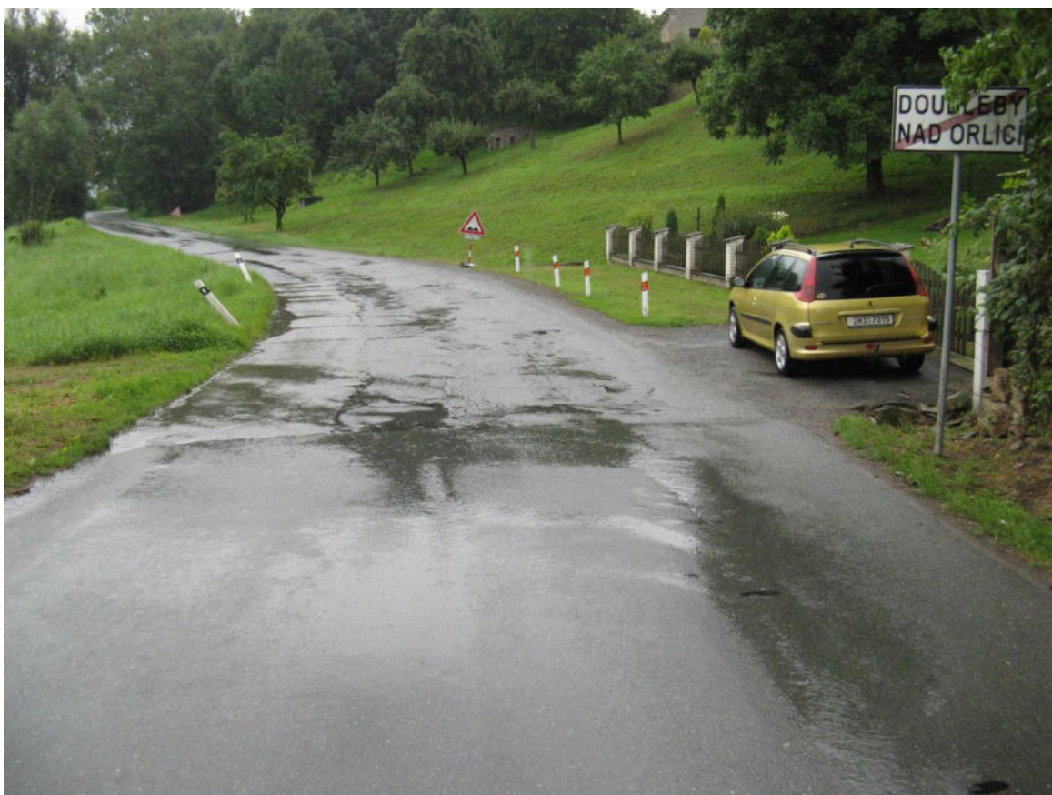
F04, km 0,060+ (Doudleby nad Orlicí) Konec opraveného povrchu. Původní povrch s korozí a vysprávkami podél okrajů.
