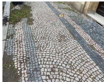
OBR.13 V PRINCIPU VAZBA MOZAIKOVÉ DLAŽBY „TMAVÁ LINKA NA SVĚTLÉM PODKLADU“
