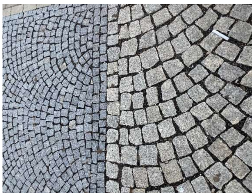
OBR.14 VAZBA MOZAIKOVÉ A DROBNÉ DLAŽBY „VĚJÍŘ“
