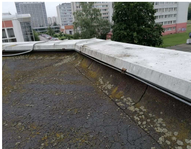
foto /4/ Hromosvod uchycený na oplechování atiky
