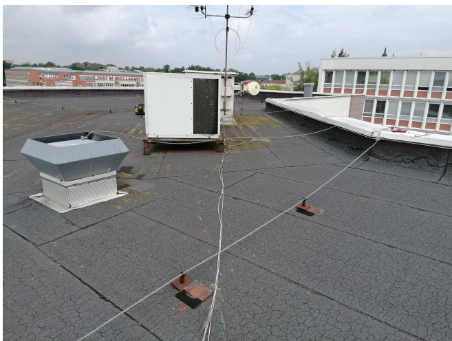
foto /5/ Vzduchotechnická jednotka na ocelové podkladní konstrukci
