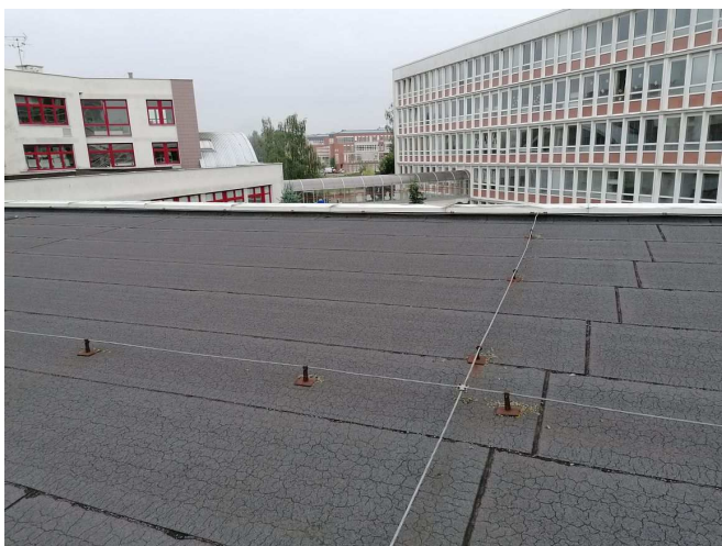
foto /3/ Hromosvod v ploše na střeše 2
