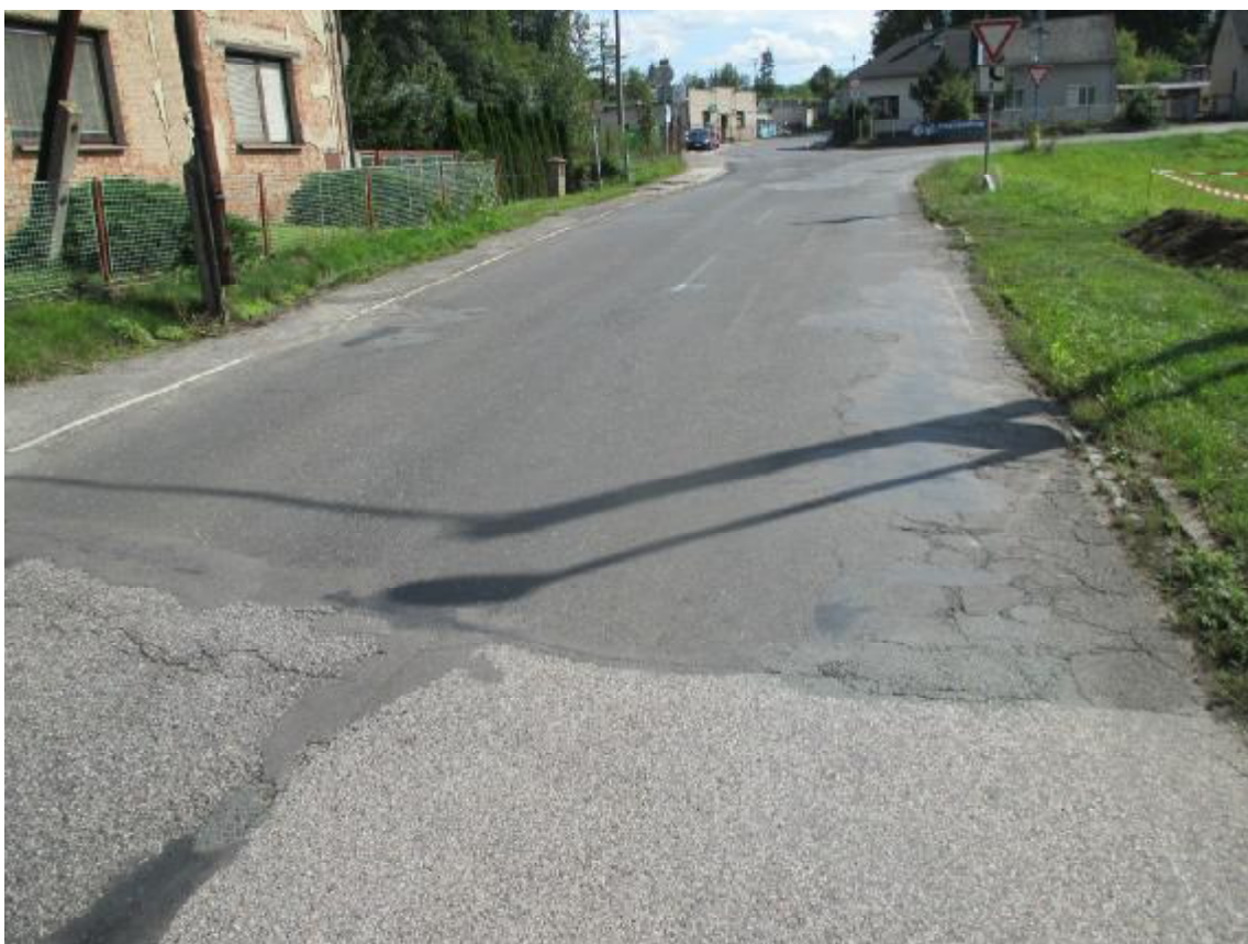
F06, km 18,860+ Změna povrchu, síťové trhliny a deformace vpravo.
