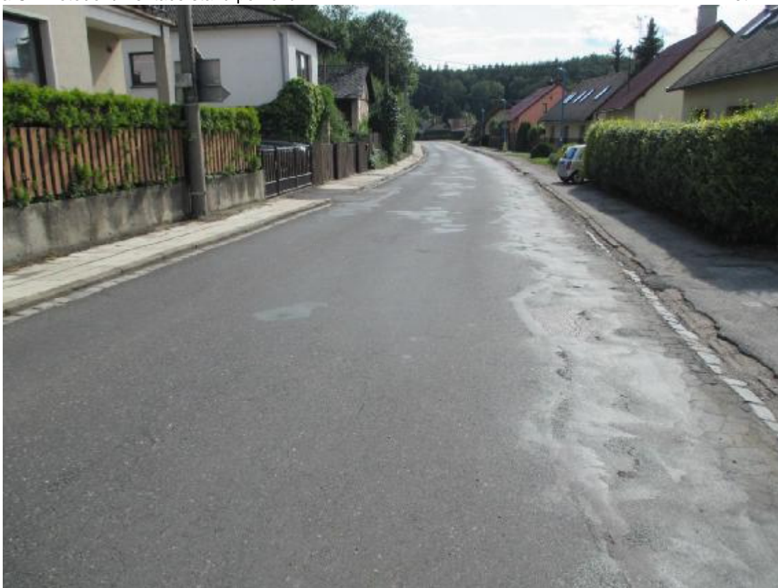
F02, km 18,590+ Síťové trhliny a deformace vpravo.
