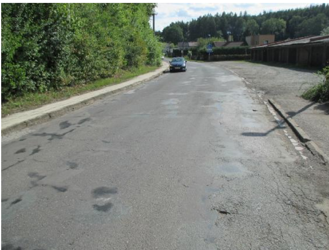
F05, km 18,710+ Síťové trhliny a deformace vpravo, v celé šířce jsou krátké nepravidelné nebo mozaikové trhliny ošetřené tryskovou metodou.
