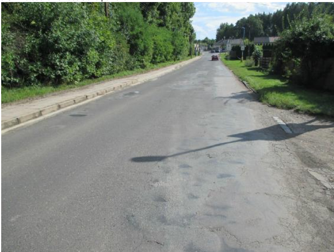
F06, km 18,760+ Síťové trhliny a deformace vpravo.
