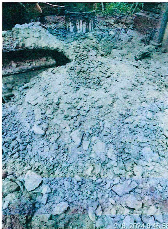
Obr. 2 Vývrtek – slínovec pevnosti R5 až R4
