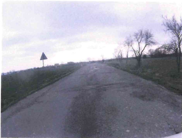
Hl. koroze, podélné a příčné trhliny, vysprávkky, deformace
