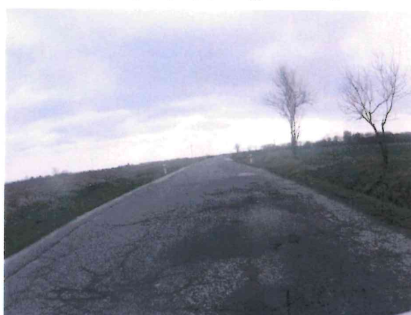
Hl. koroze, vysprávký, mozaikové trhliny, výtluky
