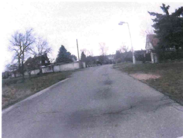
Hl. koroze, mozaikové trhliny, zvýšené nezp. krajnice
