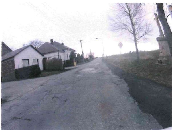
Hl. koroze, vysprávký, mozaikové trhliny, výtluky
