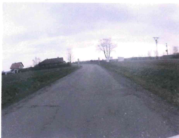
Hl. koroze, příčné trhliny, vysprávkky
