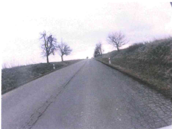
Hl. koroze, podélné rozv. a síťové trhliny, deformace
