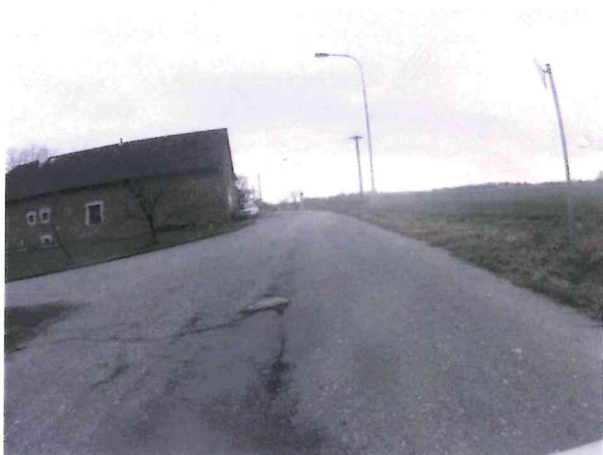
Hl. koroze, vysprávký, podélné a příčné trhliny, výtluky
