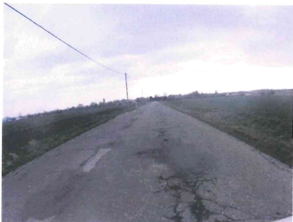
Hl. koroze, mozaikové trhliny, výtluky, nepravidelné hrboly
