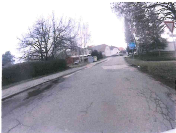
Hl. koroze, podélné rozv. trhliny, deformace, vysprávkky
