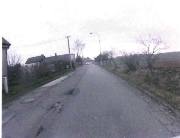
Hl. koroze, výtluky, vysprávký, síť. trhliny, deformace
