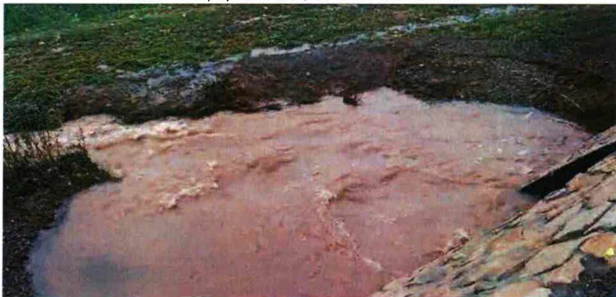
Foto č.2 – výtok propustku v km 2,225 – SO 103.1 z 15.9.2024
