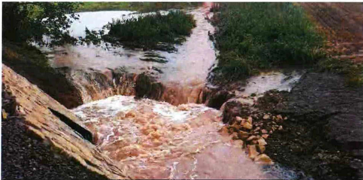
Foto č.1 – vtok propustku v km 2,225 – SO 103.1 z 15.9.2024
