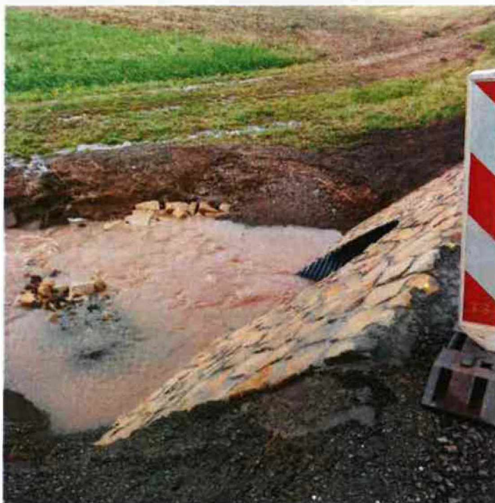
Foto č.8 – výtok propustku v km 2,225 – SO 103.1 z 16.9.2024
