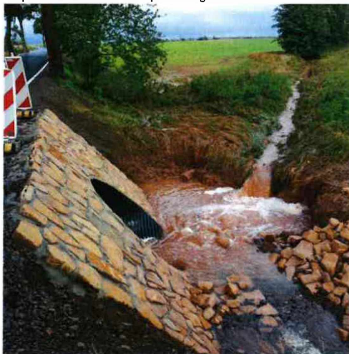
Foto č.7 – vtok propustku v km 2,225 – SO 103.1 z 16.9.2024
