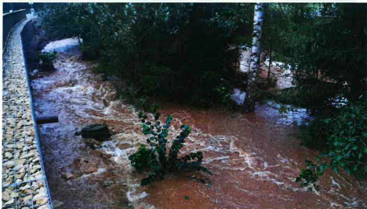
Foto č.6 – pohled na tok Černého potoka z gabionové zdi – SO 251 z 15.9.2024
