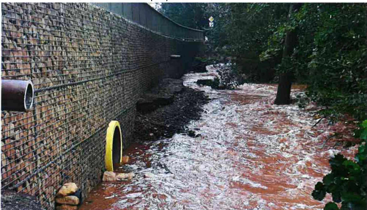
Foto č.5 – pohled na gabionovou zeď, výtok propustku – SO 251 z 15.9.2024
