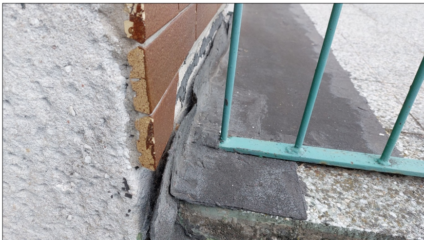
Obr.8: Netěsná dilatační spára mezi terasou a objektem
