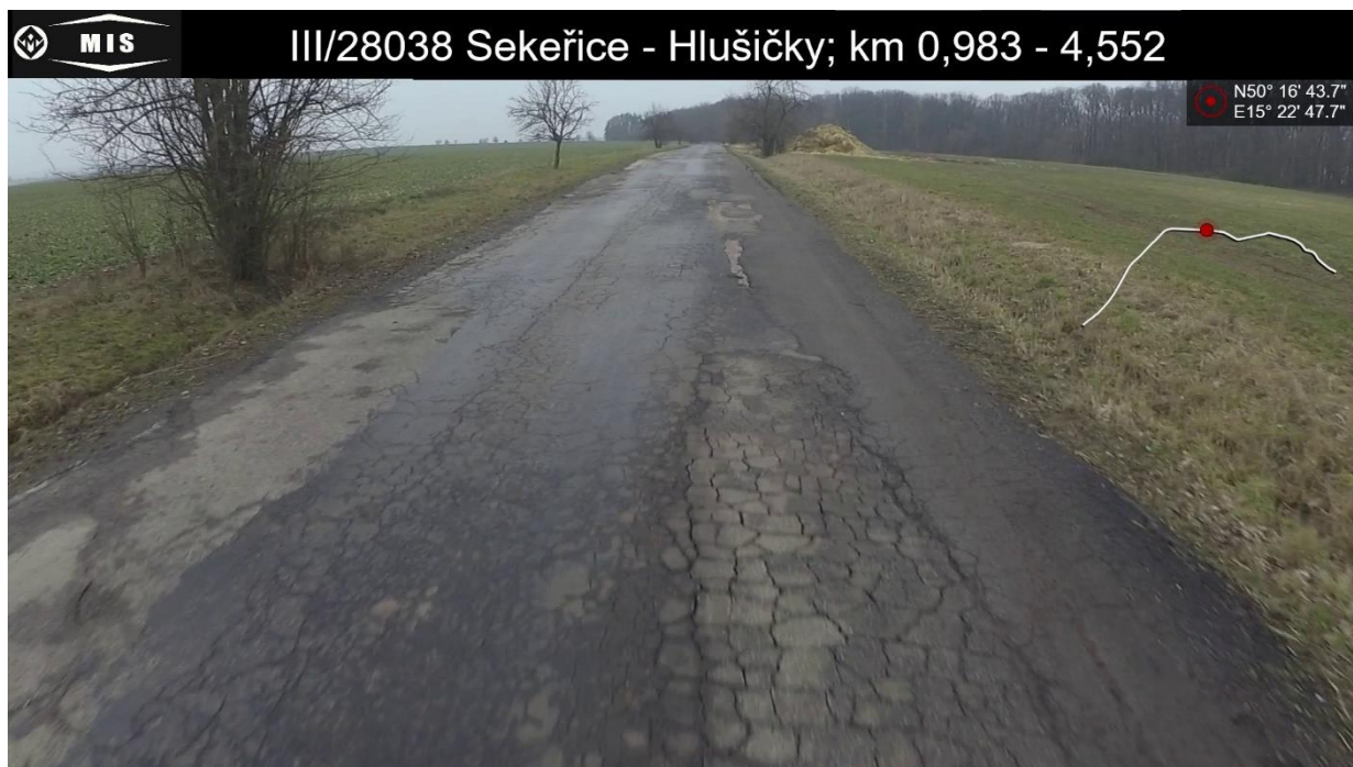
17 síťové trhliny
