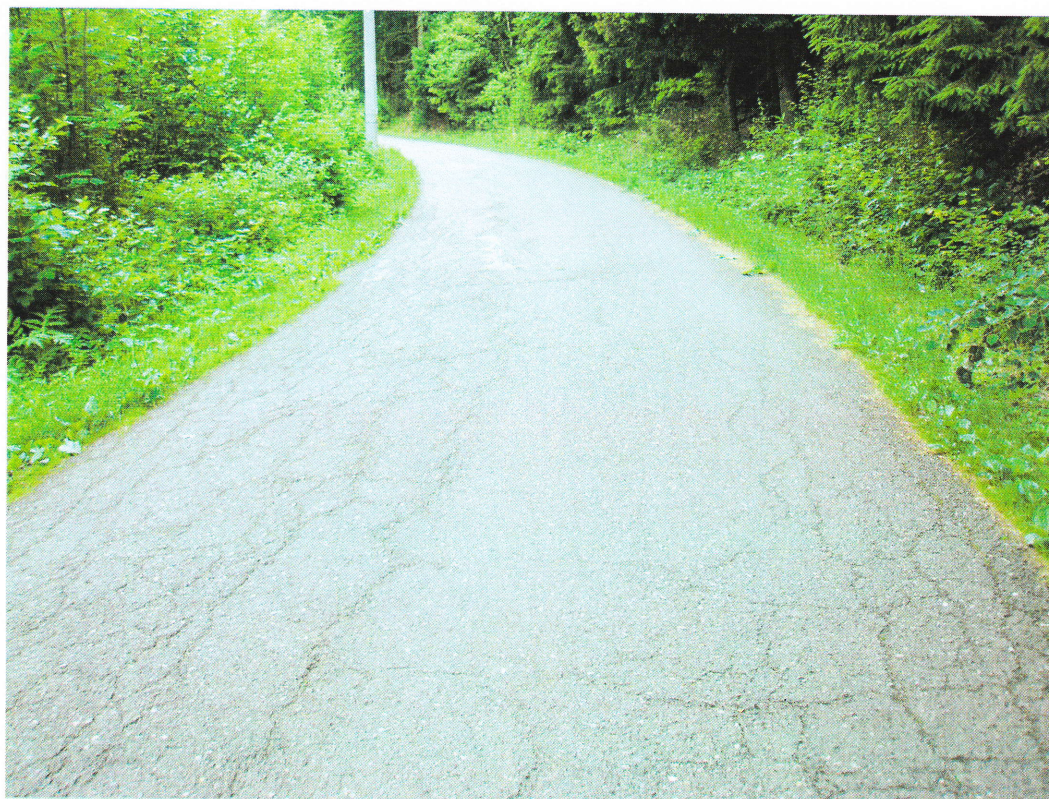
Foto č. 6 – km 0,750, síťové trhliny, koroze povrchu
