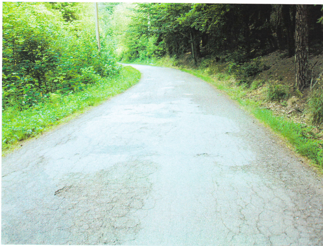
Foto č. 7 – km 0,900, trhliny hloubková koroze, špatné odvodnění
