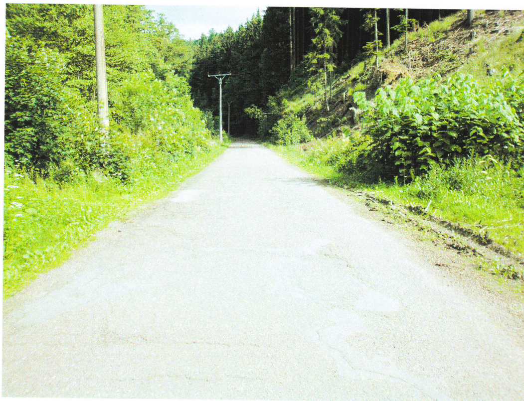
Foto č. 4 – km 0,600, změna povrchu, koroze trhliny, výspravy
