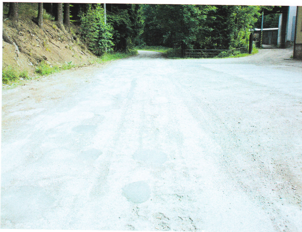
Foto č. 3 – km 0,450, hloubková koroze, výspravy
