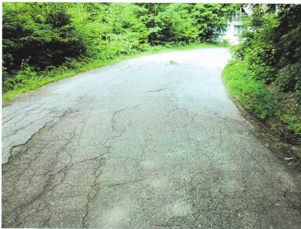
Foto č. 9 – km 1,250, koroze, výspravy, síťové trhliny
