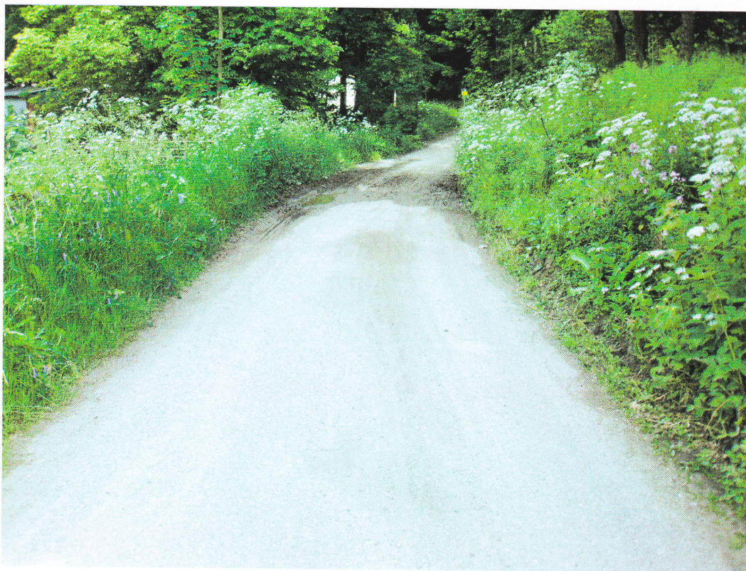
Foto č. 11 – km 1,740, nejužší část vozovky, neúnosná konstrukce
