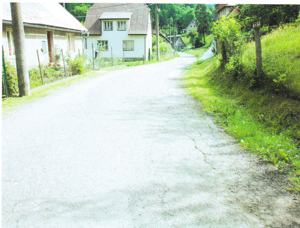
Foto č. 10 – km 0,550, koroze, síťové trhliny, výspravy
