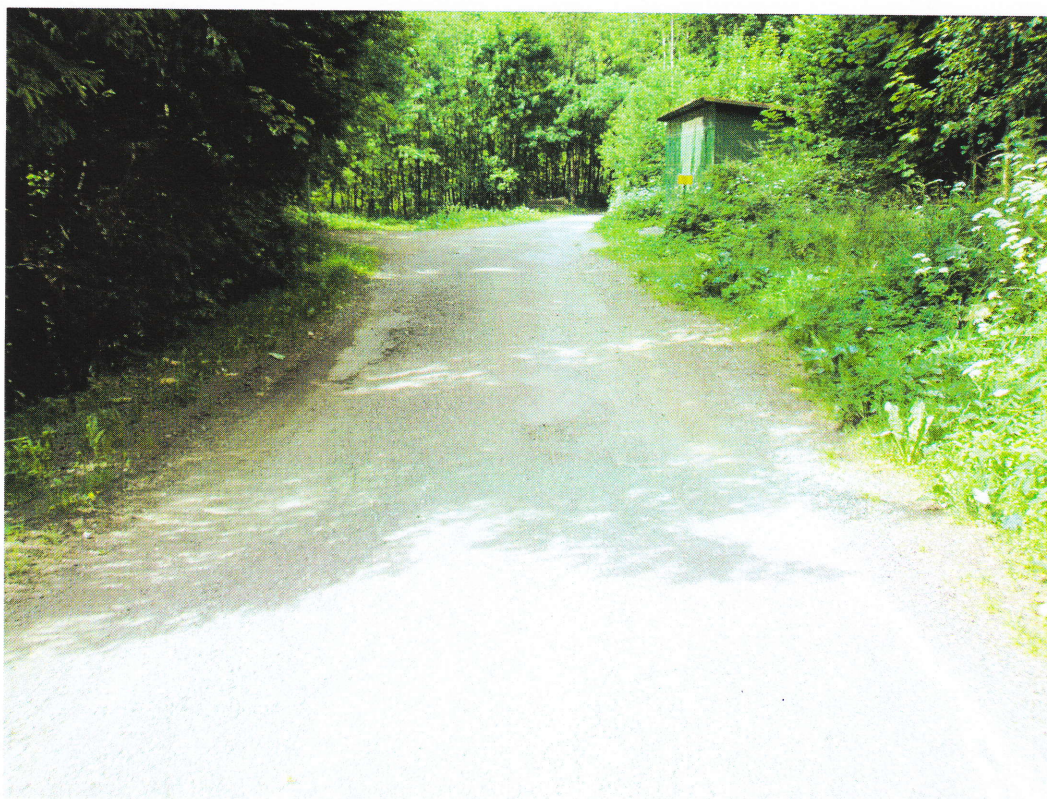
Foto č. 8 – km 1,150, koroze, výspravy, špatné odvodnění
