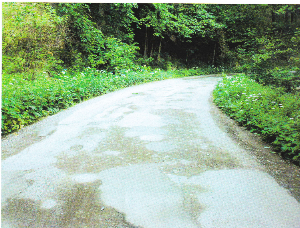
Foto č. 2 – km 0,250, vozovka porušena hloubkovou korozí, výpravami, nerovnostmi
