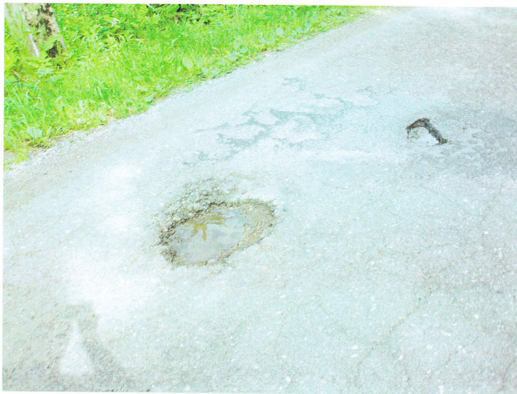
Foto č. 5 – km 0,661, výtluky, trhliny
