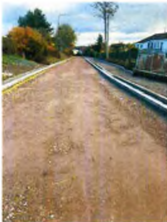
Pokládka II. vrstvy ŠD 0/32 v tl. 0,15 m – rovnání pod ACP 22 S
