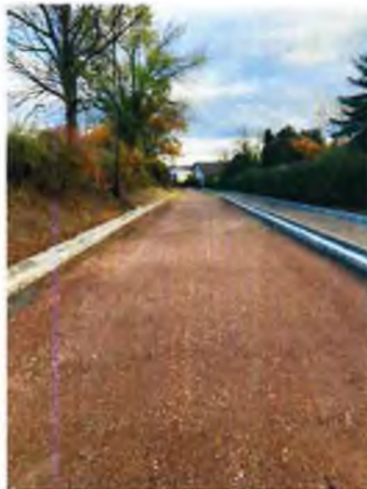
Pokládka II. vrstvy ŠD 0/32 v tl. 0,15 m – rovnání pod ACP 22 S
