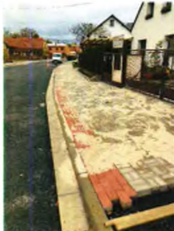
Pokládka zámkové dlažby
