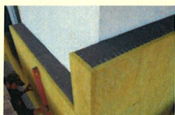
Příklad řešení detailu vazby rohu budovy pomocí rohové desky Isover TWINNER
