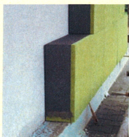
Požární oddělení plochy zateplení od tepelné izolace soklu pomocí zakládací desky Isover TWINNER
