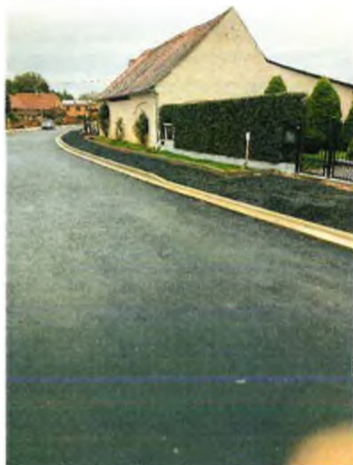
Pokládka ložní vrstvy ACL 16 S v tl. 60 mm
