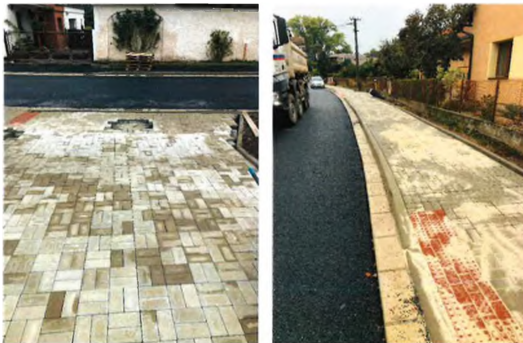
Pokládka zámkové dlažby
