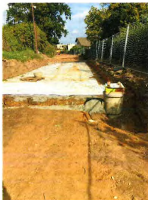
Odkop do úrovně parapláně
