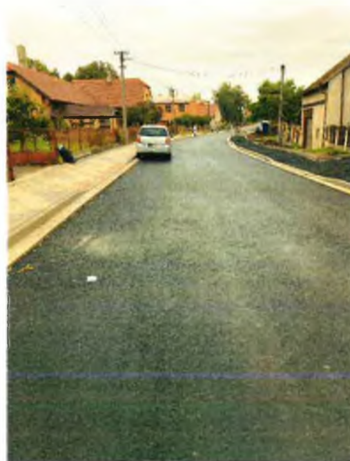
Pokládka ložní vrstvy ACL 16 S v tl. 60 mm
