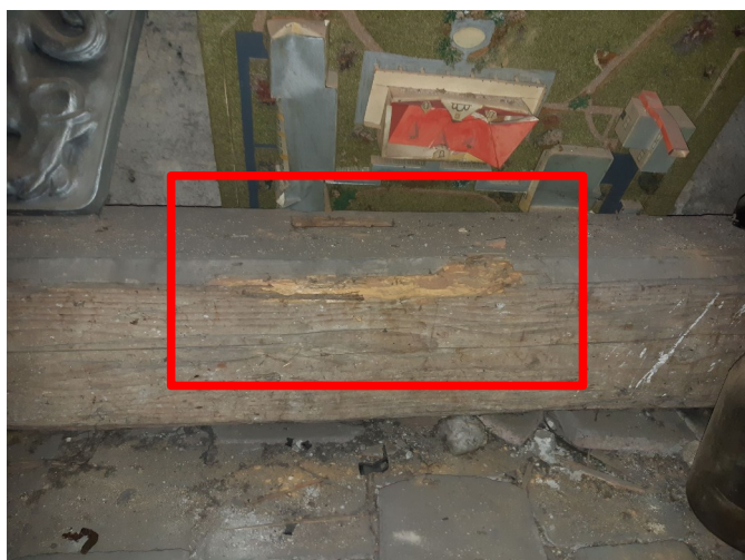
foto/51/ Místo F9 se stopami po biotickém napadení
