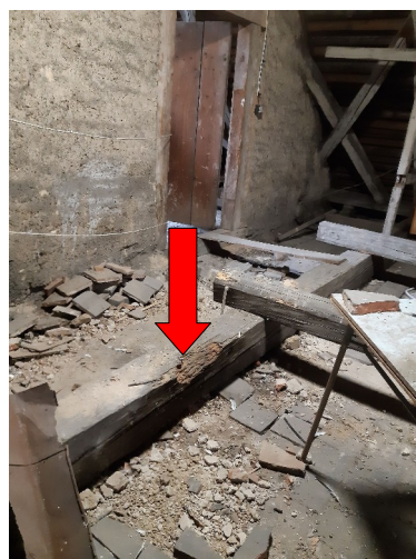
foto/46/ Místo F4 se stopami po biotickém napadení
