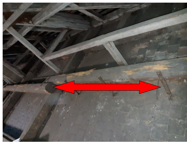
foto/48/ Místo F6 se stopami po biotickém napadení
