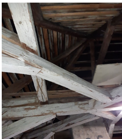
foto/53/ Místo F11 se stopami po působení vlhkosti
