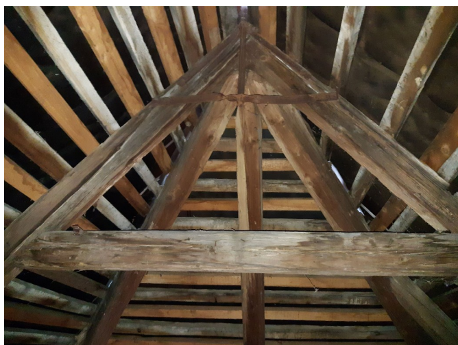
foto/52/ Místo F10 se stopami po působení vlhkosti
