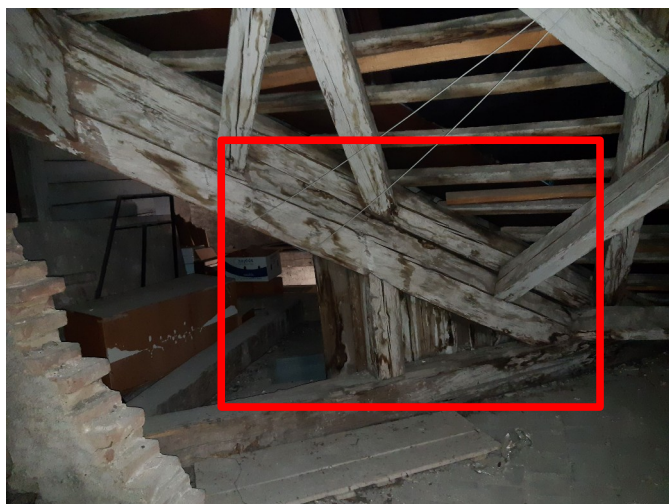
foto/49/ Místo F7 se stopami po působení vlhkosti
