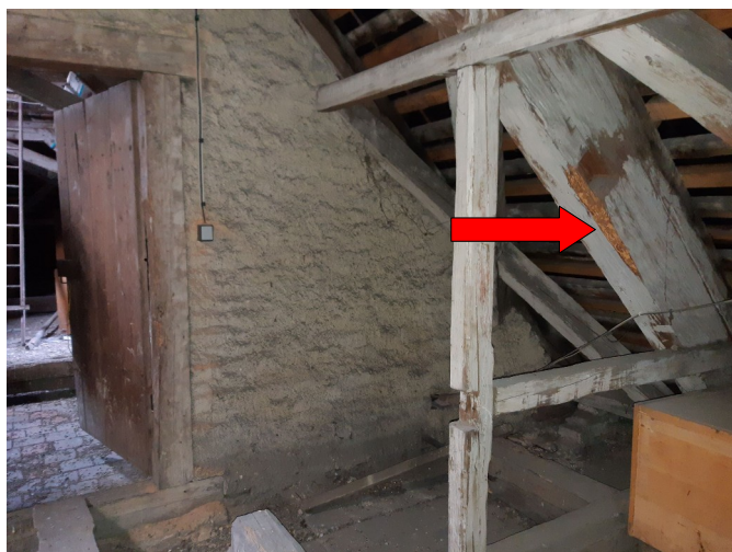
foto/50/ Místo F8 se stopami po biotickém napadení
