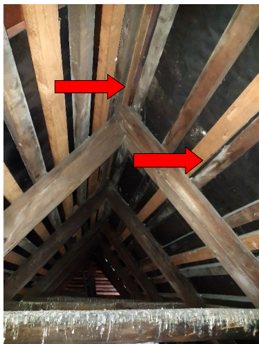
foto/43/ Místo F1 se stopami po působení vlhkosti
