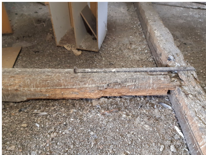
foto/44/ Místo F2 se stopami po biotickém napadení
