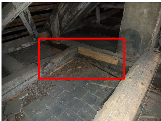
foto/47/ Místo F5 se stopami po biotickém napadení
