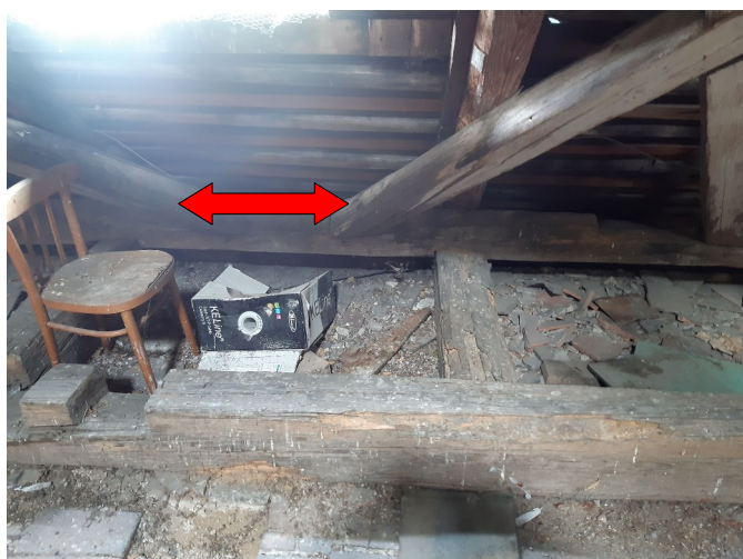
foto/45/ Místo F3 se stopami po působení vlhkosti
