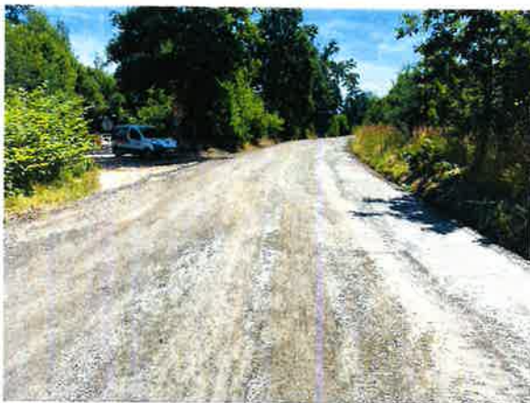
SO 103 - III/29827 – provedená RS po SC v místě
