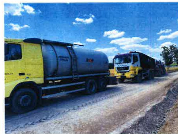
SO 103 - III/29827 – realizace RS po provedení SC v místě
