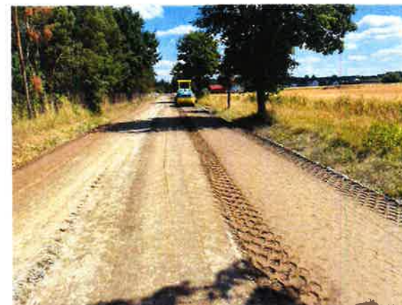
SO 103 - III/29827 – hutnění RS před rovnáním
