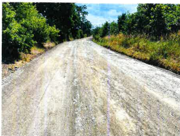
SO 103 - III/29827 – provedená RS po SC v místě
