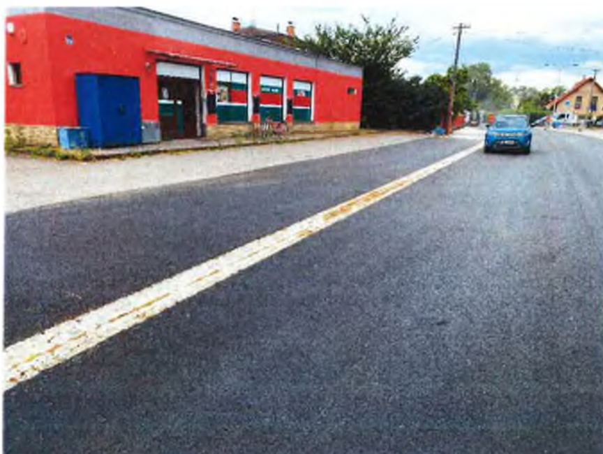
SO 104 - III/29827 – položená obrusná asf. vrstva ACO 11+
