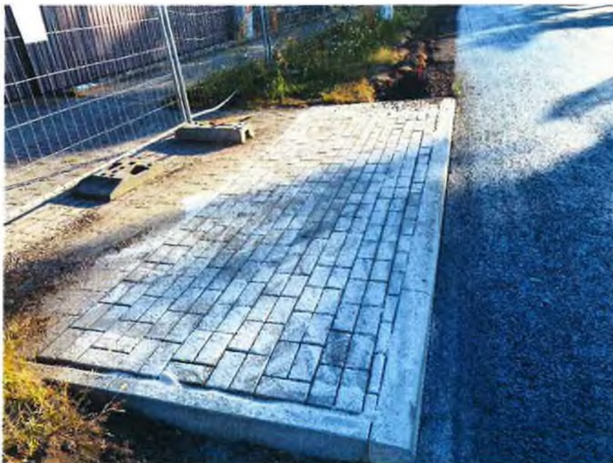
SO 104 - III/29827 – položená zámková betonová dlažba ve vjezdech
