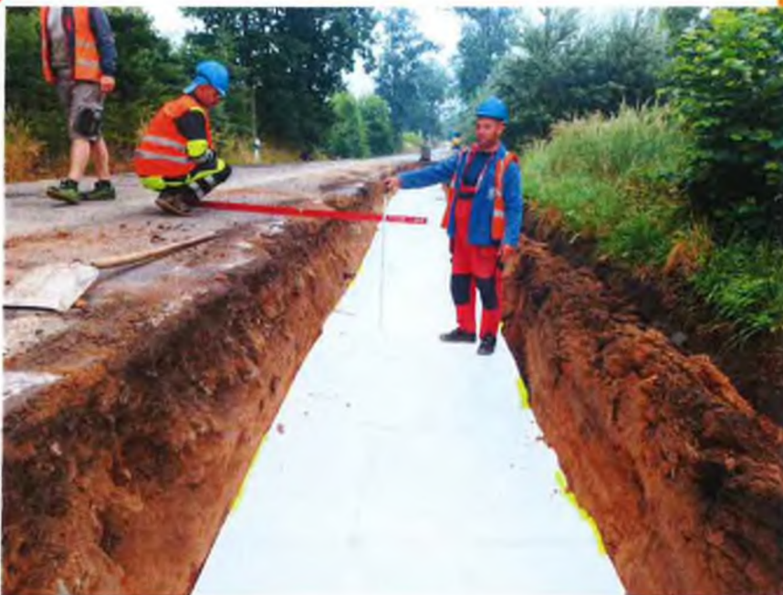
SO 103 - III/29827 – krajové sanace AZ – výkop na parapláň, geotextilie
