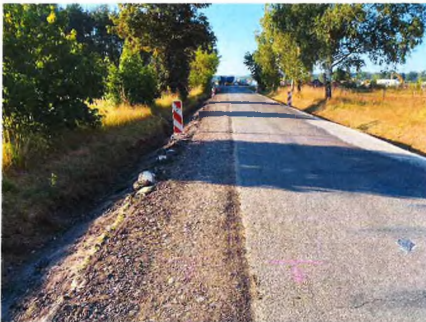
SO 103 - III/29827 – rozfrézování krajů pro sanace AZ
