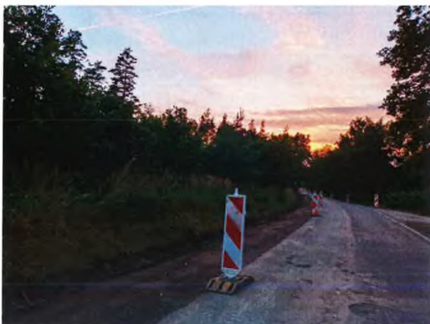
SO 103 - III/29827 – krajové sanace AZ – provedená sanace
