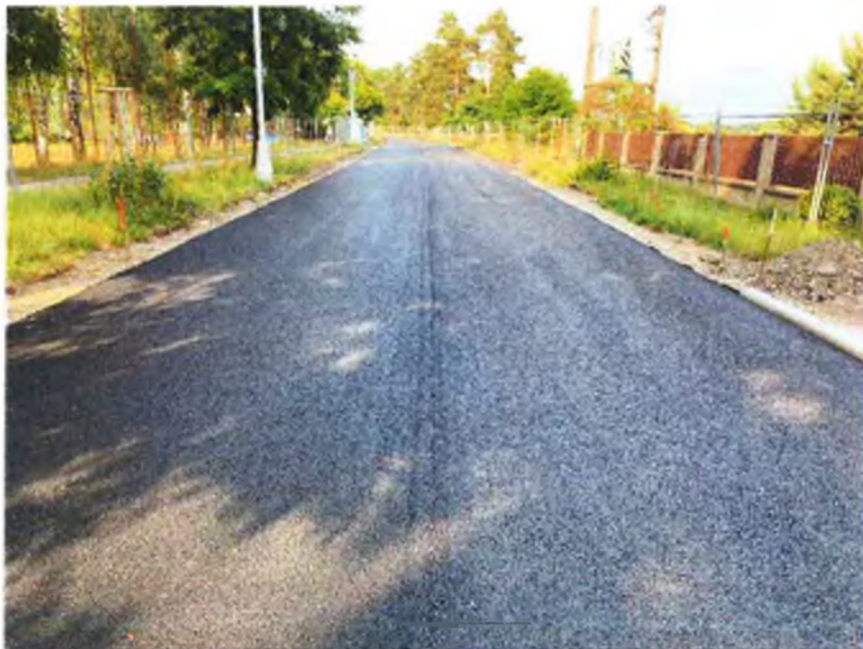
SO 104 - III/29827 – položená ložná asf. vrstva ACP 16+
