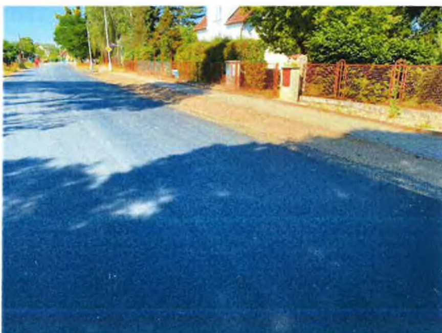
SO 104 - III/29827 – položená obrusná asf. vrstva ACO 11+ a doplněné krajnice REC., terénní úpravy
