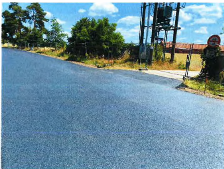
SO 104 - III/29827 – položená obrusná asf. vrstva ACO 11+
