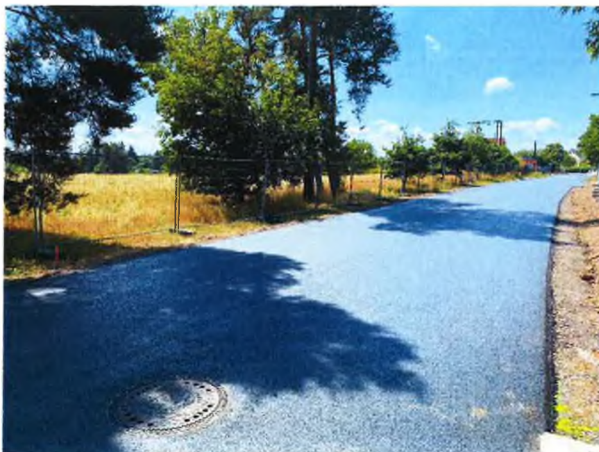
SO 104 - III/29827 – položená obrusná asf. vrstva ACO 11+
