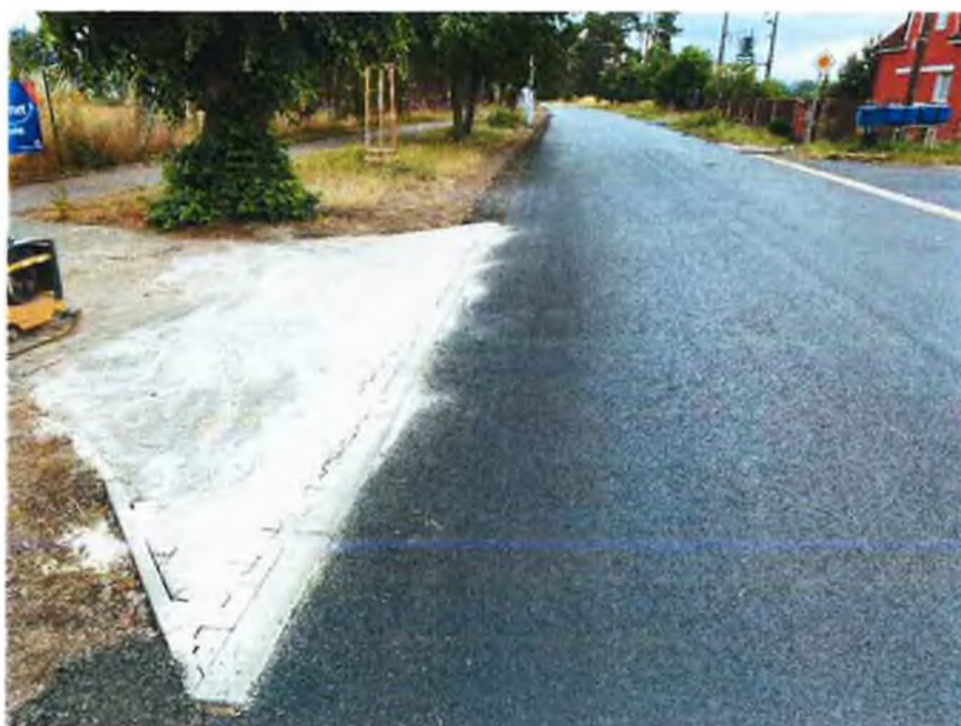
SO 104 - III/29827 – pískování a hutnění dlážděných vjezdů
