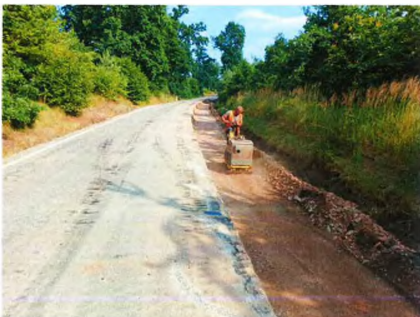
SO 103 - III/29827 – krajové sanace AZ – zásyp sanace ŠD+hutnění
