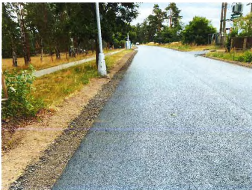
SO 104 - III/29827 – položená obrusná asf. vrstva ACO 11+ a doplněné krajnice REC., terénní úpravy
