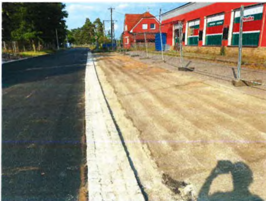
SO 104 - III/29827 – připravené parkoviště na pokládku ACO 11+
