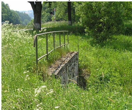
Obr.1 Stávající stav výtokového čela propustku
