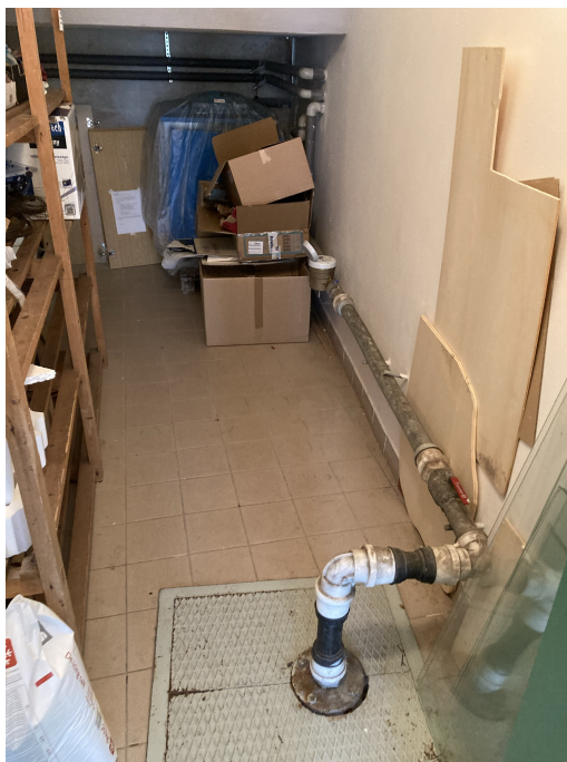
Stávající vodovodní přípojka a vodoměr uvnitř objektu.
