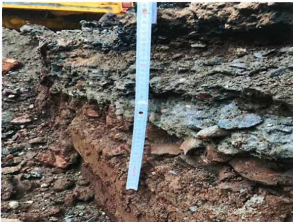
Úsek č.7- zesílená vrstva SC na konstrukci ŠD bez sanace
