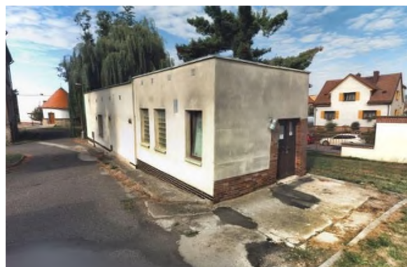
Obrázek č. 2: Objekt ČOV
