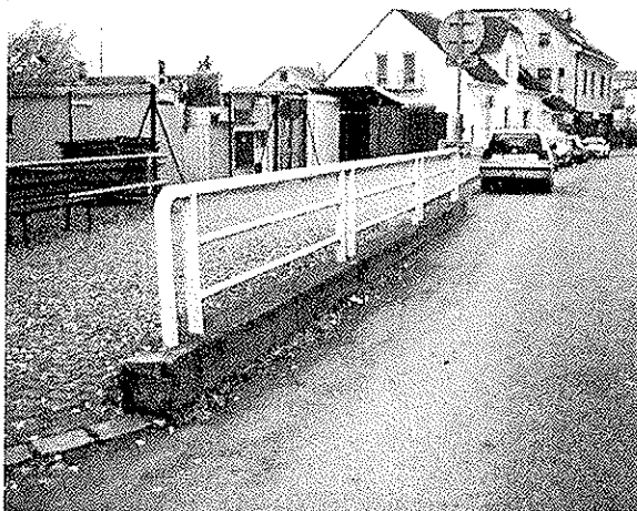
levá strana mostu
