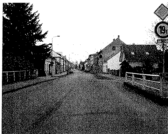
pohled proti směru staničení
