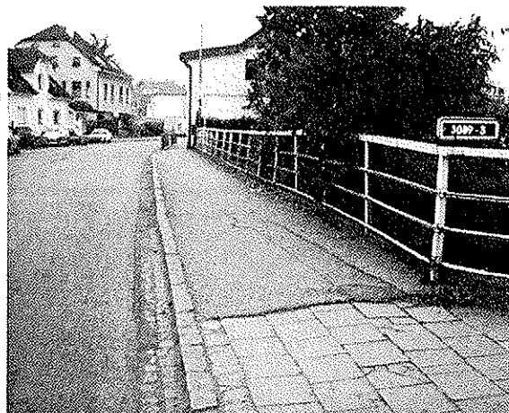
pravá strana mostu
