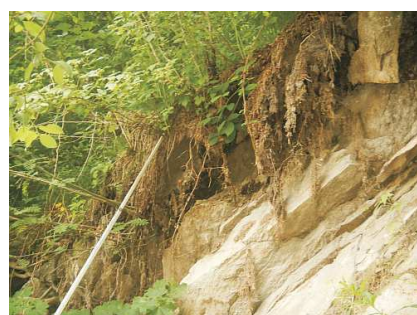
rozvolněná horní hrana skalního svahu nad prostorem skalního řízení
