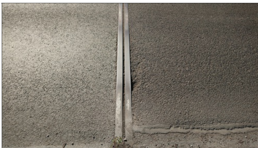
Degradace ohrusné vrstvy v okolí MZ.jpg
