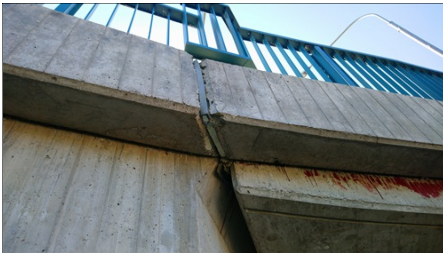
Dilatace v římse vlevo u O3 nedokonale probetonováno v okolí těsnícího profilu.jpg
