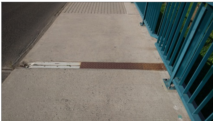
Koroze krycího plechu v chodníku u vlevo u O1.jpg
