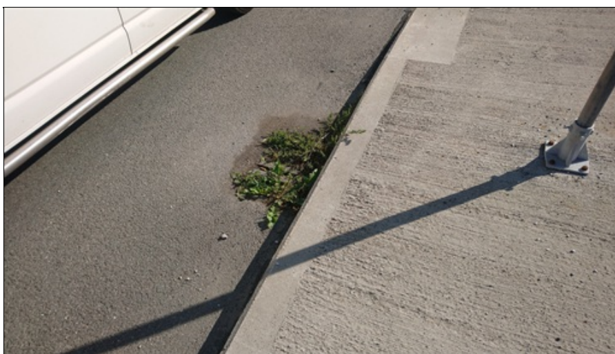
Zanesený odvodňovač na pravé straně mostu koroze kotevních prvků DZ.jpg
