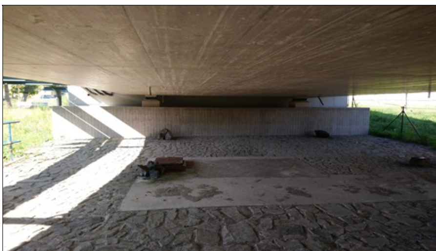
Úprava terénu pod mostem v prvním poli.jpg
