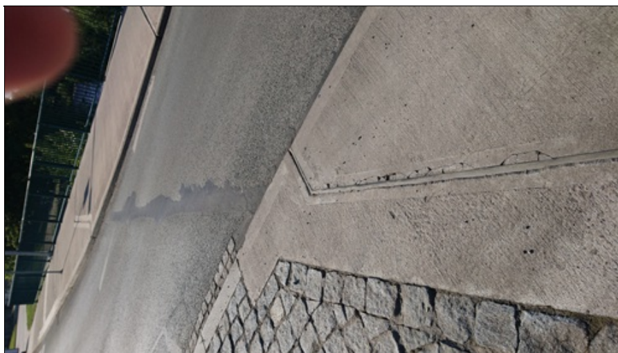
Dilatace na pravé straně u O3 olámané hrany středového prstence vymačkáný elastický závěr.jpg
