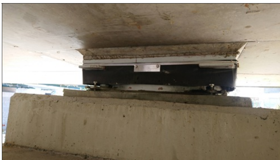
Ložisko na pilíři P2 ponechané montážní šrouby poškozená PKO.jpg
