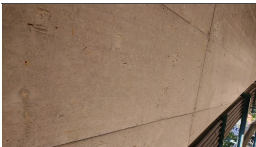
Podhled NK nevyčištěné bednění od vazacích drátků.jpg
