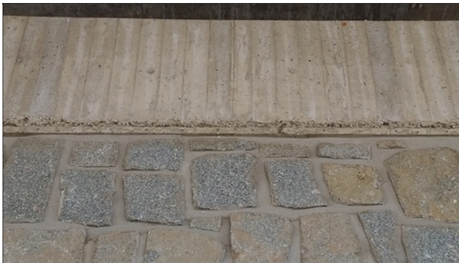
Nedokonale probetonovaná hrana uložného prahu na O3.jpg
