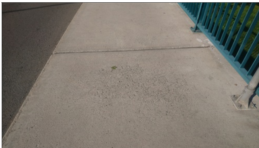
Degradace povrchu betonu chodníkové římsy včetně obrubníkové části.jpg
