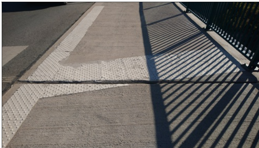
Poškozené hmatové prvky na pravé straně mostu.jpg
