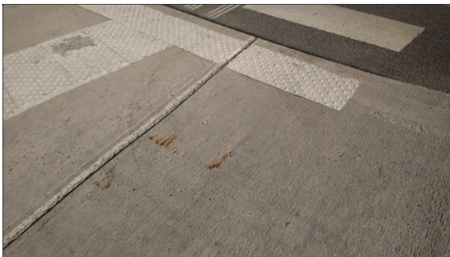
Poškozené hmatové prvky degradace povrchu římsy nedostatečné krytí podélné výztuže římsy.jpg
