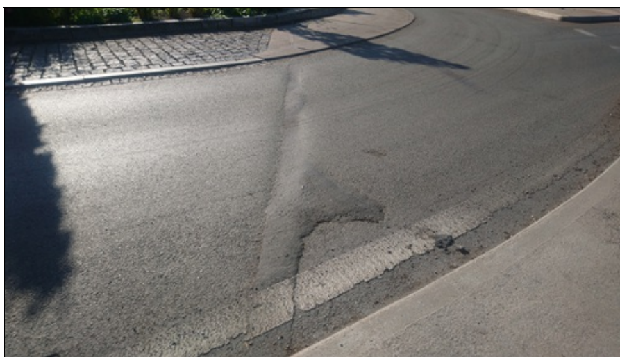
vyježděný elastický mostní závěr u O3 vlevo.jpg
