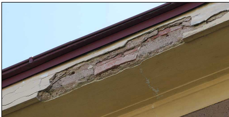
Narušená omítka v místě po- škozeného okapu.
