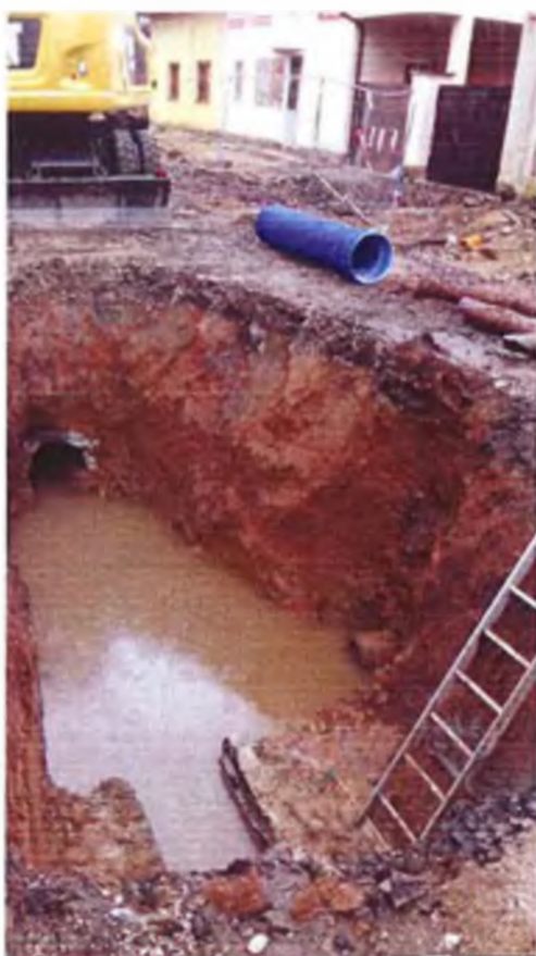
Otevřený výkop na poruše kanalizačního sběrače
