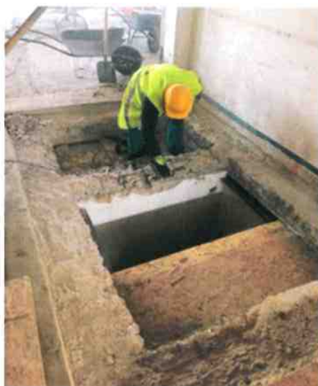
PŘÍLOHA Č.2 - Zajišťovací provizorní konstrukce uvnitř výtahových šachet provedena na pokyn TDI
