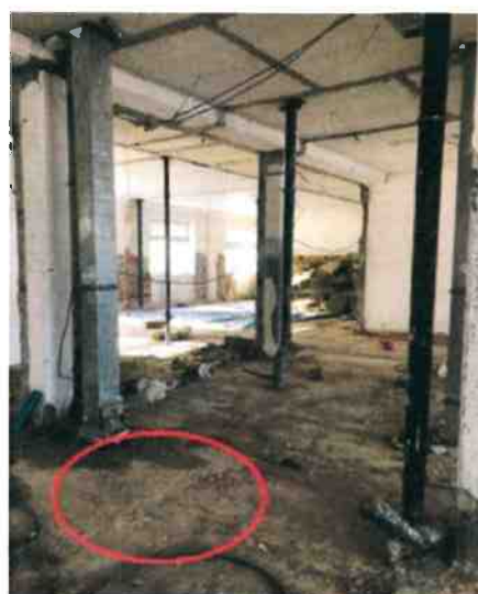
PŘÍLOHA Č.2 - ODSTRANĚNÍ NÁLITKŮ (provedeno dočištění hrany stávající podlahy, aby bylo možné provést navazující skladby podlah v jedné rovině)
