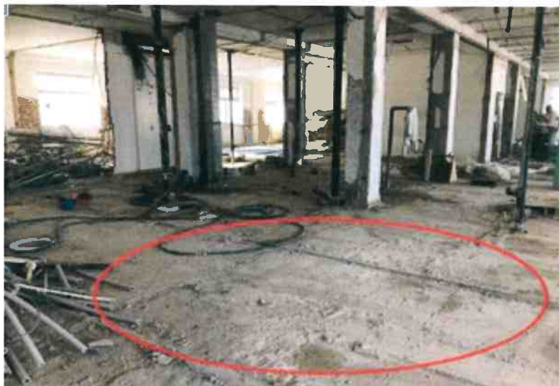
PŘÍLOHA Č.2 - ODSTRANĚNÍ NÁLITKŮ (provedeno dočištění hrany stávající podlahy, aby bylo možné provést navazující skladby podlah v jedné rovině)
