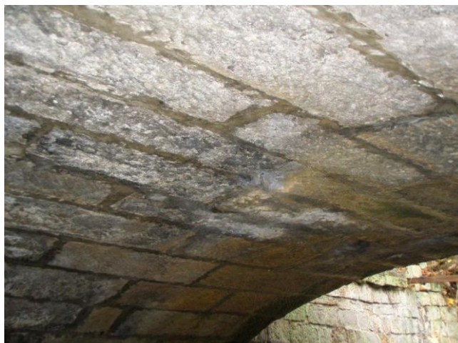
lokálně povrchově narušené kamenné kvádry ve vrcholu klenby
