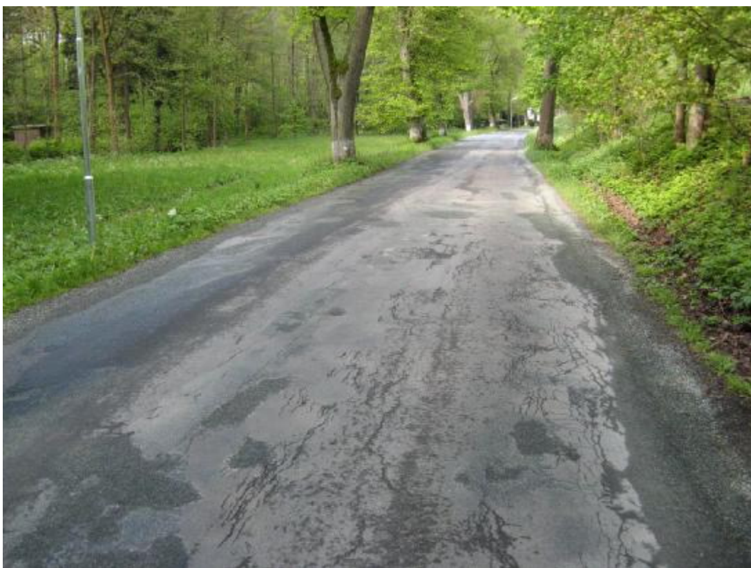
F28, km 7,810+ Síťové trhliny vpravo.
