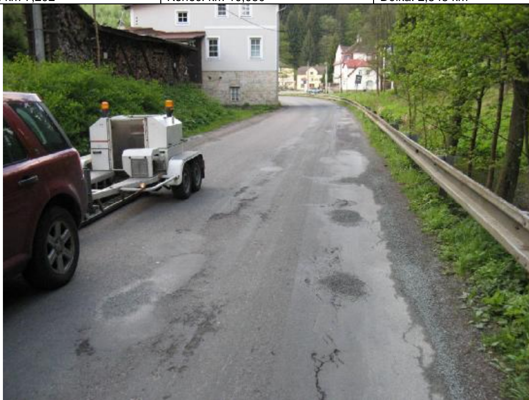
F57, km 8,850- Síťové trhliny podél okraje vozovky.
