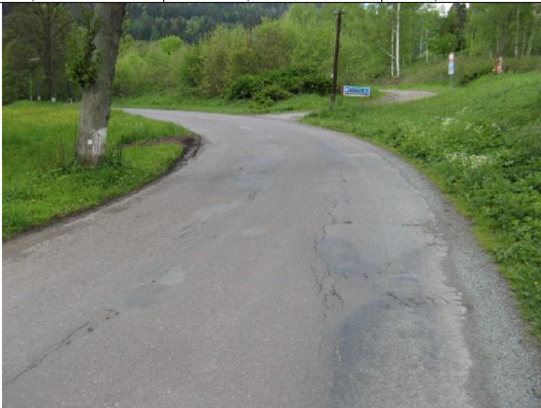
F13, km 7,460+ Síťové trhliny vpravo.
