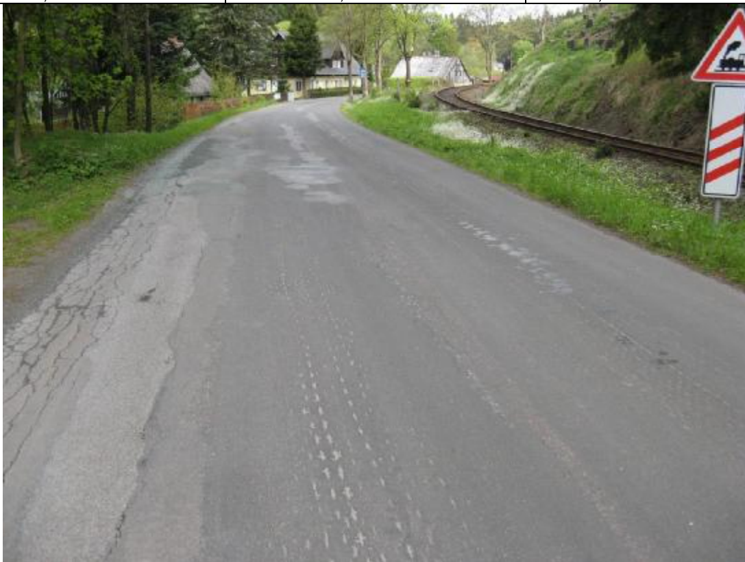
F75, km 9,810+ Vlevo síťové trhliny a vysrávky.
