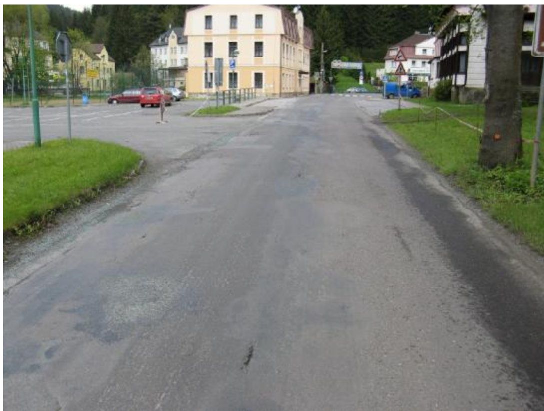
F48, km 8,560+ Vlevo síťové trhliny s vysprávkami.
