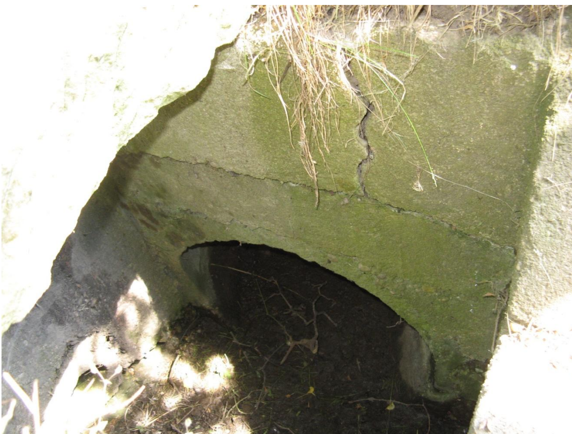
B3, km 0,525 L Čelo betonového propustku s trhlinami, propustek částečně zanesený.
