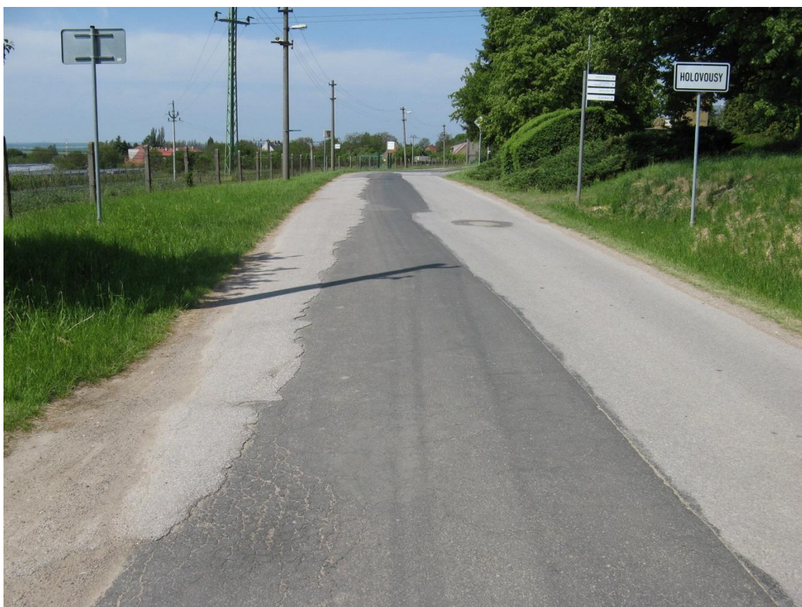
F18, km 4,310+ Vpravo je opravený povrch po pokládce kanalizace, vlevo původní povrch se sítovými trhlinami, výsprávkami podél okraje vozovky.
