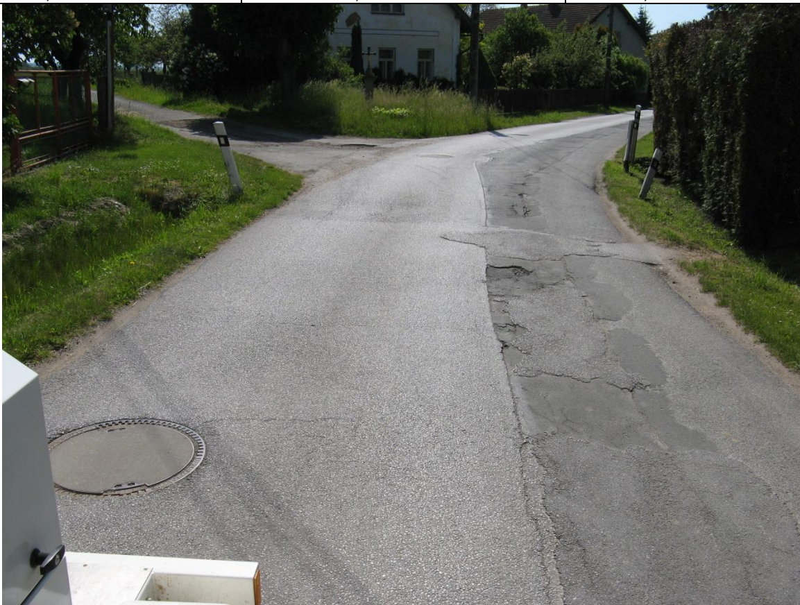
F25, km 0,550- Původní povrch s vysprávkami a opravený povrch po pokládce kanalizace.
