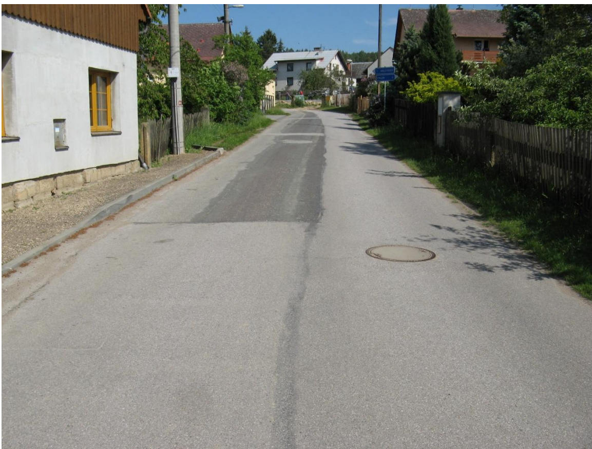
F30, km 0,660+ Původní povrch s vysprávkami a opravený povrch po pokládce kanalizace.
