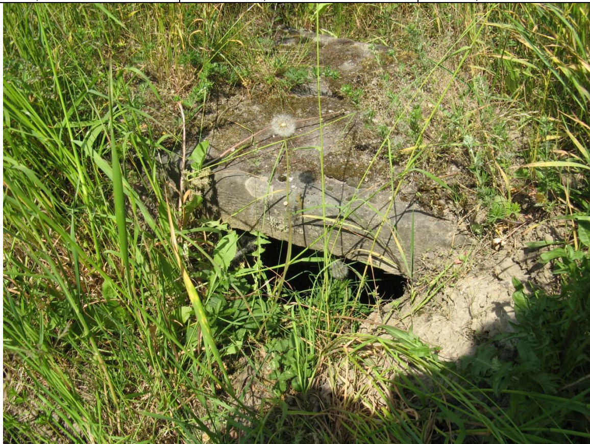
B5, km 0,525 P Betonový propustek s překladem.
