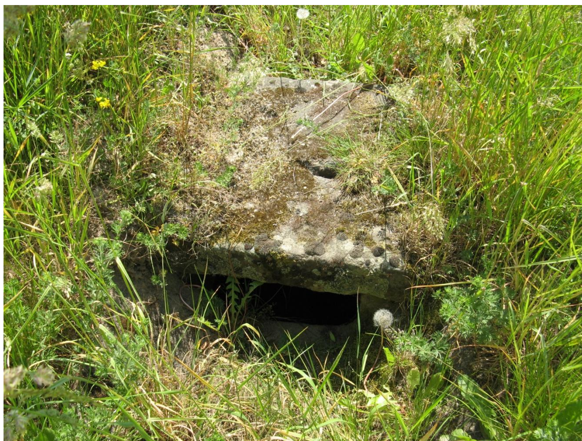
B6, km 0,525 P Betonový propustek s překladem.
