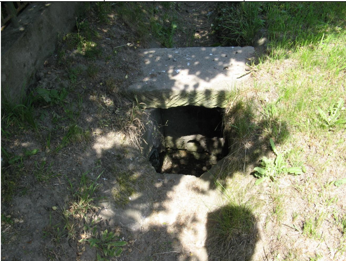
B1, km 0,525 L Betonový propustek s překladem.
