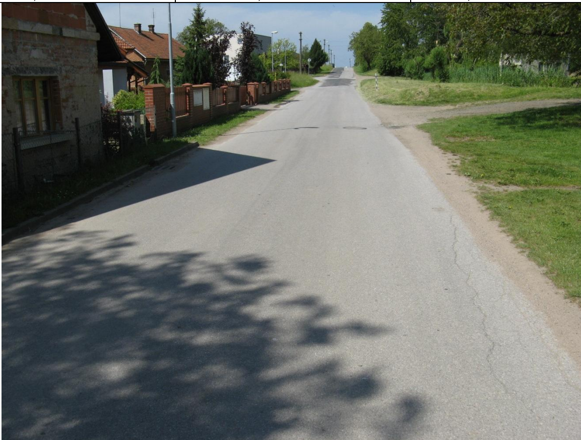
F10, km 4,110+ Celoplošně opravený povrch po pokládce kanalizace.
