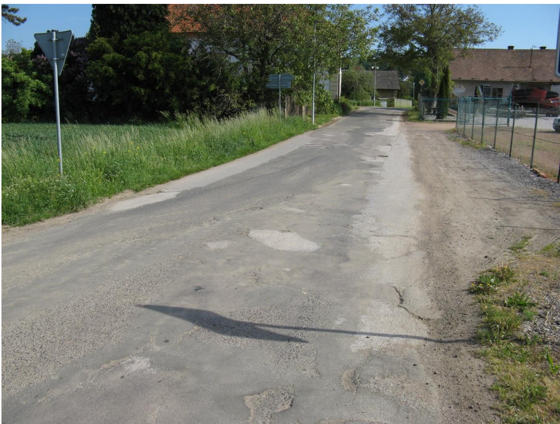
F01, km 0,010+ Hlubková koroze, vysprávký, nepravidelné hrboly, plošné deformace.
