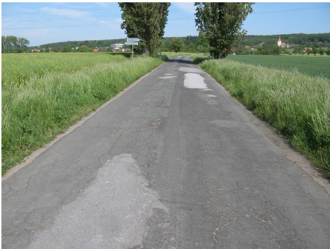
F05, km 0,060+ Hloubková koroze, síťové trhliny, vysprávkky, plošné deformace.
