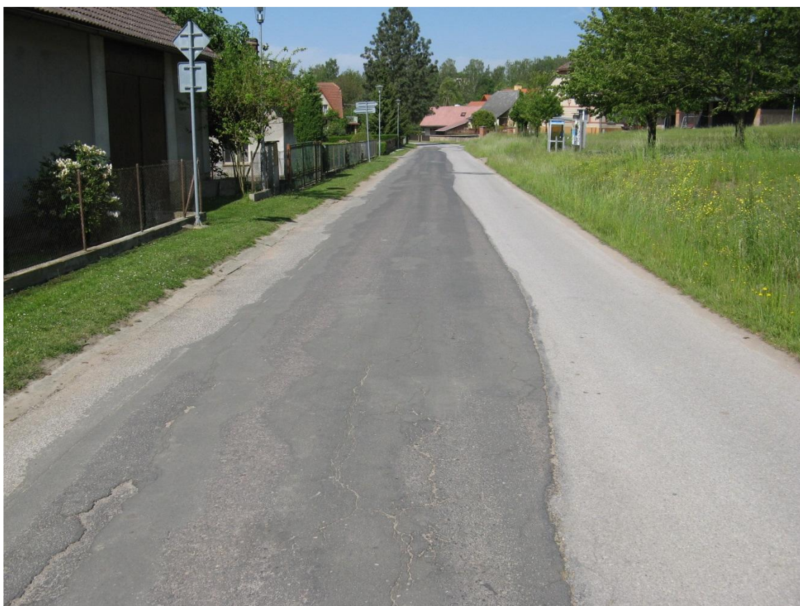
F04, km 3,960+ Vpravo je opravený povrch po pokládce kanalizace, vlevo původní povrch se síťovými trhlinami, výsypkami podél okraje vozovky.
