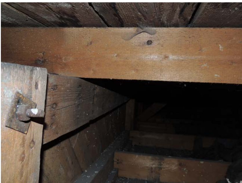
Pohled do prostoru střechy v oblasti 1. Dole jsou viditelné hranoly, nesoucí podhled, vlevo je vazník, nad ním hranoly, nesoucí pobití
