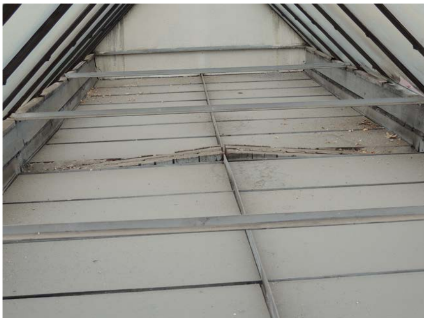
Pohled do světlíku v oblasti 1. Patrné je napojení dvou vazníků
