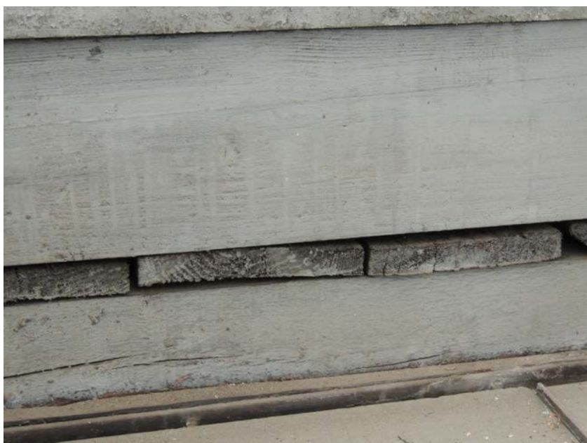
Detailní pohled na bok světlíku v oblasti 1. Odspodu jsou vidět trámy nad vazníky, prkna pobití a prkno boku světlíku
