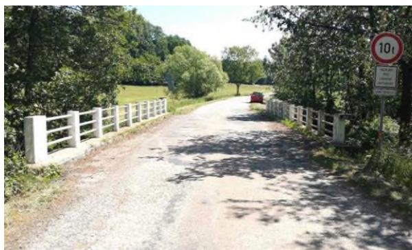
Pohled ve směru staničení
