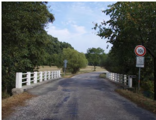
pohled ve směru staničení
