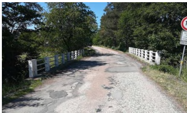
Pohled proti směru staničení
