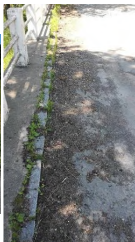
Nánosy nečistot s uchycenou vegetací na krajnici
