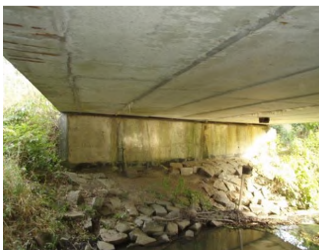
opěra na konci mostu
