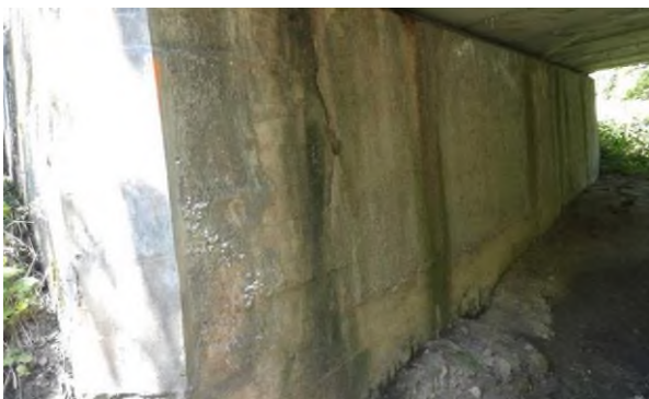
Opěra na začátku mostu
