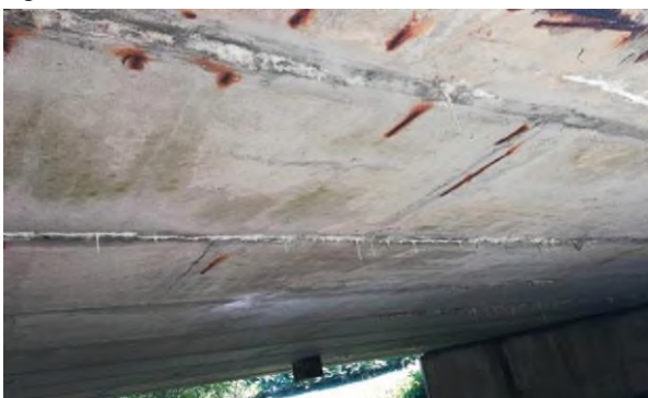
Podhled nosné konstrukce
