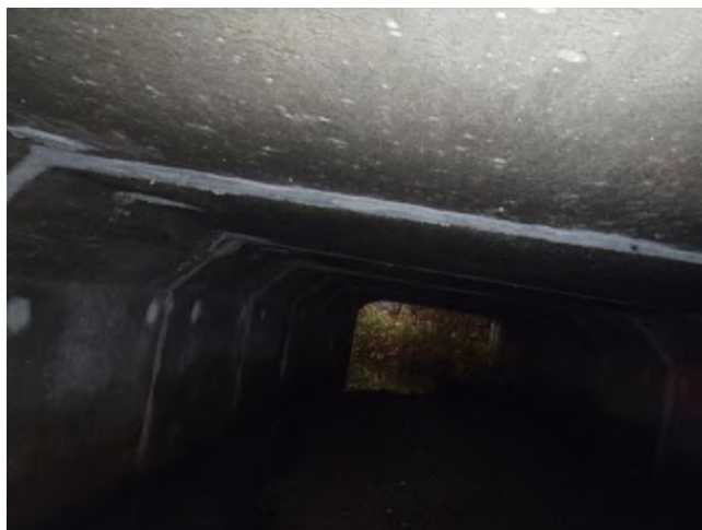
zapravené spáry mezi BR
