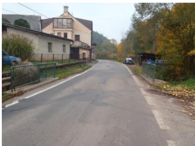
pohled ve směru staničení
