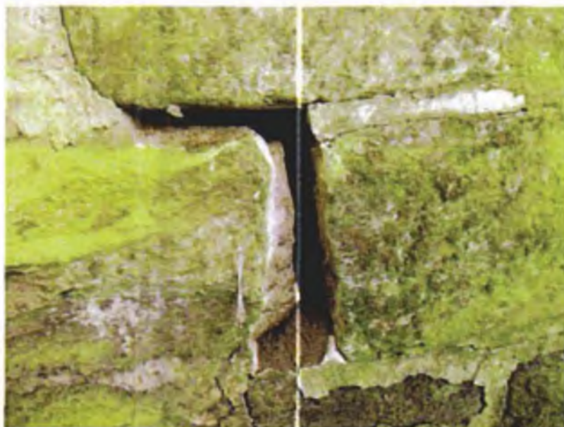
Vydrolená zdicí malta
