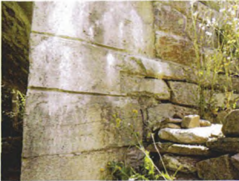
Betonové kvádry na levobřežní opěře na výtoku
