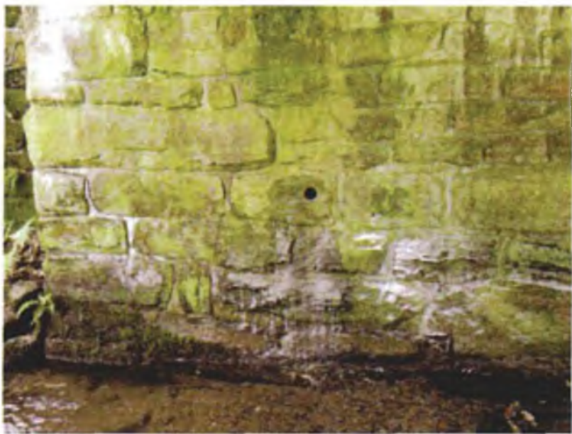
Levobřežní opěra s místem odběru vzorku kamene
