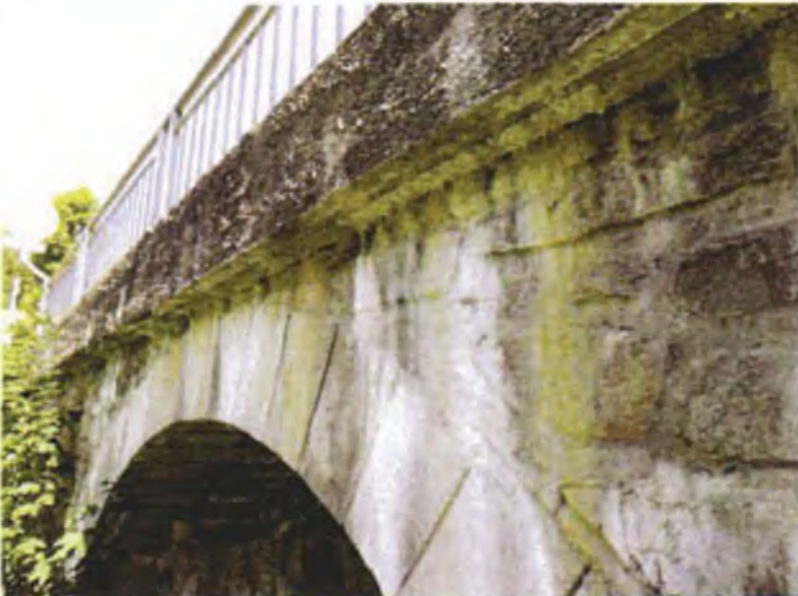
Římsa na výtokové straně mostu
