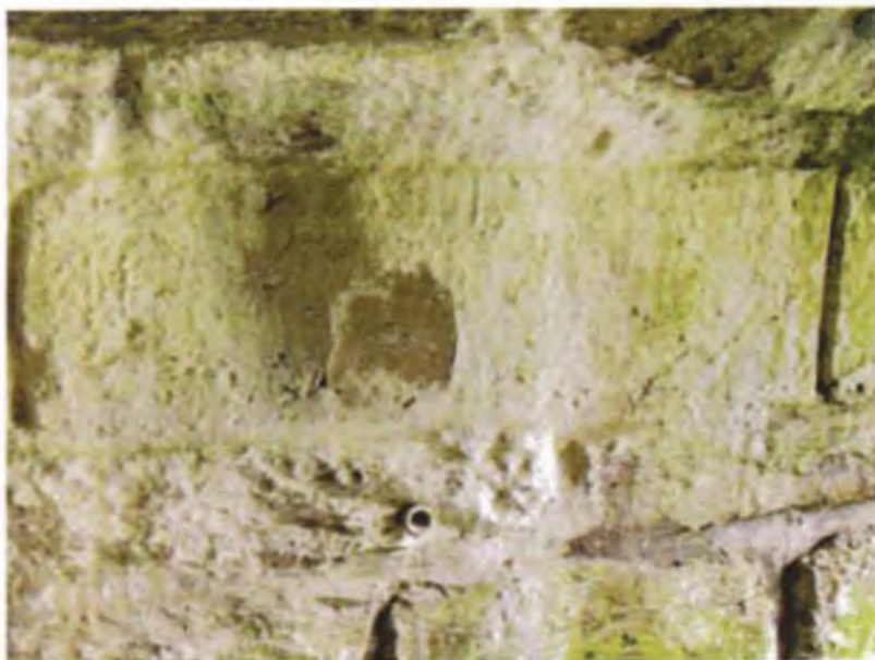
Jedno z míst nedestruktivních zkoušek pevnosti na pravobřežní opěře
