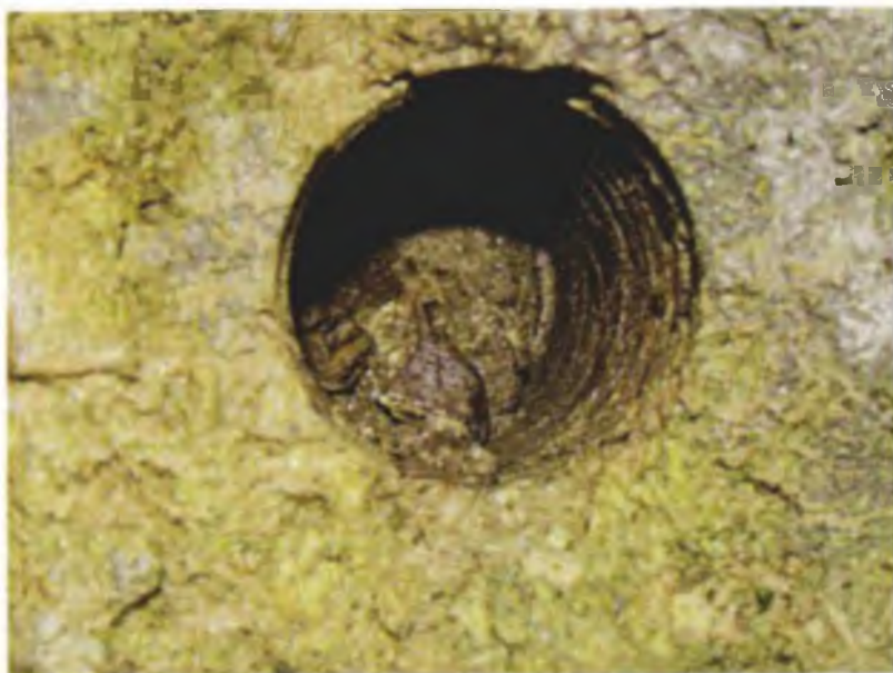
Pohled do otvoru po odebrání válcového vývrtu
