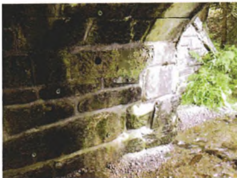
Pohled na místo odběru válcového vývrtu
