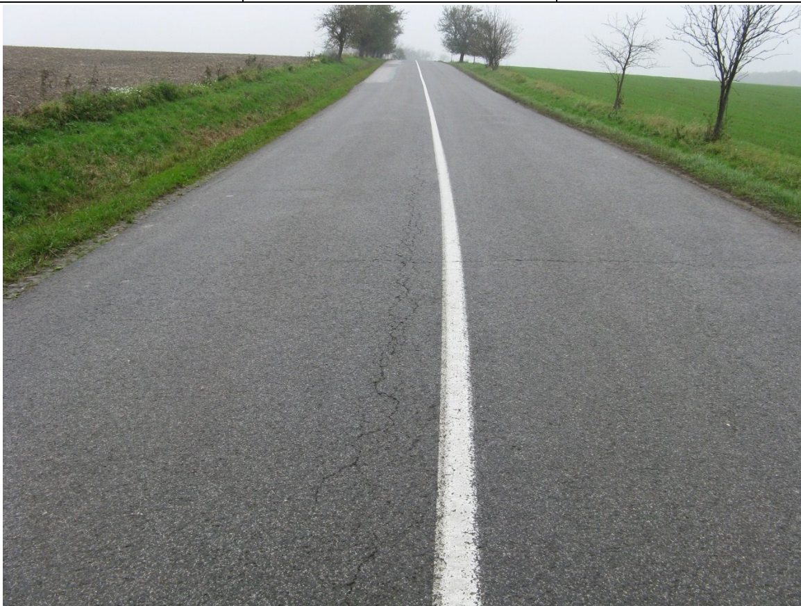
F57, km 6,410+ Mozaikové, příčné a podélné rozvětvené trhliny.
