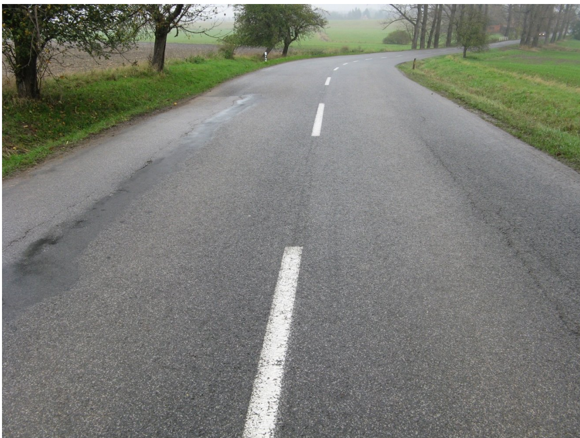
F61, km 6,810+ Vysprávký, mozaikové, podélné rozvětvené až síťové trhliny, zvýšená nezpevněná krajnice.
